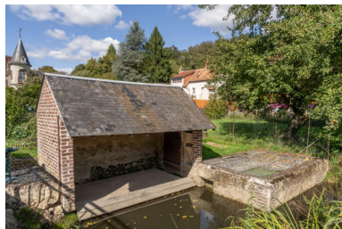
Vue d'ensemble. Phot. Jeanne Minier IVR52_20257200655NUCA
