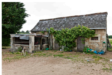
Petites dépendances de l'ancien moulin : toit à porcs. Phot. Yves Guillotin IVR52_20127201428NUCA
