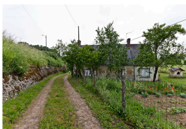
Chemin qui descend sous la chaussée de Risouy qui supporte aujourd'hui la route. Phot. Yves Guillotin IVR52_20127201429NUCA
