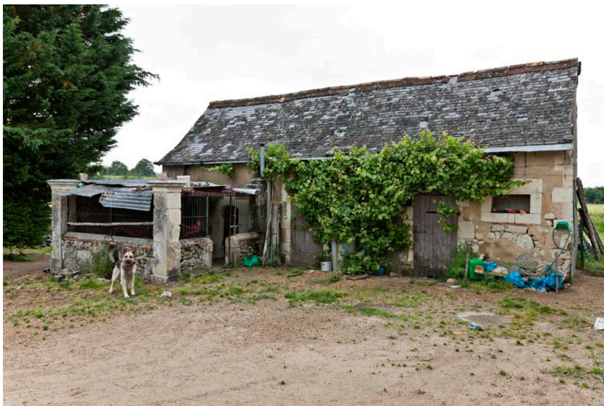
Petites dépendances de l'ancien moulin : toit à porcs.
