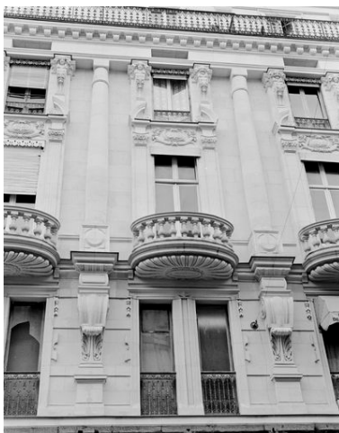
Façade principale, détail d'une travée : deuxième, troisième et quatrième niveaux. Phot. Patrice Giraud IVR52_19824901043X
