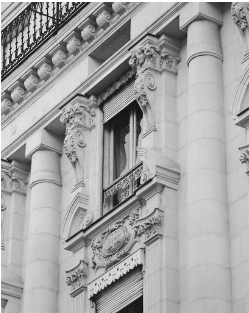
Elévation antérieure, 2ème travée à droite du pan coupé : plate-bande de la porte-fenêtre du 3ème niveau et fenêtre du 4ème niveau.
