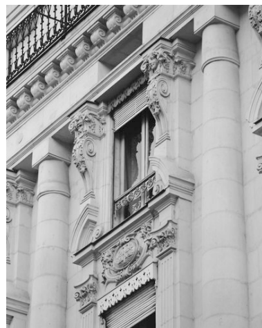
Elévation antérieure, 2ème travée à droite du pan coupé : plate- bande de la porte-fenêtre du 3ème niveau et fenêtre du 4ème niveau. Phot. François Lasa IVR52_19894901133X
