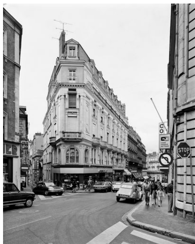
Ensemble sur rues. Phot. Patrice Giraud IVR52_19824901151V
