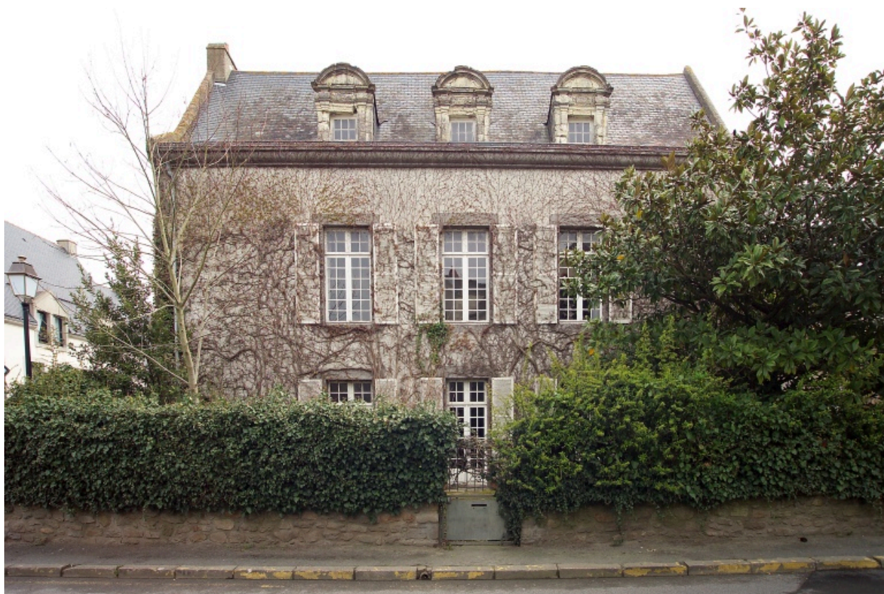
Façade principale vue vers l'Est.
