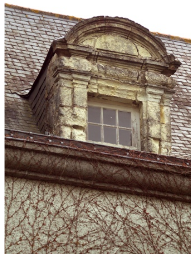
Facade principale, détail d'une lucarne. Phot. Denis Pillet IVR52_20074400418NUCA
