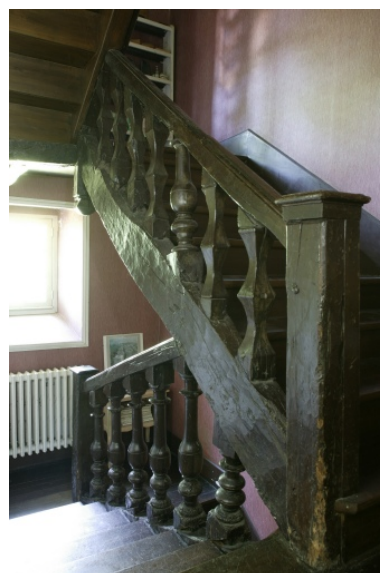
Escalier, vu depuis le palier du premier étage. Phot. Denis Pillet IVR52_20074401014NUCA
