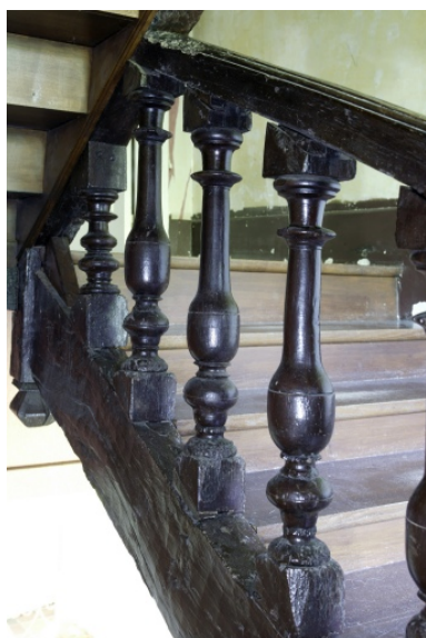
Escalier, détail des balustres avec cales entre le rez-de-chaussée et le premier étage.
