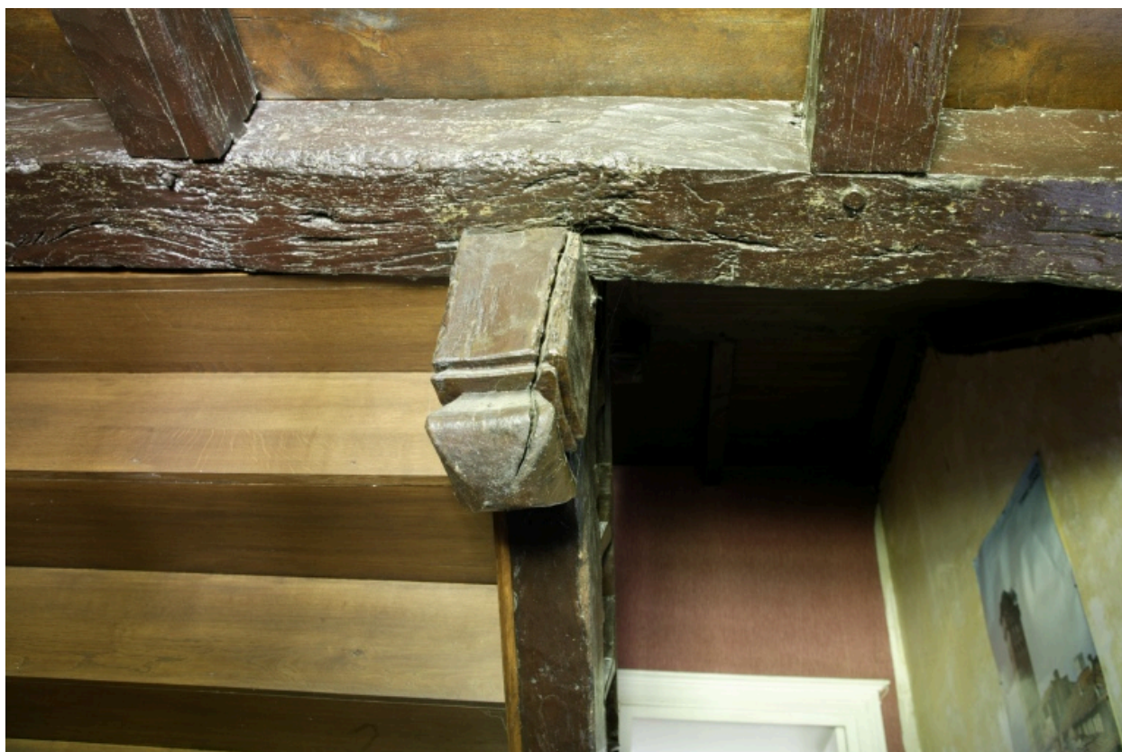
Escalier, détail d'un poinçon et des poutres portant un repos.
