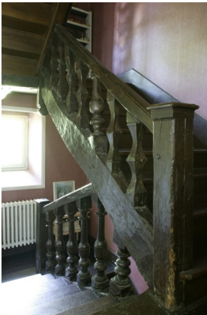
Escalier, vu depuis le palier du premier étage.
