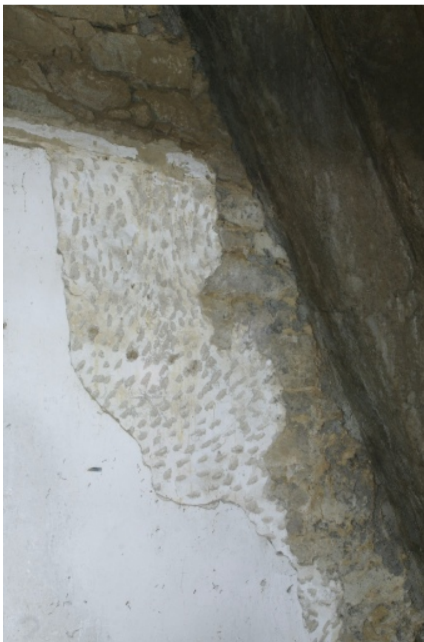
Comble,détail des couches successives d'enduit.
