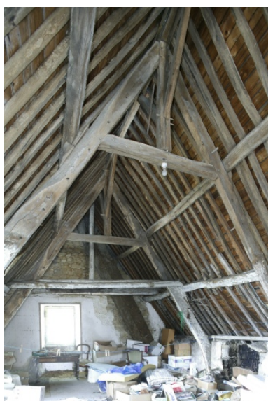
Charpente vue vers le Nord.
