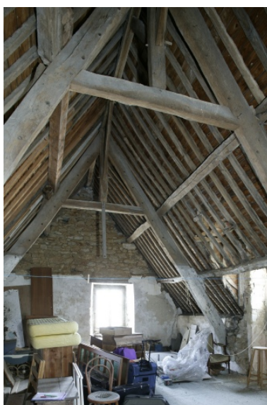
Charpente vue vers le Nord.
