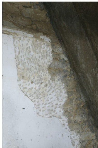
Comble, détail des couches successives d'enduit. Phot. Denis Pillet IVR52_20074401021NUCA
