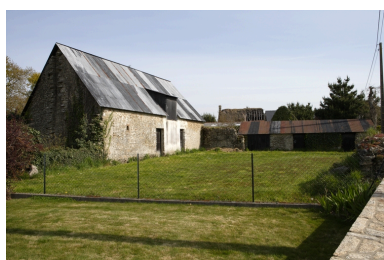
Vue d'ensemble actuelle depuis le nord-ouest. Phot. Denis Pillet IVR52_20084401472NUCA
