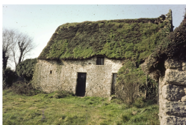
Vue de la ferme ouest depuis le sud au début des années 1980. Phot. Denis (reproduction) Pillet IVR52_20094400999NUCA
