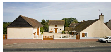
Ferme dite L'Orgerie, 5, rue principale. Le logis appartient à l'ensemble d'édifices à cour commune précédent, les parties agricoles sont construites vers 1886 pour Auguste Esnault Phot. Yves Guillotin IVR52_20117200699NUCA
