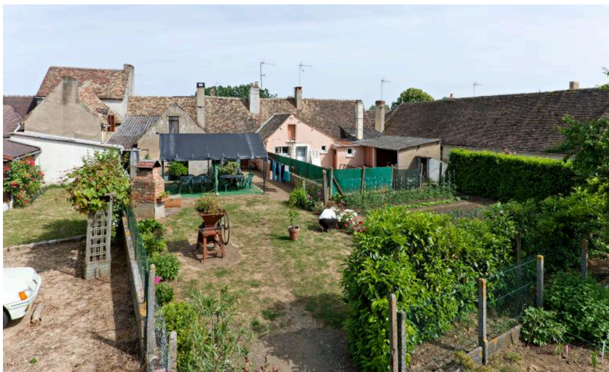
Vue des arrières des parcelles, 10-16 rue principale
