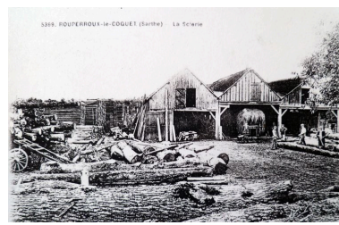
Vue de la scierie dans le 1er quart du XXe siècle Phot. Julien (reproduction) Hardy IVR52_20137200028NUC
