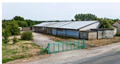
1, rue principale. Vestiges de la scierie mécanique Phot. Yves Guillotin IVR52_20117200697NUCA
