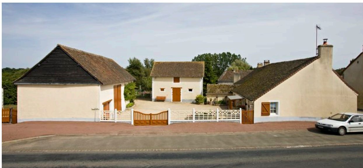
Ferme dite L'Orgerie, 5, rue principale. Le logis appartient à l'ensemble d'édifices à cour commune précédent, les parties agricoles sont construites vers 1886 pour Auguste Esnault
