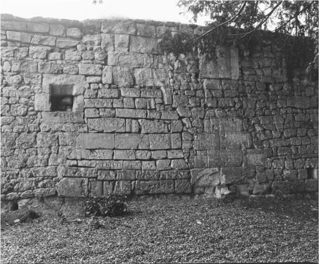
Mur de clôture nord (avec reprises des maçonneries), ancienne baie (obturée) qui ouvrait depuis un bâtiment (détruit) du Clos Bourbon vers l'ancien cimetière.
