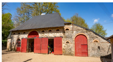
L'écurie-remise. Phot. Pierre-Bernard Fourny IVR52_20225300484NUCA
