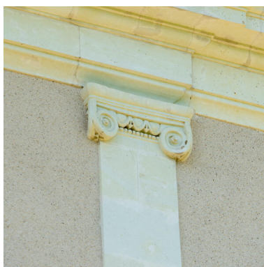
Un détail d'un pilastre. Phot. Pierre-Bernard Fourny IVR52_20225300475NUCA
