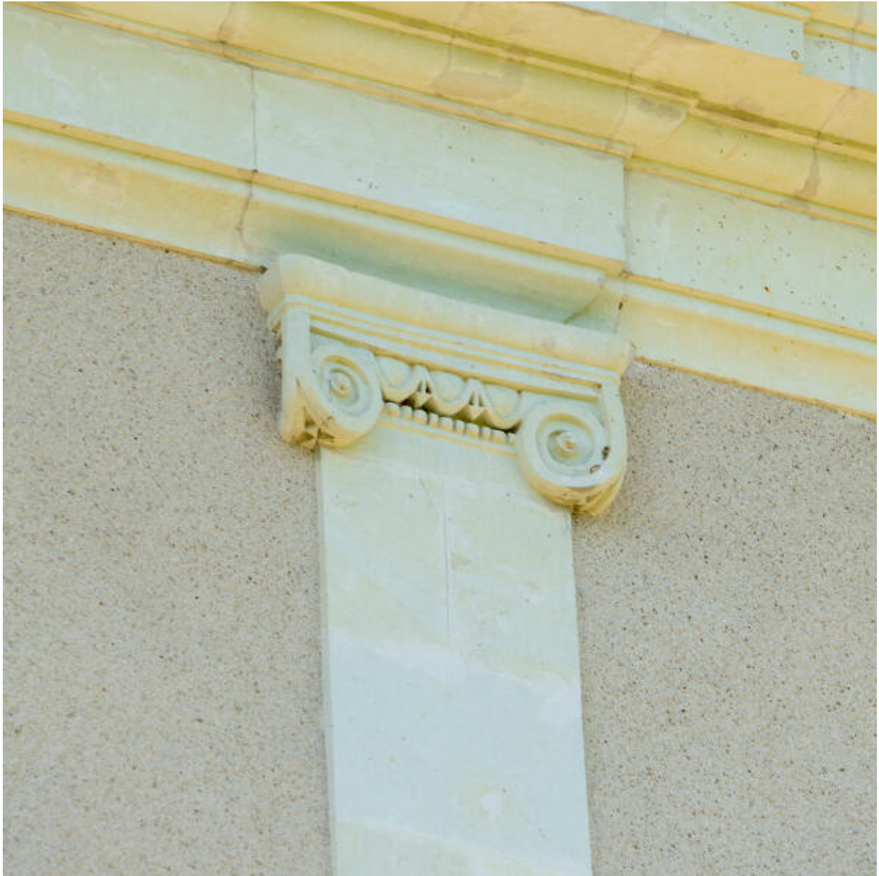
Un détail d'un pilastre.
