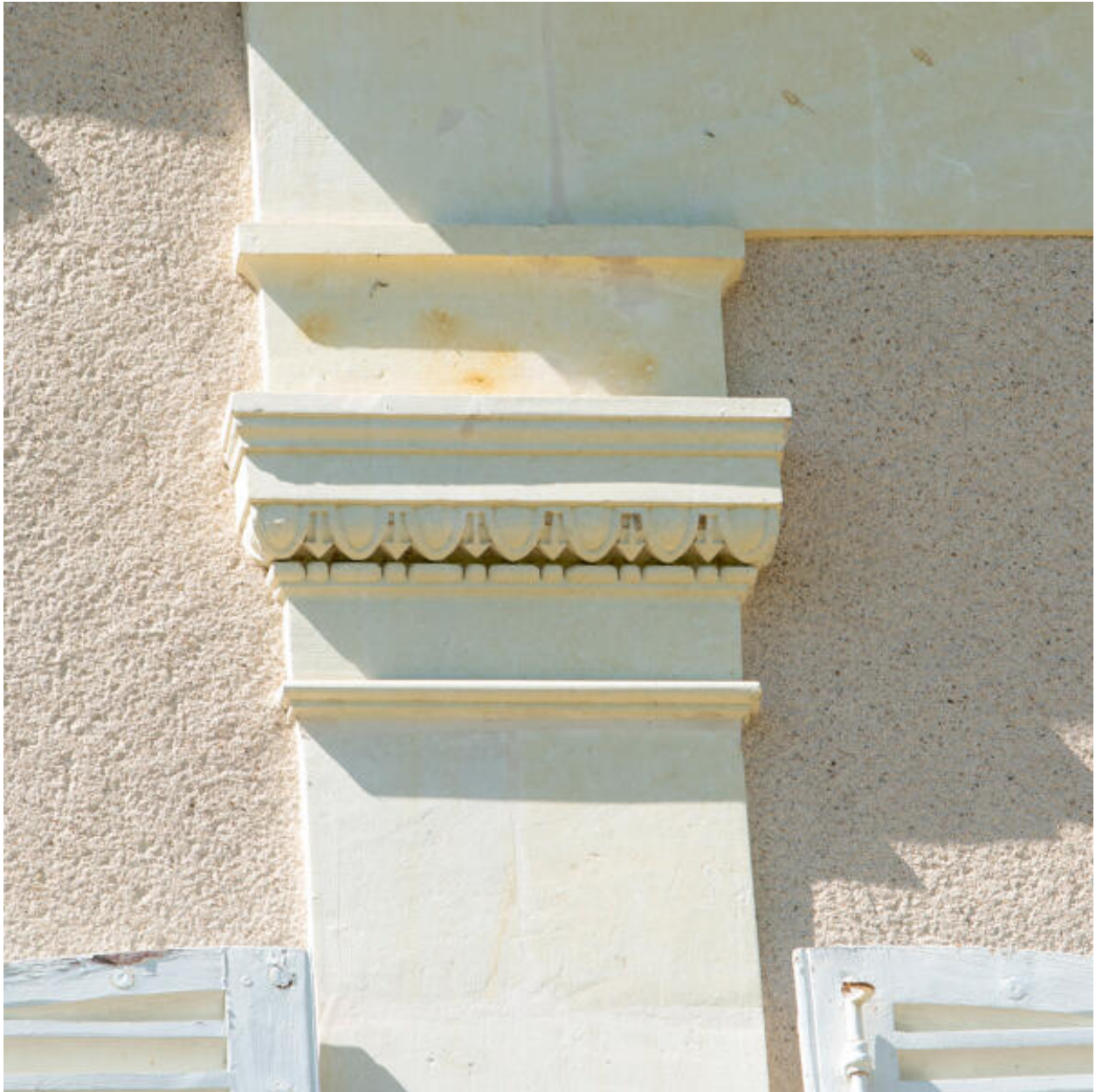
Un détail d'un pilastre.
