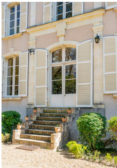
Le perron et la porte de la façade postérieure. Phot. Pierre-Bernard Fourny IVR52_20225300481NUCA
