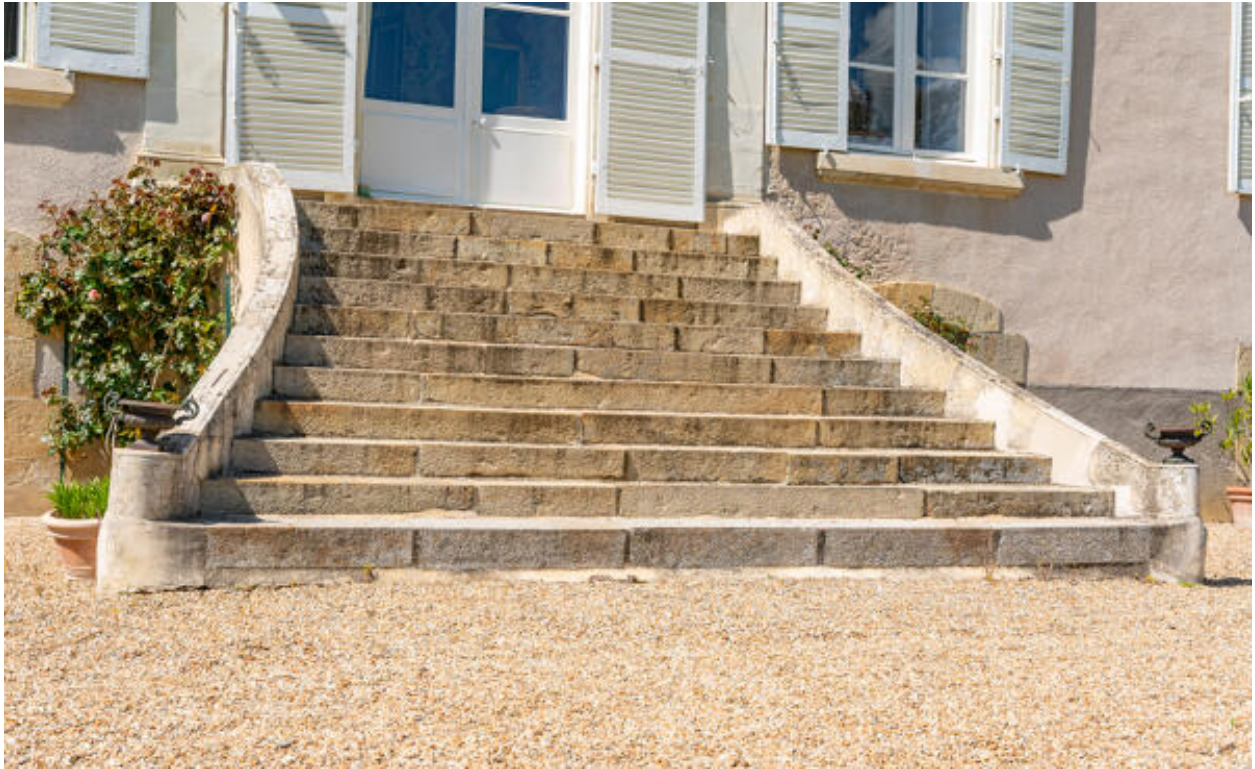
Le perron de la façade antérieure.
