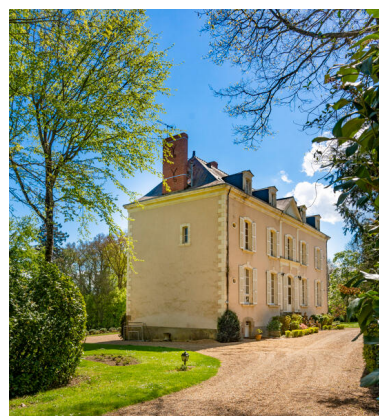
La façade postérieure du logis. Phot. Pierre-Bernard Fourny IVR52_20225300486NUCA
