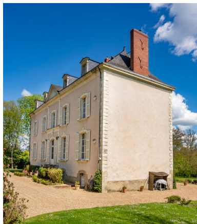
La façade postérieure du logis. Phot. Pierre-Bernard Fourny IVR52_20225300479NUCA
