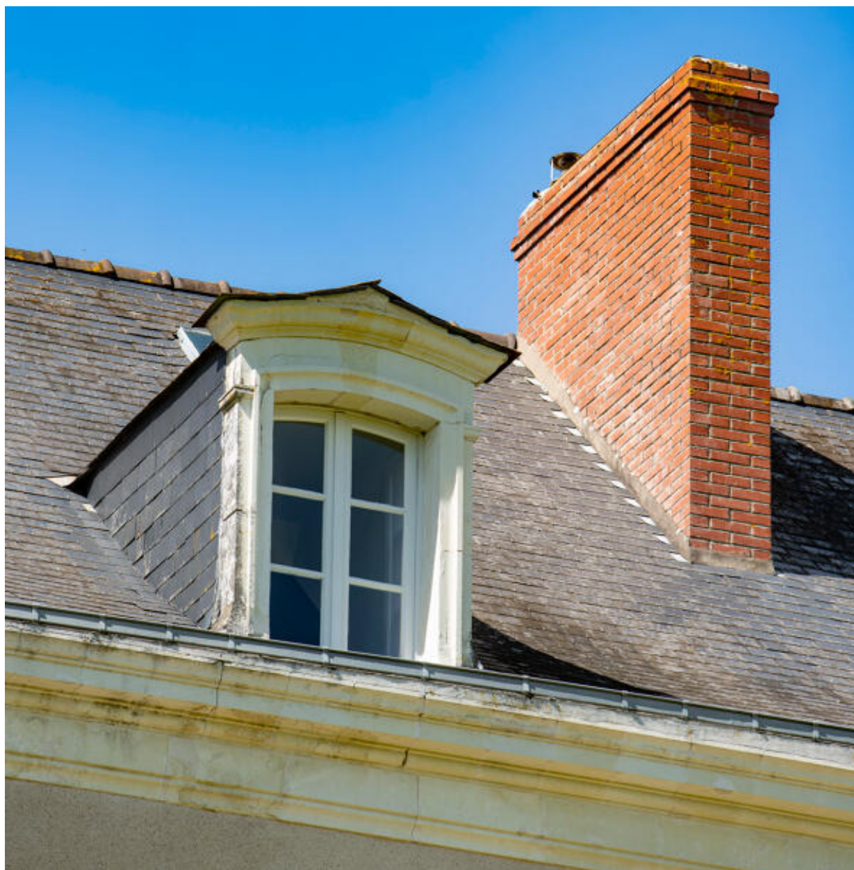
Un détail d'une lucarne.
