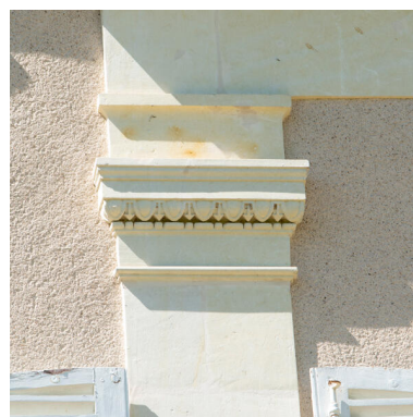
Un détail d'un pilastre. Phot. Pierre-Bernard Fourny IVR52_20225300476NUCA
