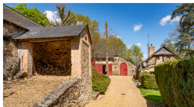
Les communs. Phot. Pierre-Bernard Fourny IVR52_20225300483NUCA
