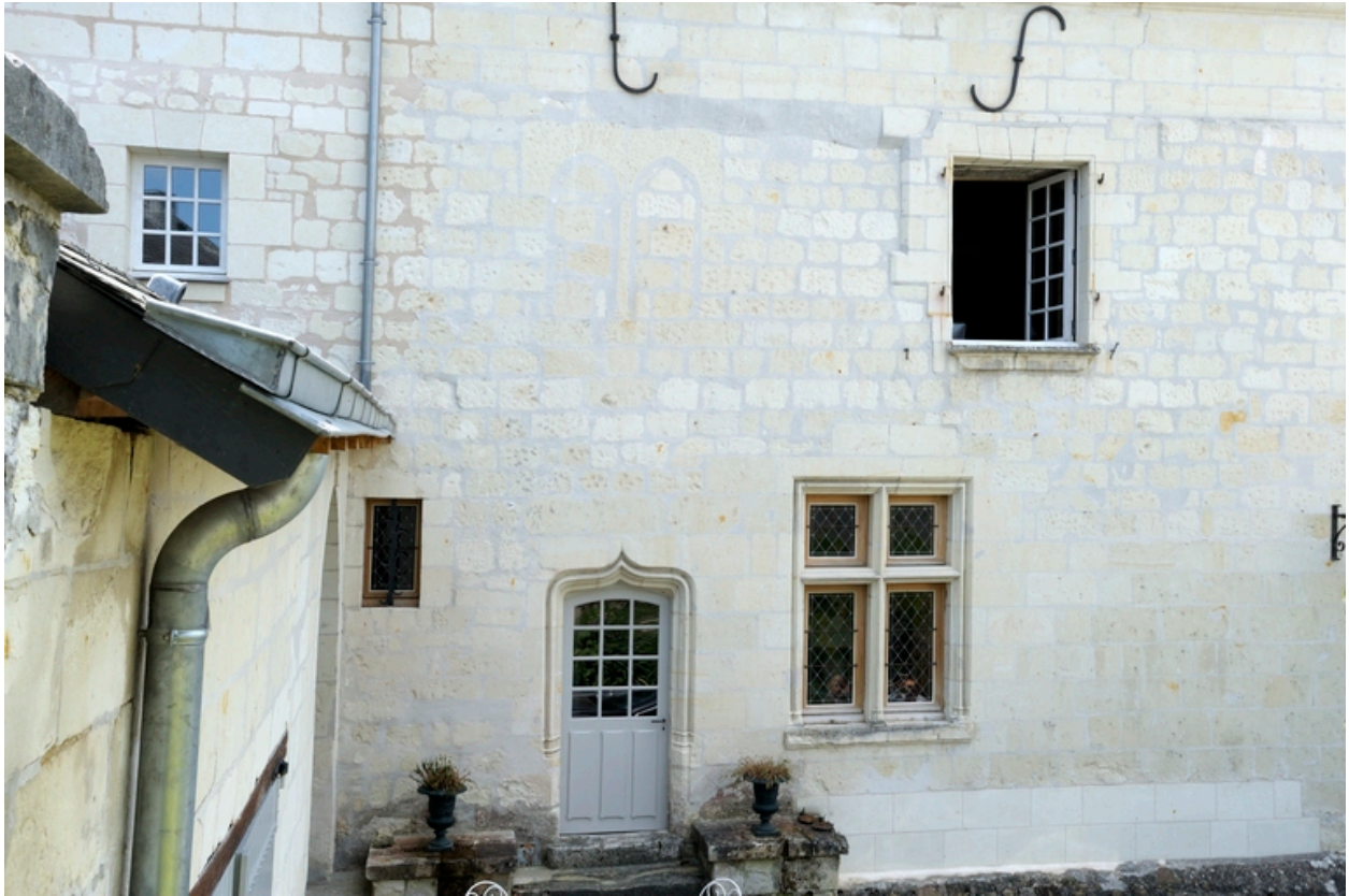
Façade principale (nord-est). A l'étage, la baie géminée à arcs brisés, obturée, remonte sans doute au XIV e siècle. Au RdC, les baies de style médiéval sont du XX e siècle.
