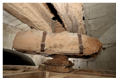
Pressoir : détail de la vis. Phot. Bruno Rousseau IVR52_20134900952NUCA
