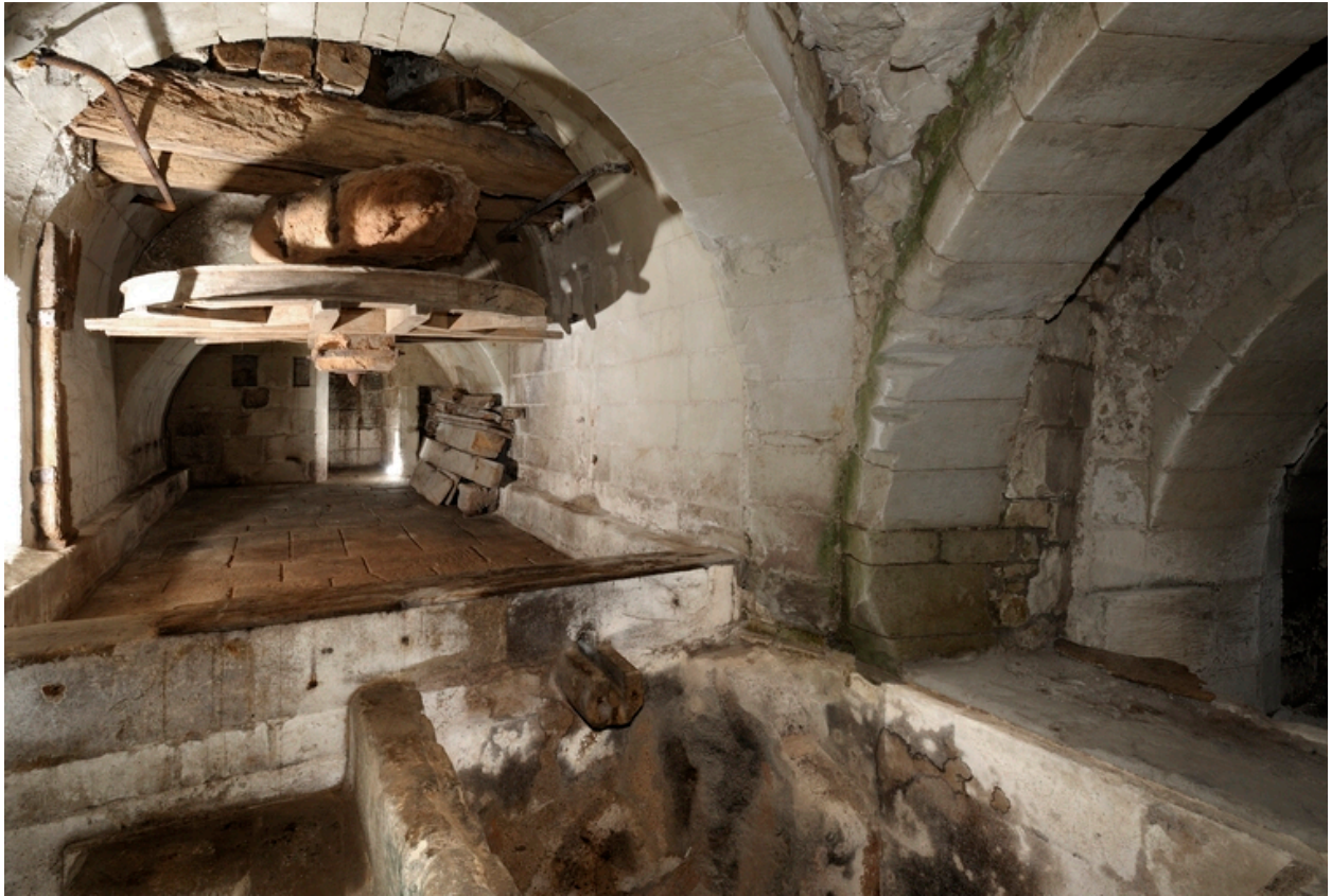
Pressoir troglodytique : jetée de pressoir, pressoir à roue, maie, enchère.
