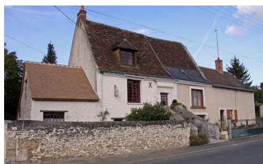
Vue de volume. Phot. Jean-Baptiste Darrasse IVR52_20087202559NUCA
