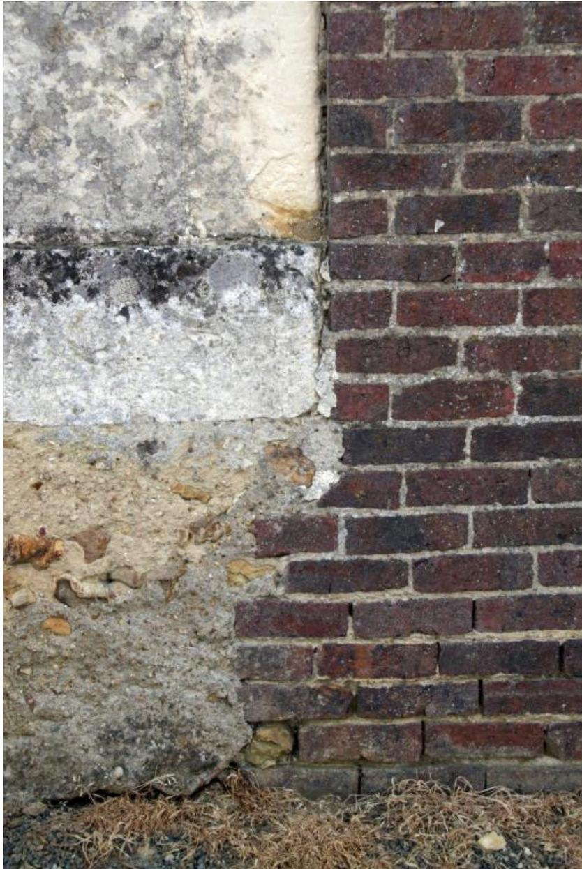
Grange : détail de la mise en œuvre pierre de taille-brique.
