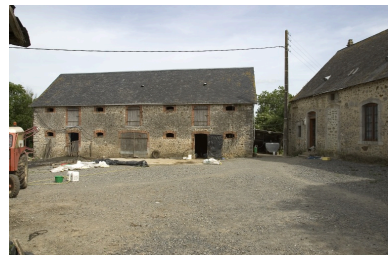
L'étable et le logis vus depuis l'ouest. Phot. François Lasa IVR52_20045301824NUCA
