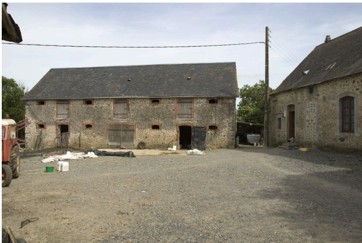
L'étable et le logis vus depuis l'ouest.
