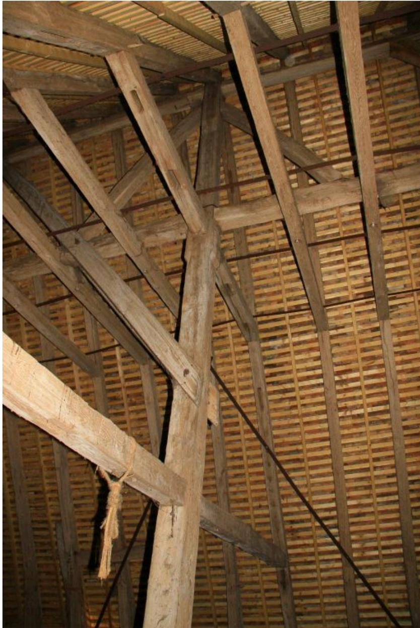
Bâtiment des greniers, charpente : les fermes servaient de support à des cloisons de pan-de-bois.
