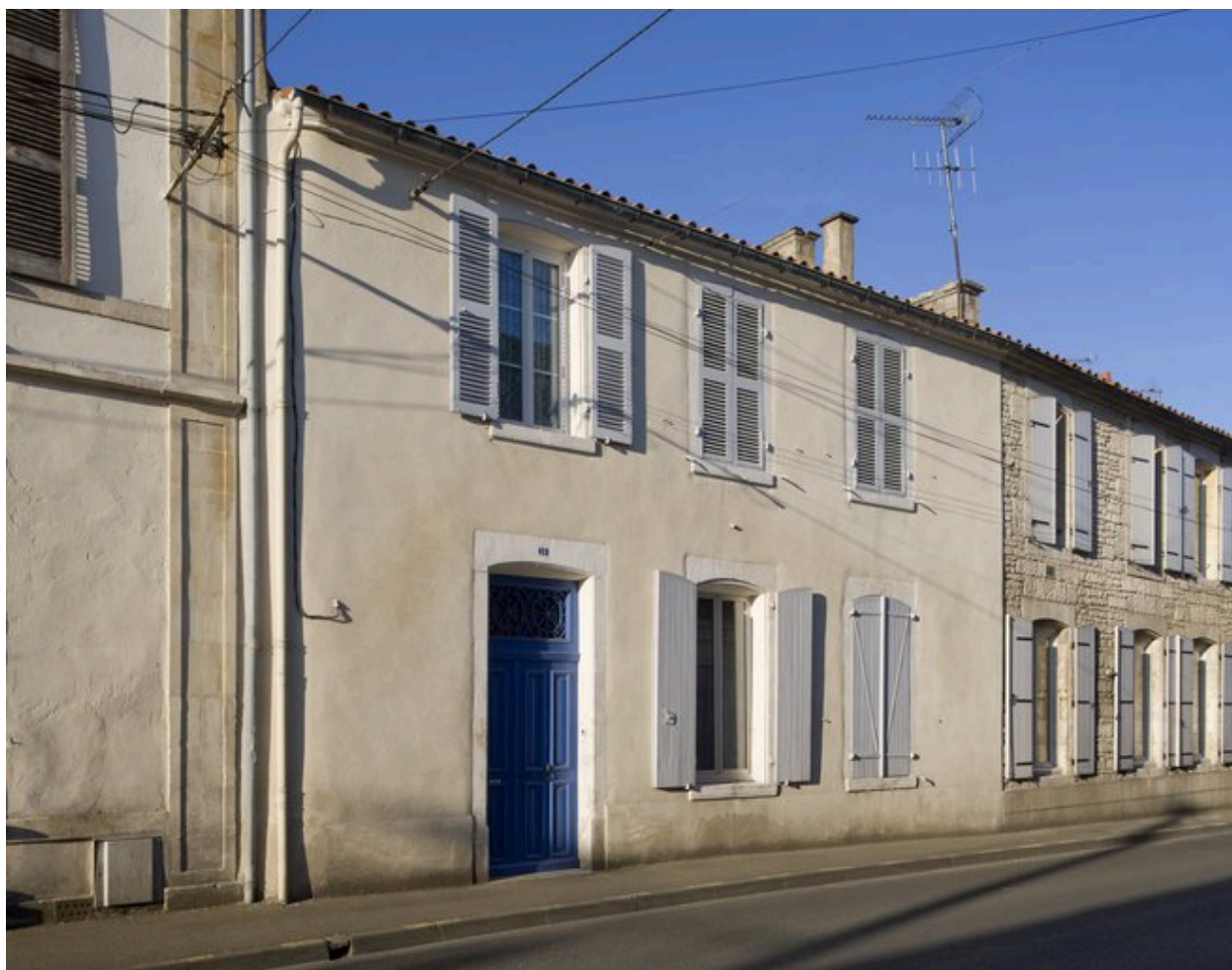
Façade nord sur rue.
