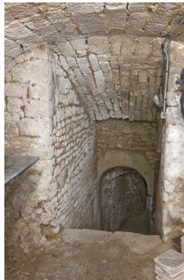
Escalier de descente au deuxième niveau de sous-sol. Phot. Patrice Giraud IVR52_20098500257NUCA
