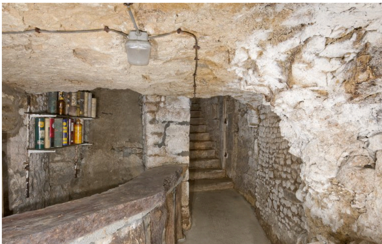
Vue du deuxième niveau de sous-sol.
