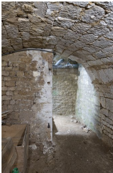
Vue du premier niveau de sous-sol, voûté en berceau. Phot. Patrice Giraud IVR52_20098500262NUCA
