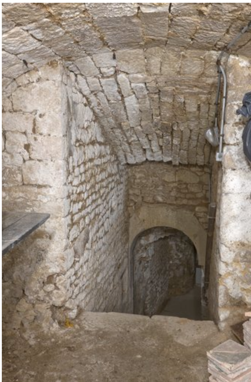
Escalier de descente au deuxième niveau de sous-sol.
