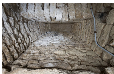
Vue du couvrement de la jonction des deux parties du sous-sol (cf. cliché 20098500257) : trémie pour l'aération. Phot. Patrice Giraud IVR52_20098500261NUCA
