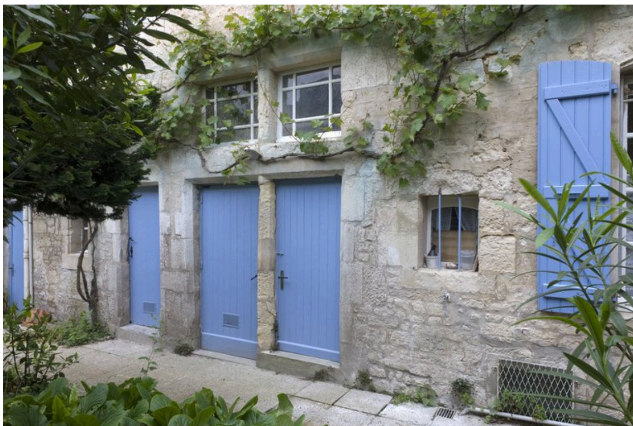
Détail de la façade est sur cour, montrant la partie plus ancienne. La porte du milieu donne accès au sous-sol.
