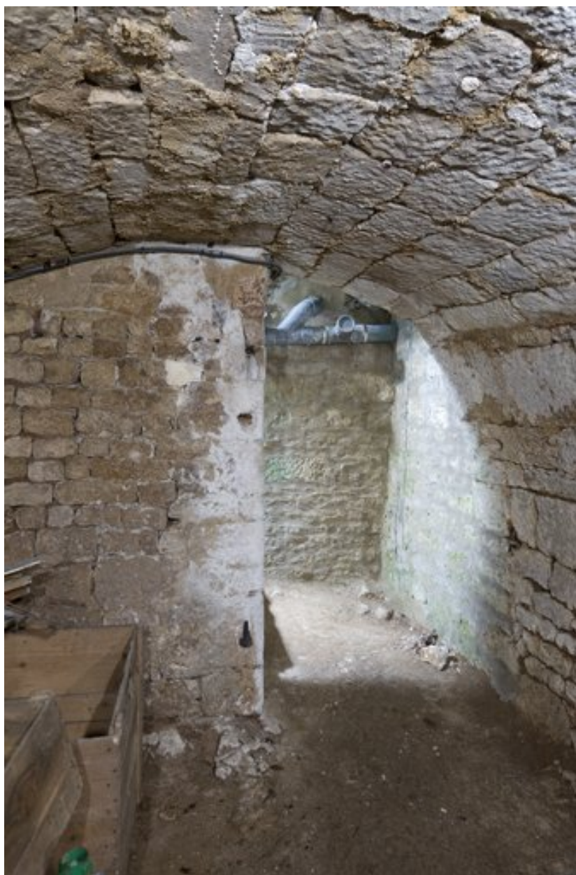
Vue du premier niveau de sous-sol, voûté en berceau.
