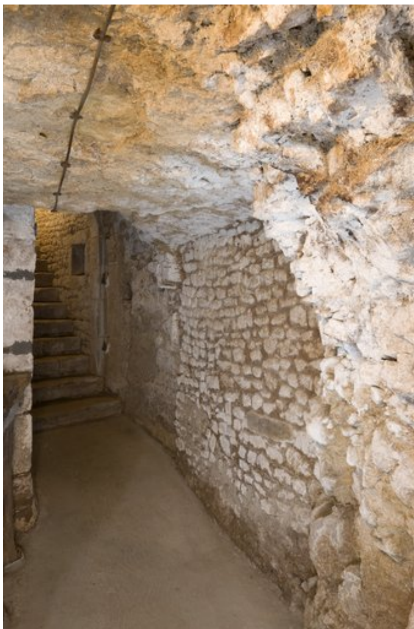
Vue du deuxième niveau de sous-sol.
