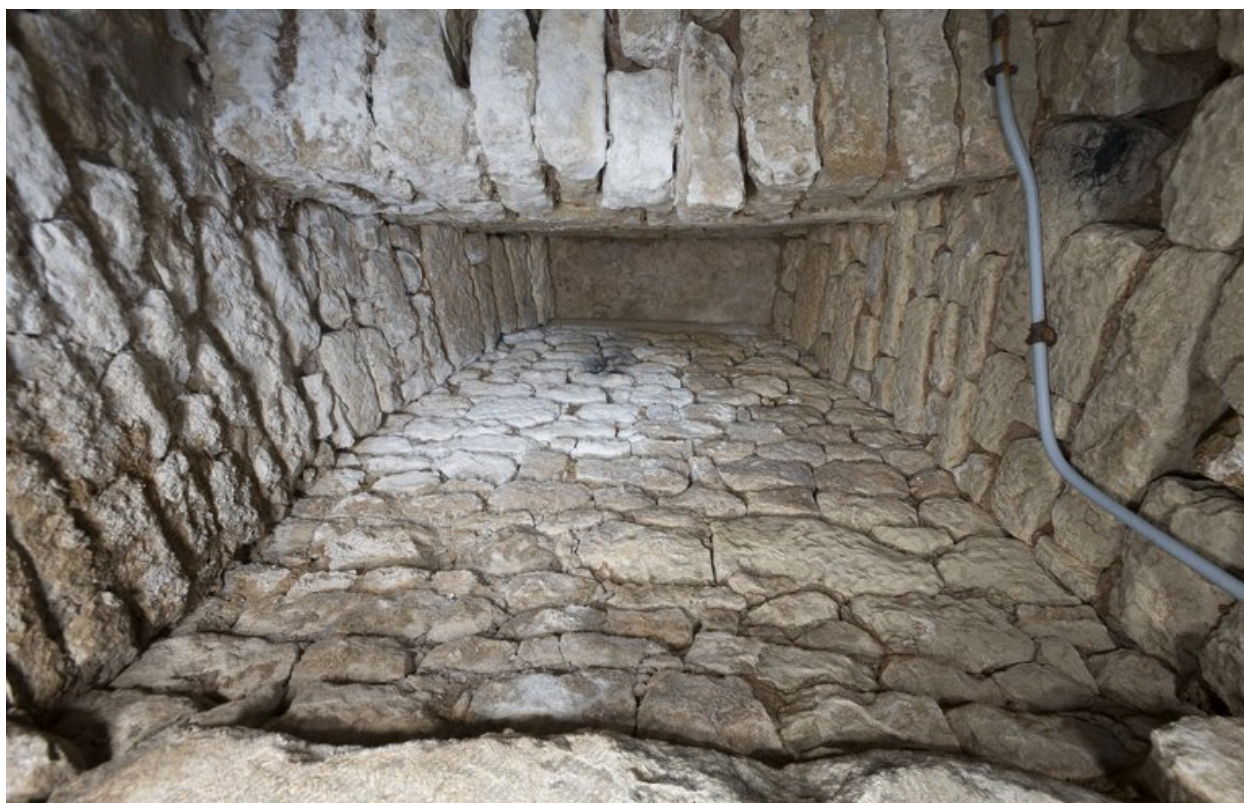
Vue du couvrement de la jonction des deux parties du sous-sol (cf. cliché 20098500257) : trémie pour l'aération.
