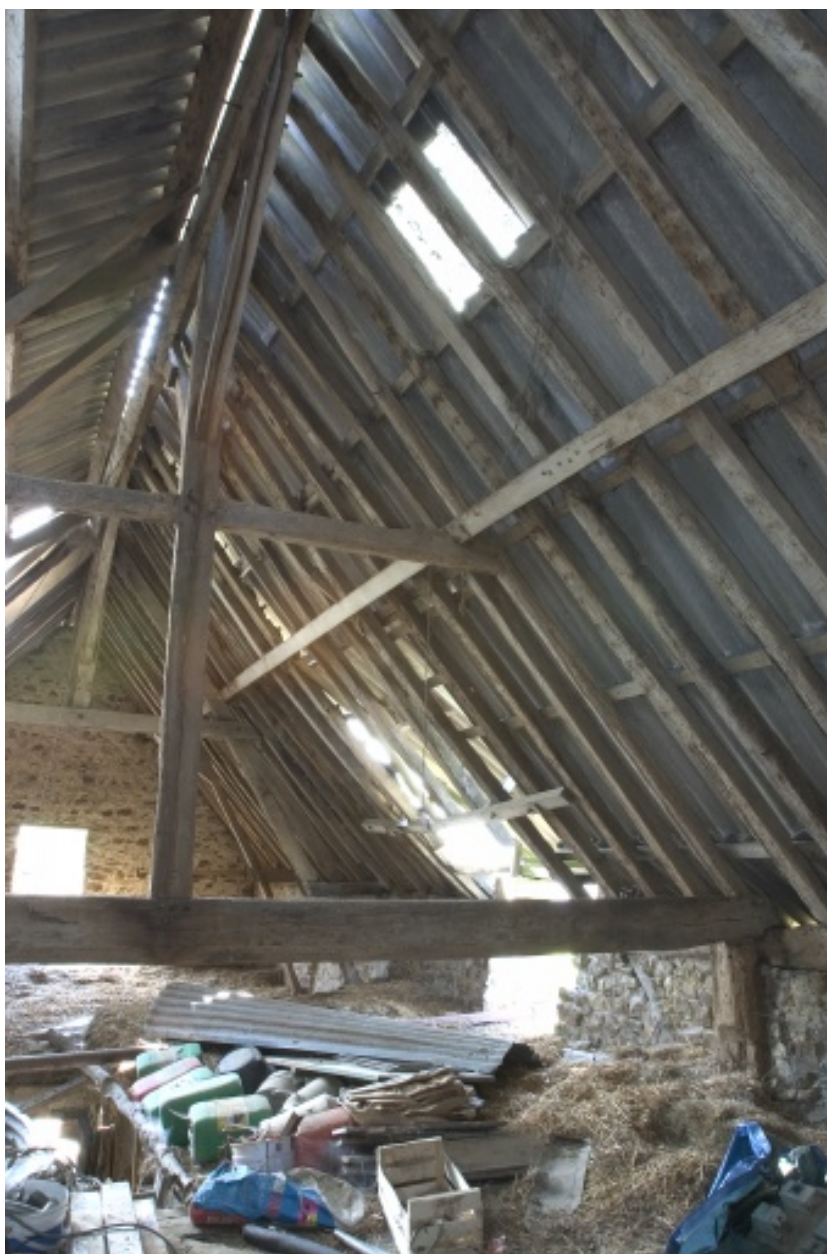
La charpente de l'étable-grange.
