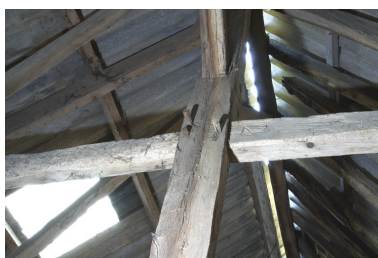
Détail de la charpente de l'étable-grange : marques d'assemblage. Phot. François Lasa IVR52_20045302022NUCA
