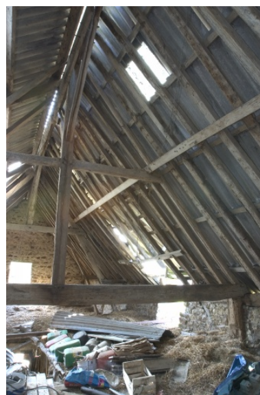
La charpente de l'étable-grange. Phot. François Lasa IVR52_20045302020NUCA
