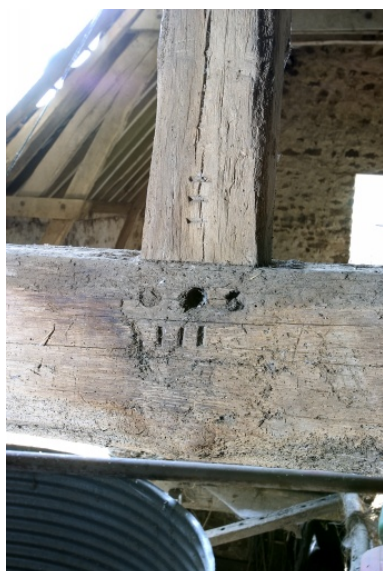
Détail de la charpente de l'étable-grange : marques d'assemblage. Phot. François Lasa IVR52_20045302021NUCA
