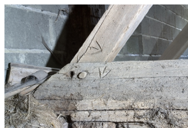
Détail de la charpente de l'étable-grange : marques d'assemblage. Phot. François Lasa IVR52_20045302023NUCA
