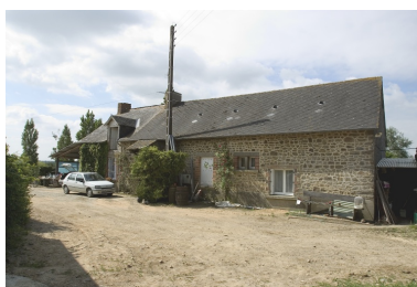
L'ancien logis de ferme. Phot. François Lasa IVR52_20045302019NUCA
