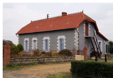
La Bouchauderie, écart : maison de type Villa avec tuiles mécaniques, petites croupes et enduit gris bleu. Phot. Jean-Baptiste Darrasse IVR52_20077202523NUCA
