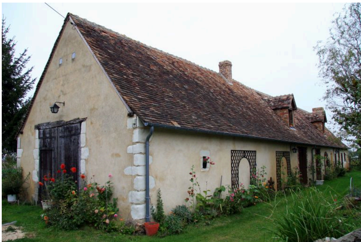
L'Aubépin, écart : maison restaurée.
