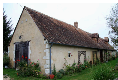
L'Aubépin, écart : maison restaurée. Phot. Jean-Baptiste Darrasse IVR52_20077202461NUCA
