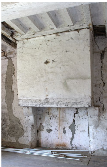
La cheminée de la pièce haute. Phot. François Lasa IVR52_20055301724NUCA
