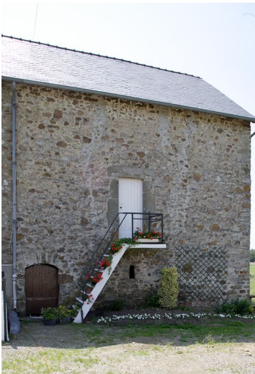
La partie nord de la façade principale du manoir.
