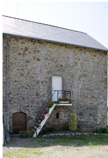
La partie nord de la façade principale du manoir. Phot. François Lasa IVR52_20055301719NUCA
