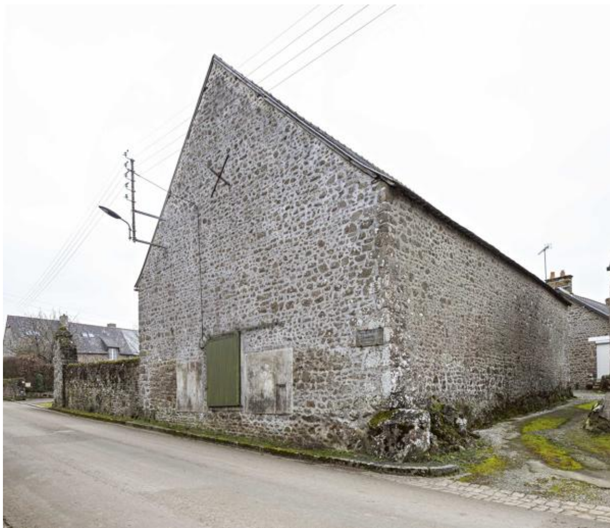
Granges aux dîmes de Saint-Fraimbault, mur-pignon nord.
