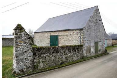
Granges aux dîmes de Saint-Fraimbault, vue depuis le nord-est.
