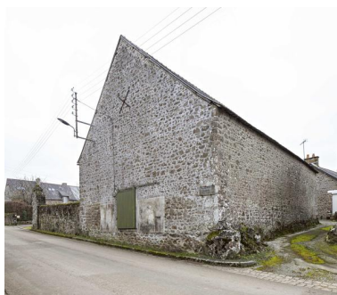
Granges aux dîmes de Saint-Fraimbault, mur-pignon nord.
