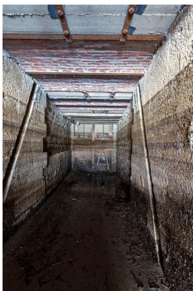
Vue intérieure du coursier, depuis l'aval, en 2019.
