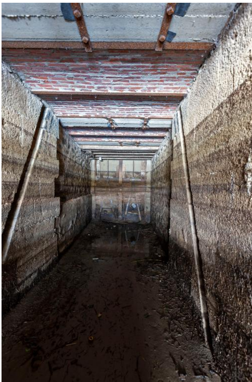
Vue intérieure du coursier, depuis l'aval, en 2019.
