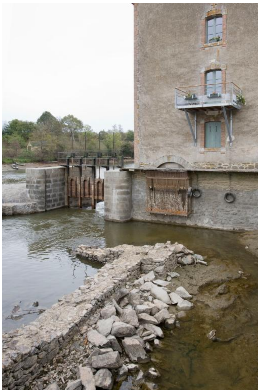
Vue partielle de la façade nord-ouest (d'amont) du moulin, avec l'entrée du coursier, pendant les écoures de 2009. A gauche, le pertuis ; au premier plan, les vestiges du moulin détruit lors de la reconstruction du barrage, en 1876.
