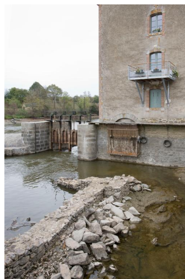
Vue partielle de la façade nord- ouest (d'amont) du moulin, avec l'entrée du coursier, pendant les écourues de 2009. A gauche, le pertuis ; au premier plan, les vestiges du moulin détruit lors de la reconstruction du barrage, en 1876. Phot. Yves Guillotin IVR52_20095300476NUCA
