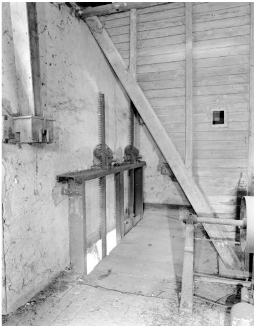
Rez-de-chaussée, partie nord, en 2002 : vannes d'amont servant à fermer et à ouvrir le coursier.
