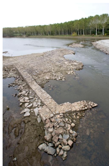
Vue des vestiges des fondations du moulin détruit lors de la reconstruction du barrage, en 1876, pendant les écoures de 2009.
