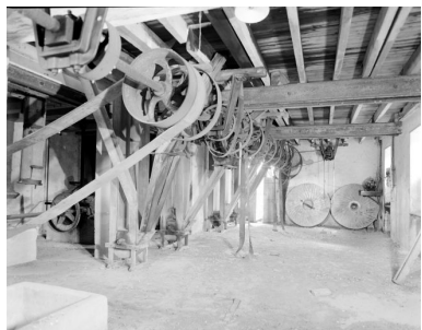
Le rez-de-chaussée vu depuis l'ouest, en 2002. L'axe haut et ses courroies recevant la force motrice des turbines et la transmettant aux broyeurs situés au-dessus ; les élévateurs à godets ; au fond, les anciennes meules.
