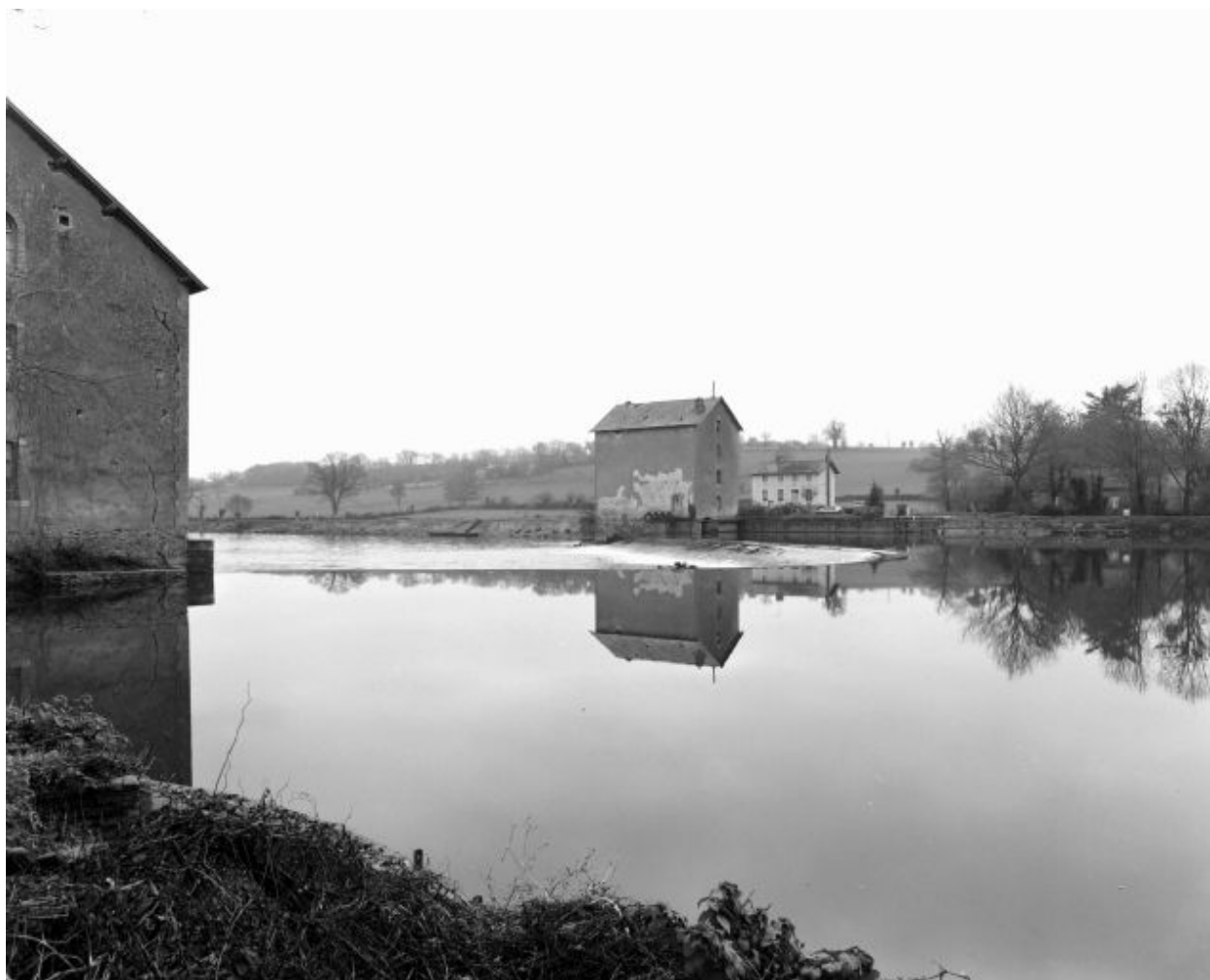
Le site du moulin, vu depuis la rive gauche, en amont, en 2001 : barrage, pertuis, moulin (façades nord-est et nord-ouest), maison éclésièrre. A droite, derrière les arbres, la maison du meunier.
