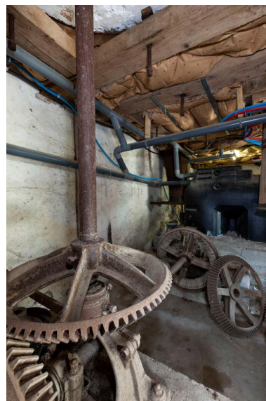
Rez-de-chaussée, partie nord vue depuis l'ouest, en 2019 : les pignons et les axes transmettant la force motrice à l'une des paires de meules.
