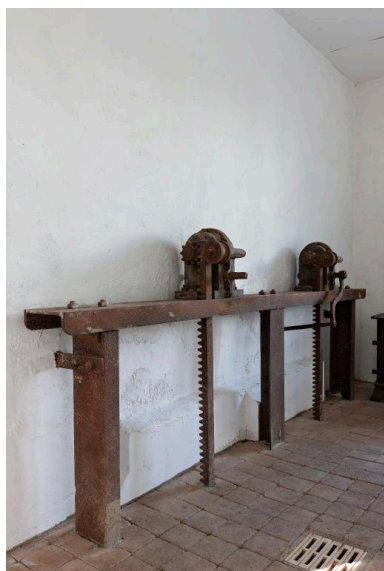
Rez-de-chaussée, partie nord, en 2019 : vannes d'amont. Phot. Yves Guillotin IVR52_20195300310NUCA
