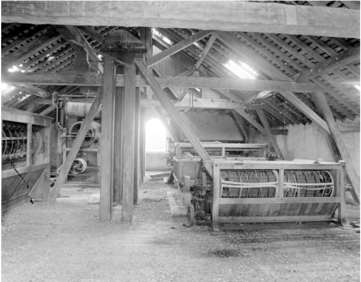
Comble en 2002. Vue depuis le nord-ouest.
