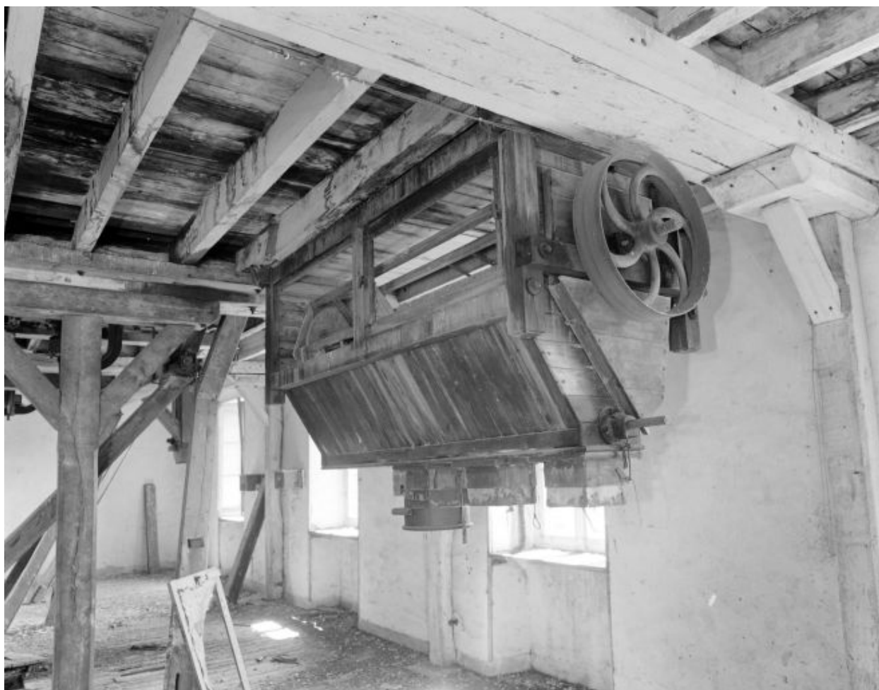
Deuxième étage, partie sud-ouest vue depuis le nord, en 2002 : bluterie-diviseur pour le remoulage.
