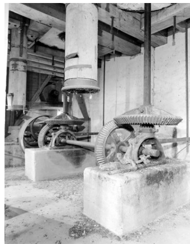
Rez-de-chaussée, partie nord vue depuis le sud, en 2002 : mécanisme de transmission de la force motrice aux meules situées au-dessus ; ensacheurs à céréales secondaires recevant la mouture issue des deux paires de meules.
