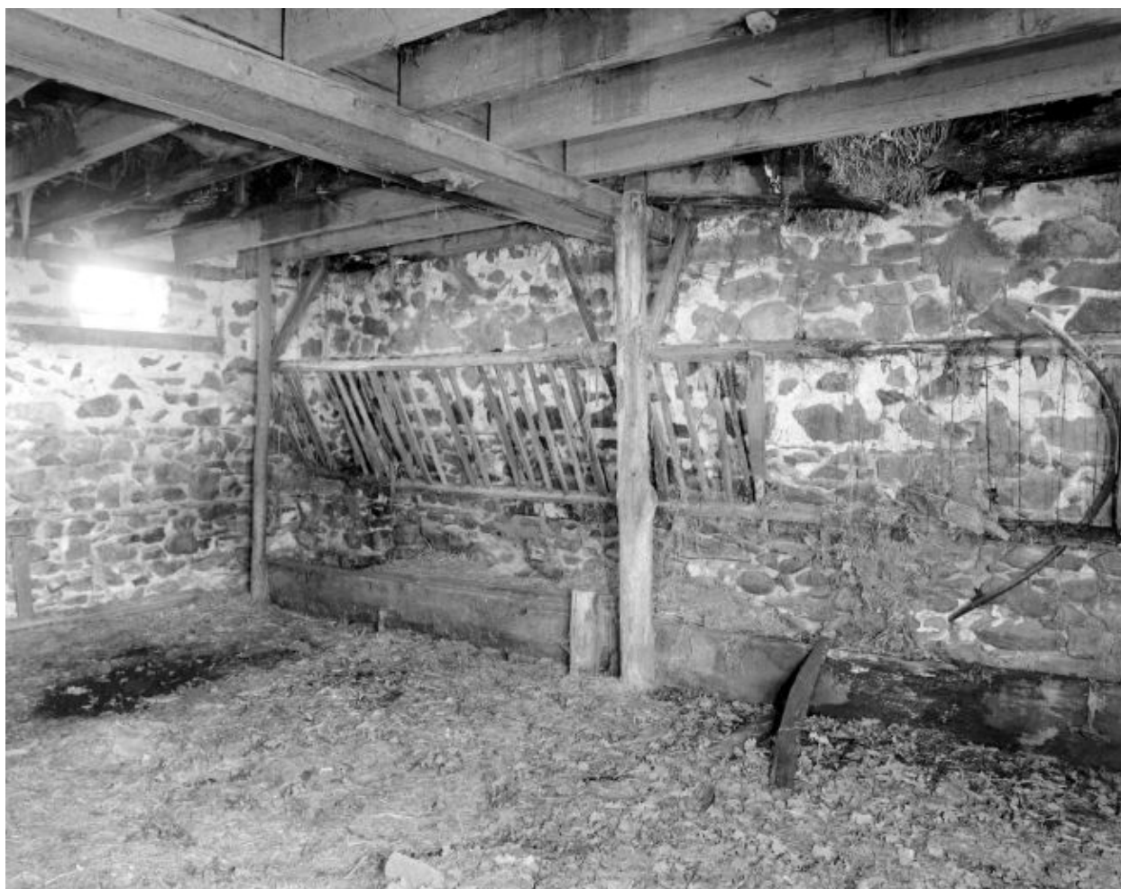
L'étable à vaches, en 2002 : l'abat-foin et les mangeoires appuyées contre le mur sud-ouest.
