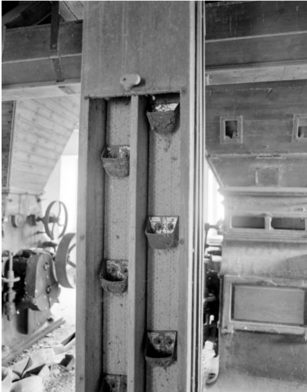
Premier étage, en 2002 : élévateur à godets.
