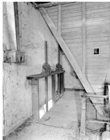
Rez-de-chaussée, partie nord, en 2002 : vannes d'amont servant à fermer et à ouvrir le coursier. Phot. François Lasa IVR52_20025300738X
