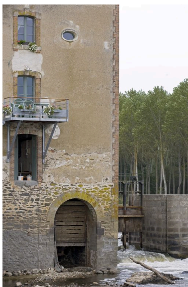
Vue partielle de la façade sud-est (d'aval) du moulin, avec la sortie du coursier, pendant les écourues de 2009. A droite, le pertuis. Phot. Yves Guillotin IVR52_20095300480NUCA
