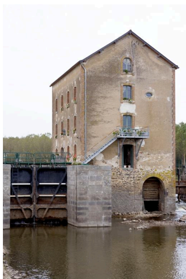
La façade sud-est (d'aval) du moulin, pendant les écourues de 2009. A gauche, la porte d'aval de l'écluse. Phot. Yves Guillotin IVR52_20095300478NUCA
