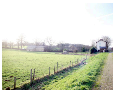
Les dépendances du moulin vues depuis le chemin de halage, au sud-est, en 2002 : à gauche, le bâtiment de dépendance principal, au centre, l'ancienne maison de meunier. A droite se trouve la maison éclusière. A l'arrière-plan, on distingue le château de la Rongère. Phot. François Lasa IVR52_20025300431XA
