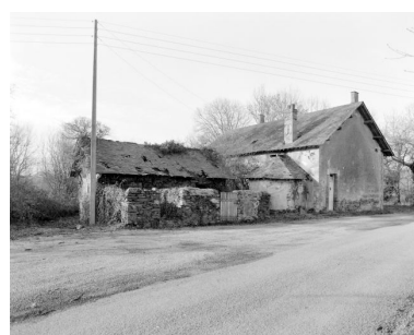
La maison de meunier et la porcherie vus depuis le sud, en 2002. Phot. François Lasa IVR52_20025300433X
