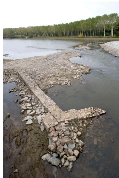
Vue des vestiges des fondations du moulin détruit lors de la reconstruction du barrage, en 1876, pendant les écoures de 2009. Phot. Yves Guillotin IVR52_20095300474NUCA
