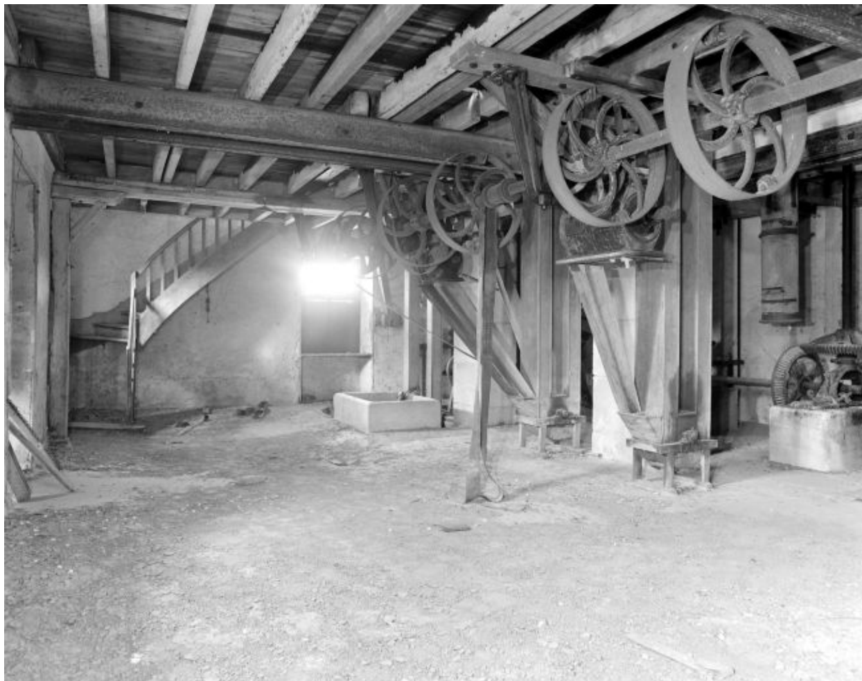
Le rez-de-chaussée vu depuis l'est, en 2002. Au centre, les élévateurs à godets, l'axe haut actionnant les courroies qui assuraient le fonctionnement des broyeurs à cylindres. A droite, les pignons transmettant la force motrice aux meules situées au-dessus et l'ensacheur à céréales secondaires recevant la mouture issue de l'une des paires de meules.
