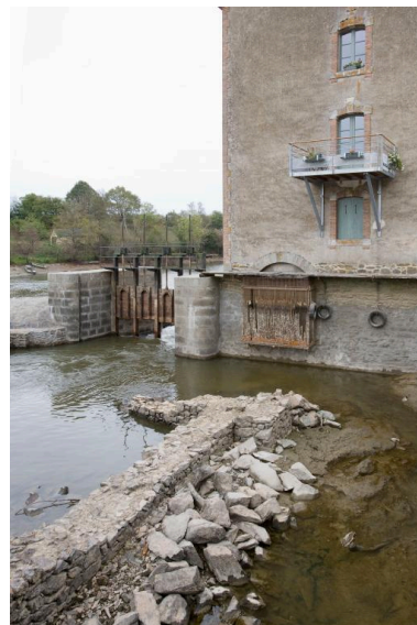
Vue partielle de la façade nord-ouest (d'amont) du moulin, avec l'entrée du coursier, pendant les écourues de 2009. A gauche, le pertuis ; au premier plan, les vestiges du moulin détruit lors de la reconstruction du barrage, en 1876. Phot. Yves Guillotin IVR52_20095300476NUCA
