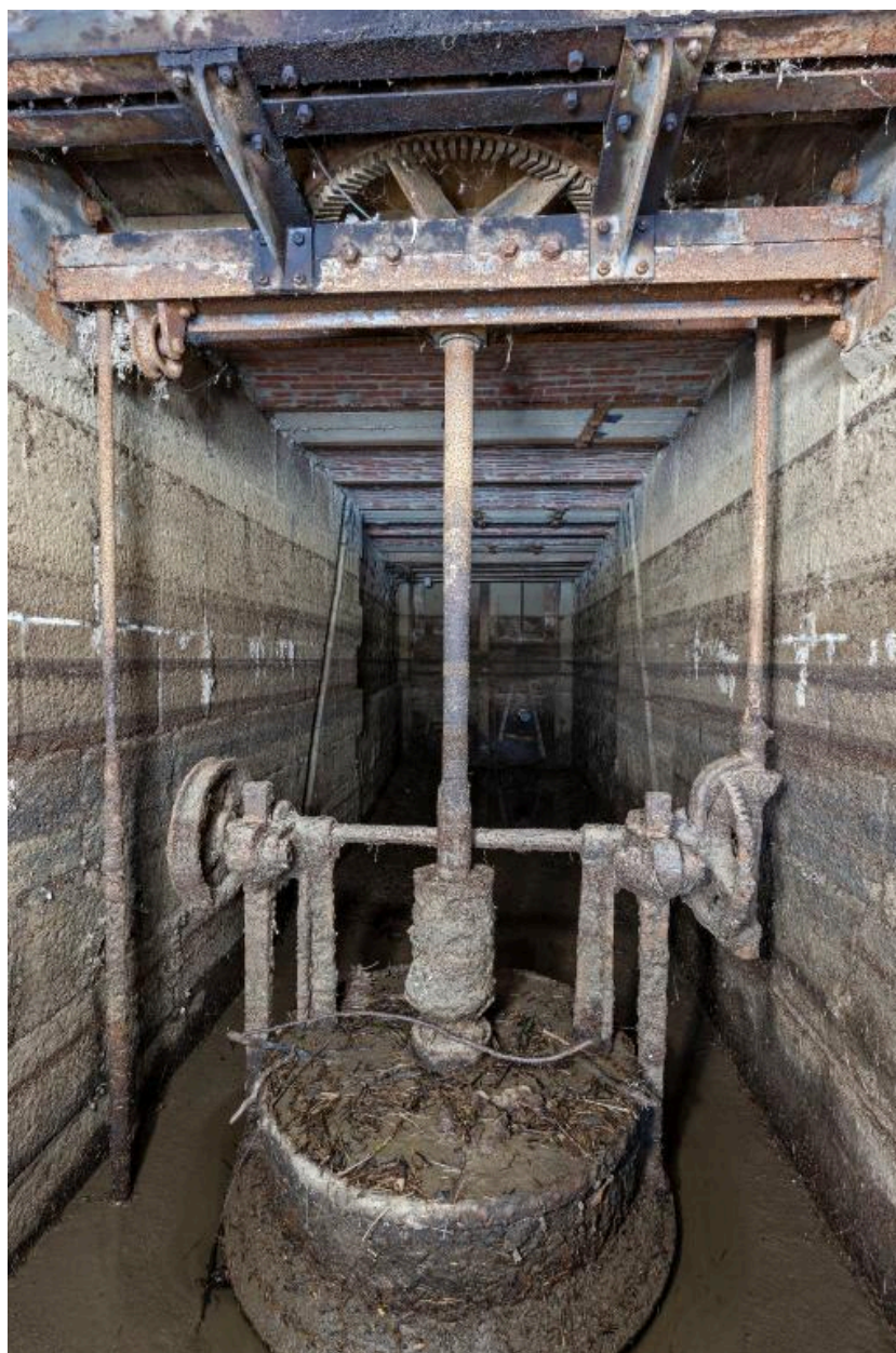
Vue intérieure du coursier, avec l'une des turbines, depuis l'aval, en 2019.
