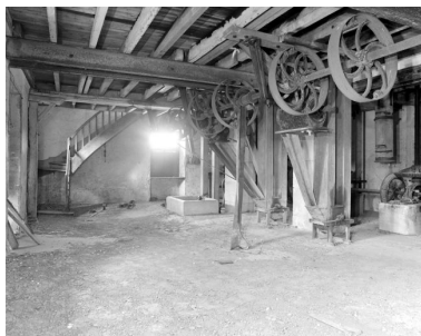
Le rez-de-chaussée vu depuis l'est, en 2002. Au centre, les élévateurs à godets, l'axe haut actionnant les courroies qui assuraient le fonctionnement des broyeurs à cylindres. A droite, les pignons transmettant la force motrice aux meules situées au-dessus et l'ensacheur à céréales secondaires recevant la mouture issue de l'une des paires de meules.
