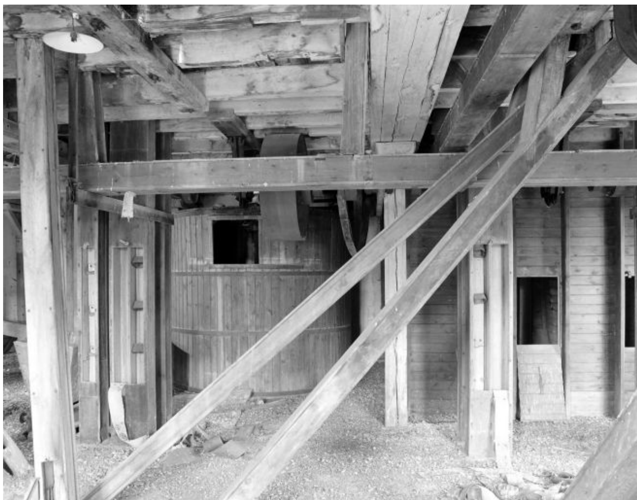
Deuxième étage, partie est vue depuis le sud-ouest, en 2002 : à gauche, chambre à farine de blé ; à droite, réserve de blé propre.
