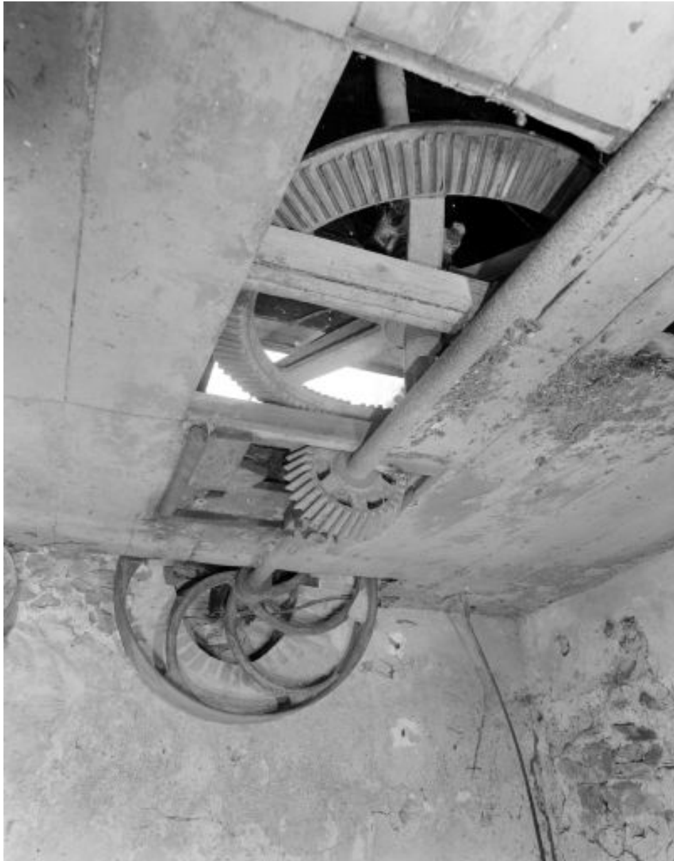
Rez-de-chaussée, partie est, en 2002 : le système de transmission des turbines, situées dans la partie aval du coursier.
