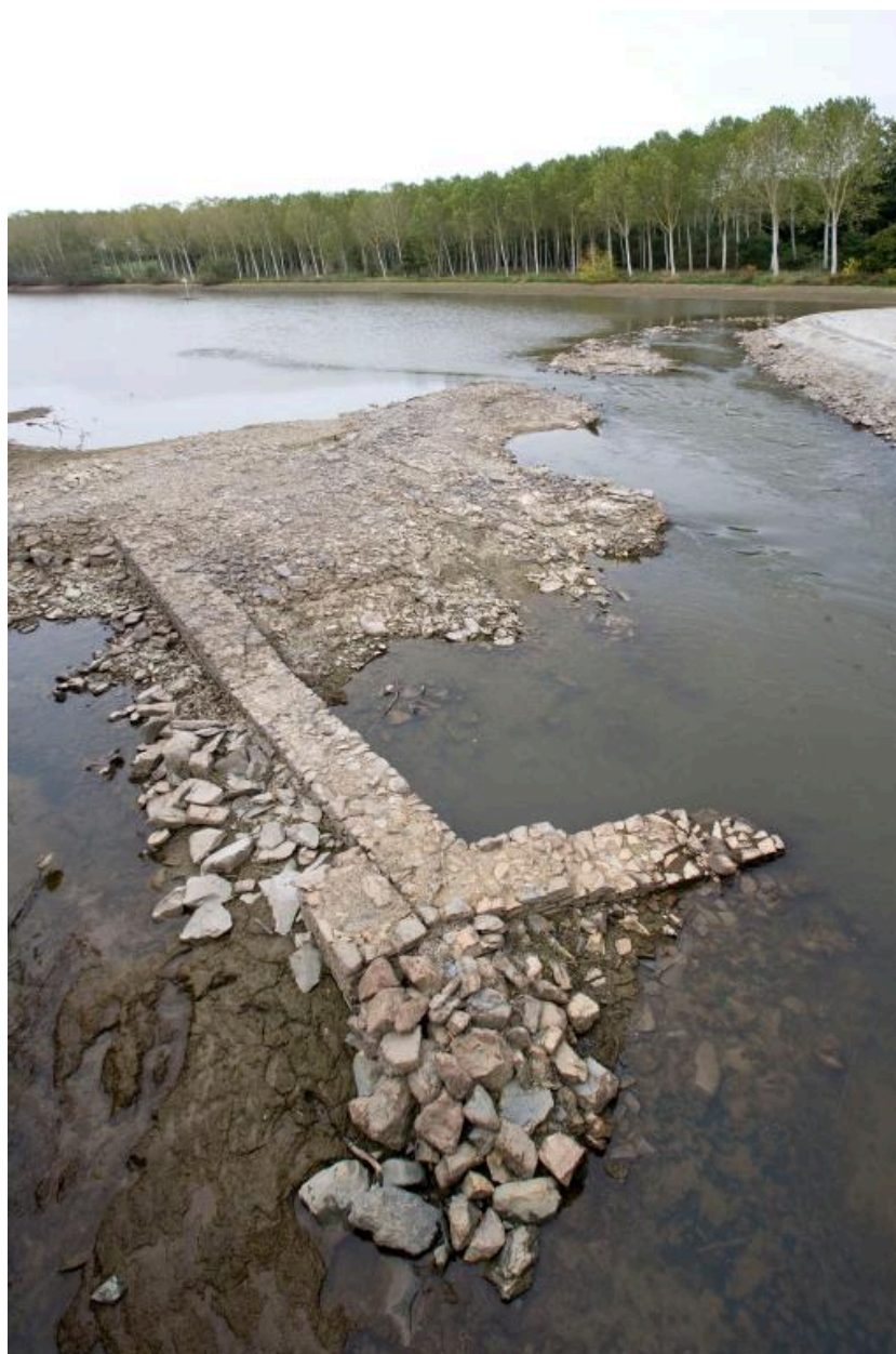
Vue des vestiges des fondations du moulin détruit lors de la reconstruction du barrage, en 1876, pendant les écourues de 2009.
