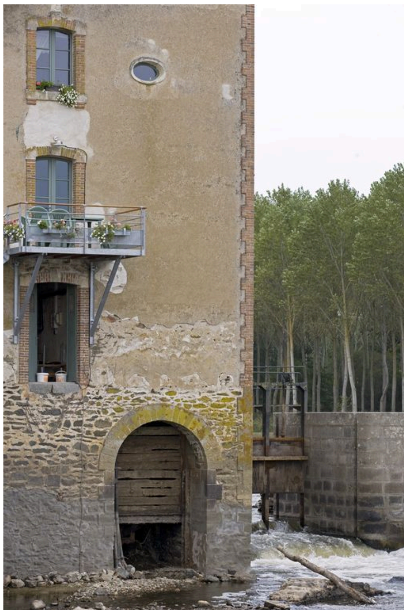
Vue partielle de la façade sud-est (d'aval) du moulin, avec la sortie du coursier, pendant les écourues de 2009. A droite, le pertuis.
