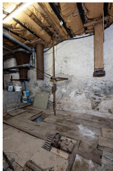
Rez-de-chaussée, partie est, en 2019 : ensacheurs à farine de blé, à son et à céréales secondaires situés presque au-dessus des turbines. Phot. Yves Guillotin IVR52_20195300305NUCA
