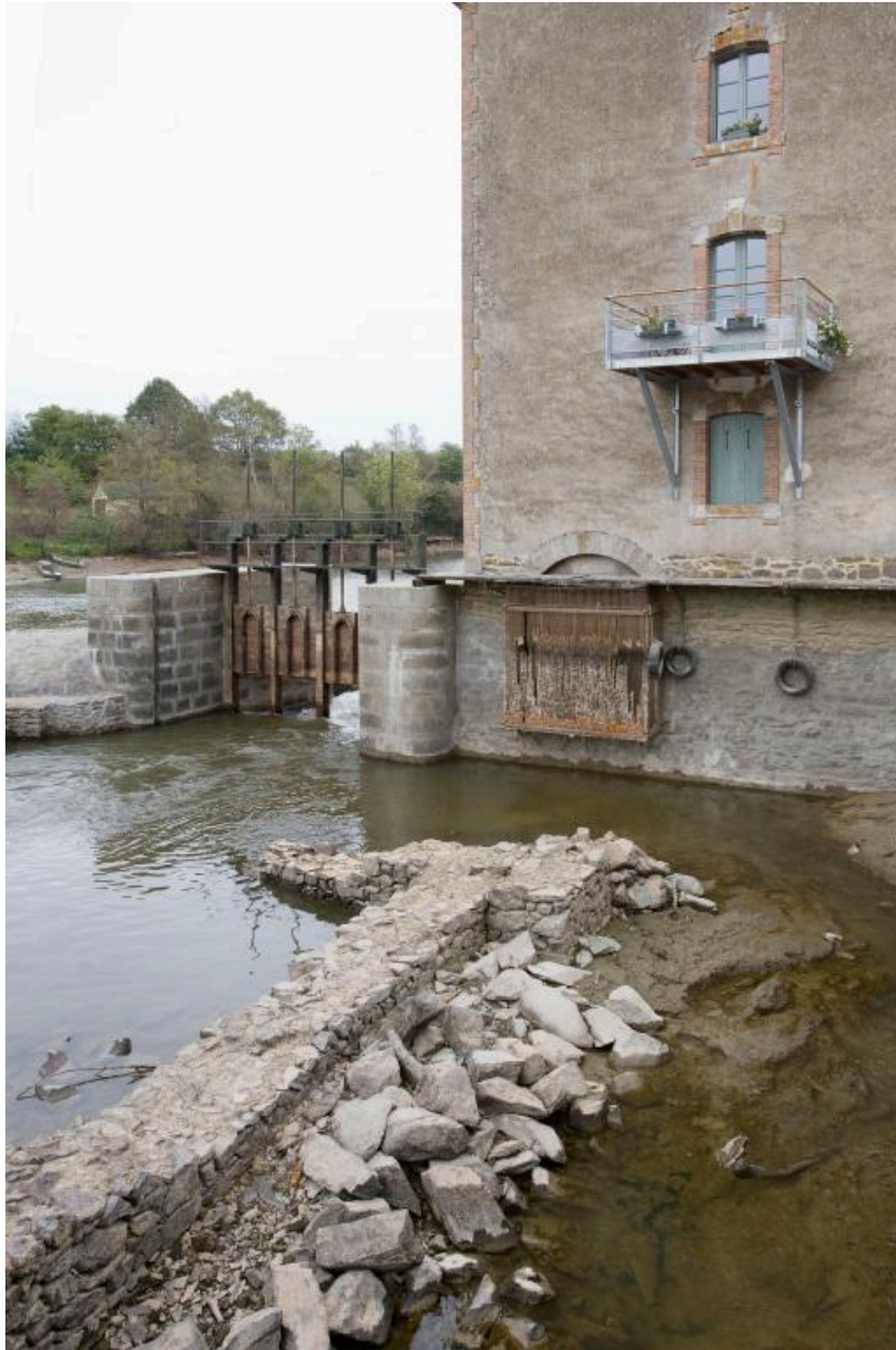
Vue partielle de la façade nord-ouest (d'amont) du moulin, avec l'entrée du coursier, pendant les écourues de 2009. A gauche, le pertuis ; au premier plan, les vestiges du moulin détruit lors de la reconstruction du barrage, en 1876.
