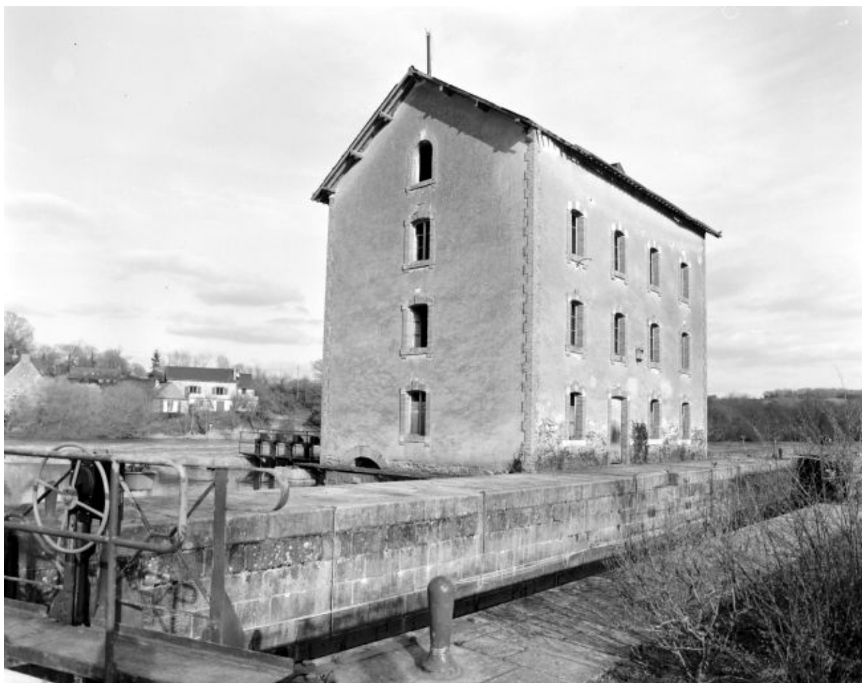
Les façades nord-ouest (d'amont) et sud-ouest du moulin, en 2002. Au premier plan, l'écluse.
