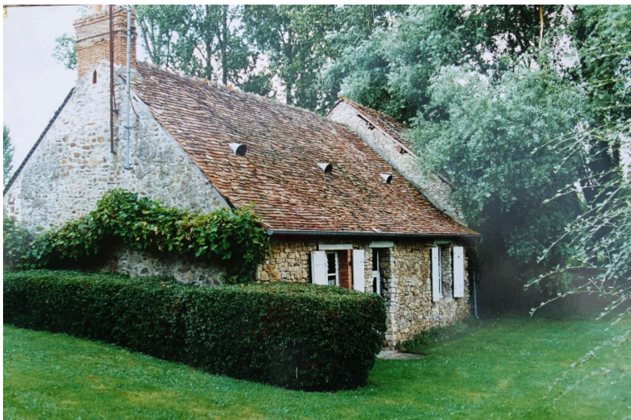
Le moulin avant les travaux. Le logis vu depuis le sud.
