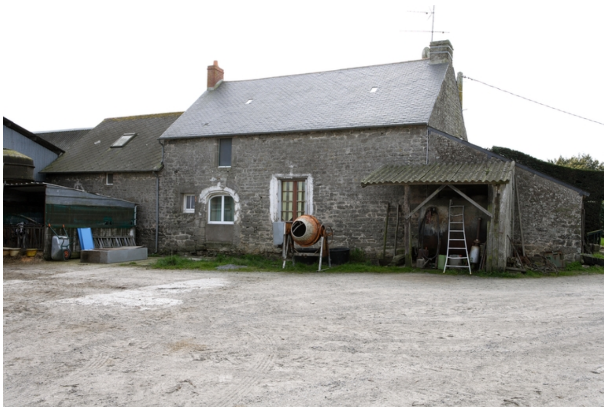
Vue de la façade nord du logis.
