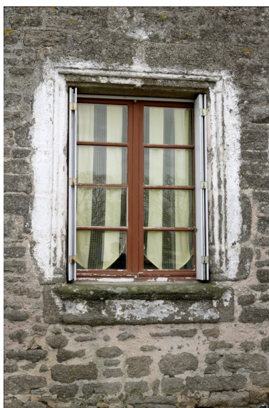
Détail de la croisée de la façade nord.
