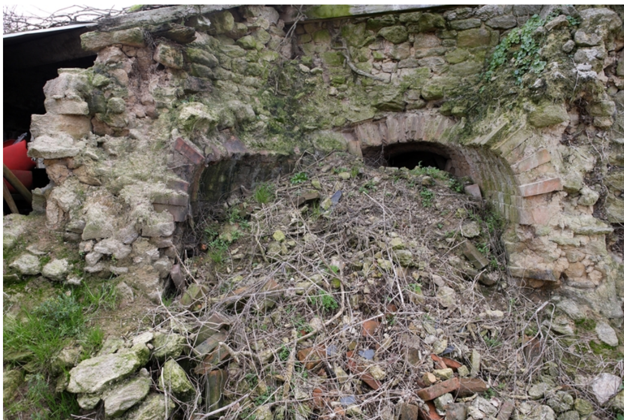
Coupe du cul-de-four en brique du fournil.
