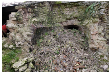
Coupe du cul-de-four en brique du fournil.
