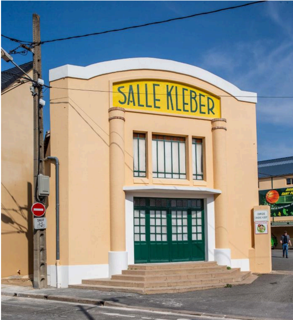
Vue de la salle dite "Kléber" depuis la rue.
