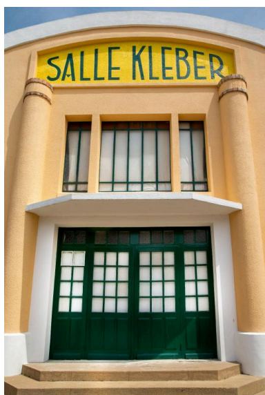
Entrée de la salle dite "Kléber". Phot. Pierre-Bernard Fourny IVR52_20197201366NUCA
