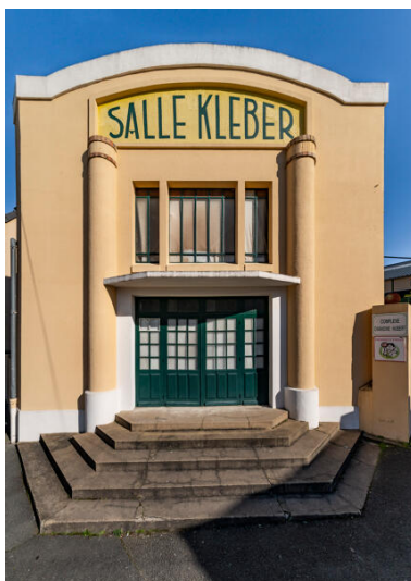
Vue de la façade principale de la salle Kléber. Phot. Thierry Seldubuisson IVR52_20237200285NUCA
