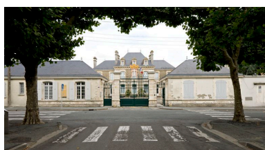
Vue prise de la rue Jean-Jaurès. Phot. Patrice Giraud IVR52_20118500264NUCA
