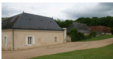
La ferme, aile en retour : façade postérieure sur le chemin. Phot. Jean-Baptiste Darrasse IVR52_20077200514NUCA
