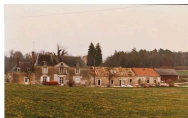
Le logis et la ferme : état avant les travaux. Phot. Jean-Baptiste (reproduction) Darrasse IVR52_20077200505NUCA
