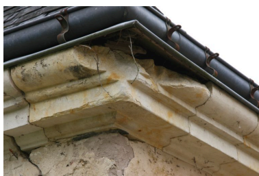
Les écuries : la corniche. Phot. Jean-Baptiste Darrasse IVR52_20077200499NUCA
