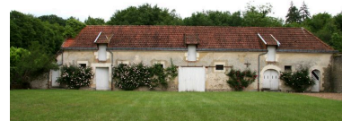
La ferme : remises et étables. Phot. Jean-Baptiste Darrasse IVR52_20077200497NUCA
