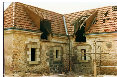
La ferme, aile en retour : les baies en cours de remaniements. Phot. Jean-Baptiste (reproduction) Darrasse IVR52_20077200508NUCA
