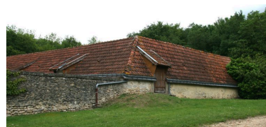
Les étables et remises : aile en retour sur le chemin. Phot. Jean-Baptiste Darrasse IVR52_20077200517NUCA
