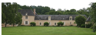
Vue d'ensemble de la façade principale. Phot. Jean-Baptiste Darrasse IVR52_20077200489NUCA
