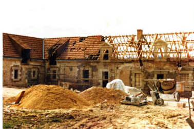
La ferme, façade sur la cour pendant les travaux. Phot. Jean-Baptiste (reproduction) Darrasse IVR52_20077200506NUCA
