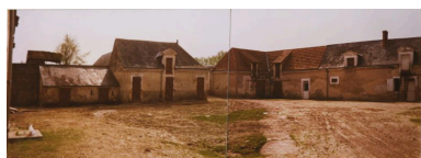
La ferme : l'aile en retour avant les travaux. Phot. Jean-Baptiste (reproduction) Darrasse IVR52_20077200503NUCA
