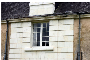
Le logis, façade sur la cour, détail : avant-corps central de bossages allongés. Phot. Jean-Baptiste Darrasse IVR52_20077200501NUCA
