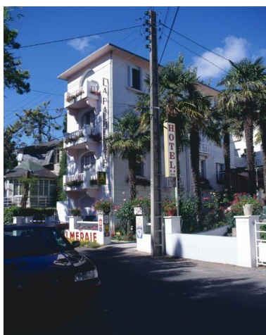
Hôtel de voyageurs La Palmeraie, façade avenue des Cormorans. Phot. Denis Pillet IVR52_19964401341XA
