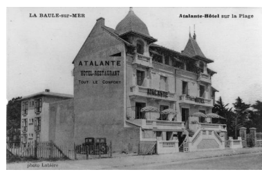
Façade sud de l'ancien hôtel Atalante dit Armorik Hôtel vue du sud-ouest. Phot. Denis (reproduction) Pillet IVR52_19984402561X
