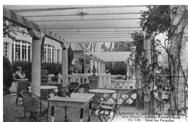
Exposée à l'est, la pergola de l'hôtel de voyageurs Le Pavillon des Fleurs. Phot. Denis (reproduction) Pillet IVR52_19984402599X
