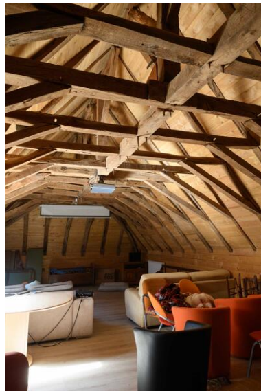
Détail de la charpente du corps de logis. Phot. Armelle Maugin IVR52_20254900279NUCA
