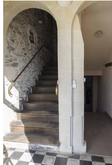
Vue de l'escalier principale rampe-sur-rampe du logis. Phot. Armelle Maugin IVR52_20254900271NUCA
