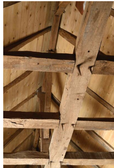
Détail de la charpente du logis. Phot. Armelle Maugin IVR52_20254900280NUCA
