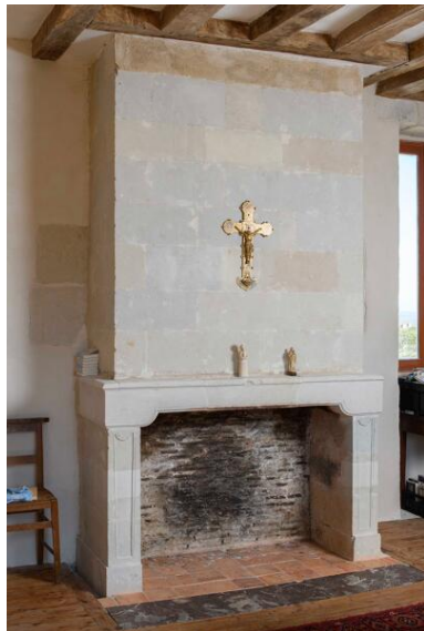
Détail de la cheminée de la chambre sud-est. Phot. Armelle Maugin IVR52_20254900277NUCA
