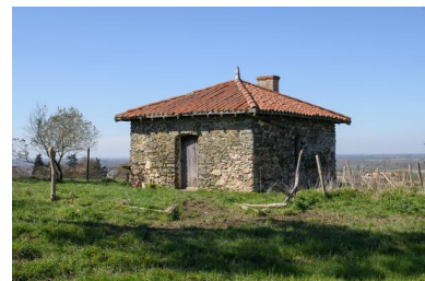
Vue de l'ancien pavillon de jardin, actuellement transformé en bergerie. Phot. Armelle Maugin IVR52_20254900294NUCA
