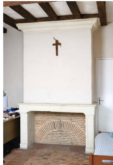
Détail de la cheminée de la chambre sud-ouest. Phot. Armelle Maugin IVR52_20254900276NUCA
