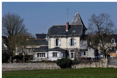
Vue de la façade sur Loire depuis le sud-est. Phot. Bruno Rousseau IVR52_20164900221NUCA
