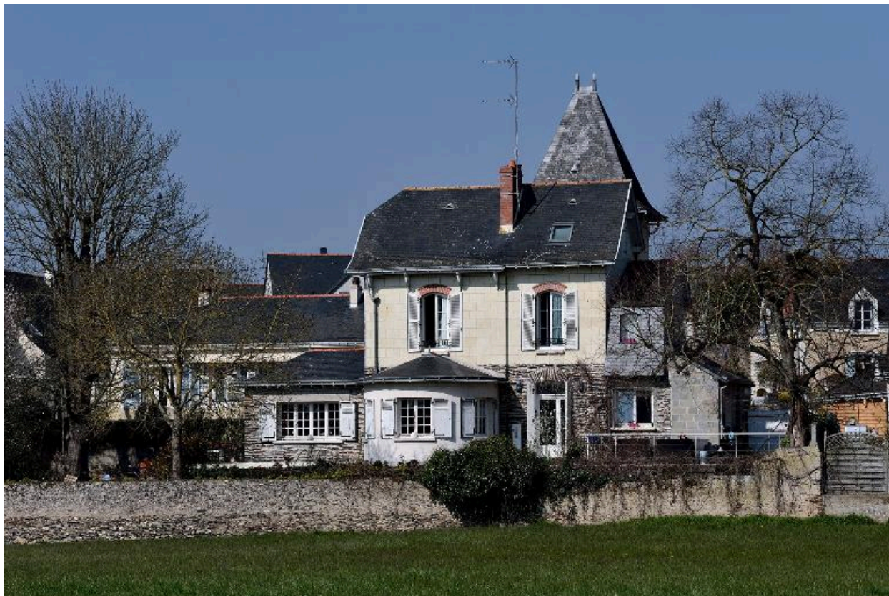
Vue de la façade sur Loire depuis le sud-est.
