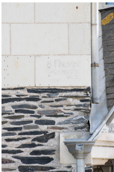
Détail de l'inscription : H. Palausi, Architecte, D.P.L.G, 1908. Phot. Armelle Maugin IVR52_20204900453NUCA
