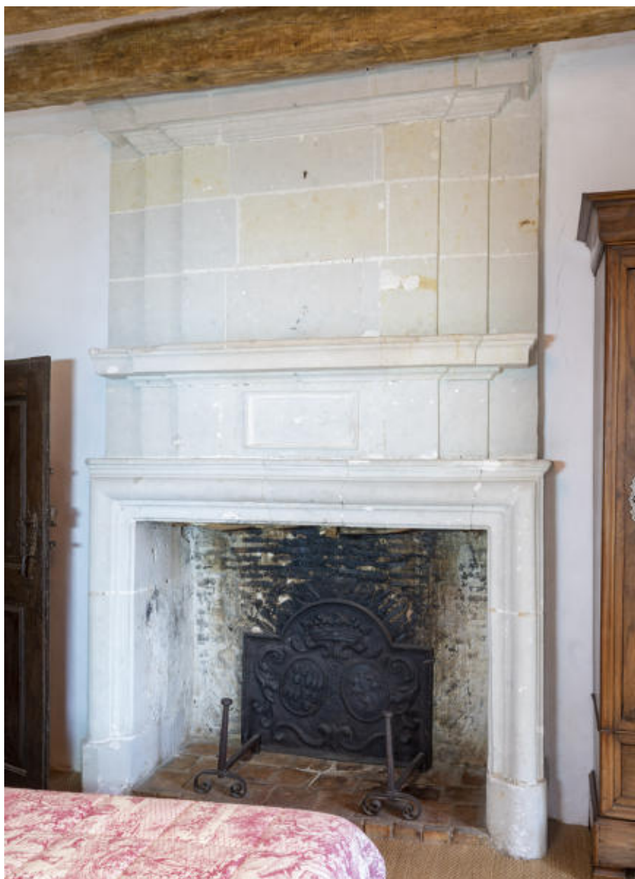
Une cheminée de l'étage.
