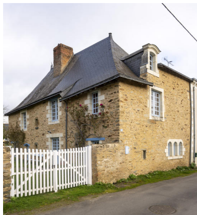
La maison depuis la rue. Phot. Pierre-Bernard Fourny IVR52_20225300359NUCA
