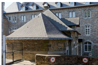
3 : à l'arrière, façade nord du bâtiment de la Communauté. Phot. Denis Pillet IVR52_20134402171NUCA
