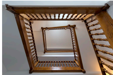
3 : escalier rampe sur rampe. Phot. Denis Pillet IVR52_20134402069NUCA
