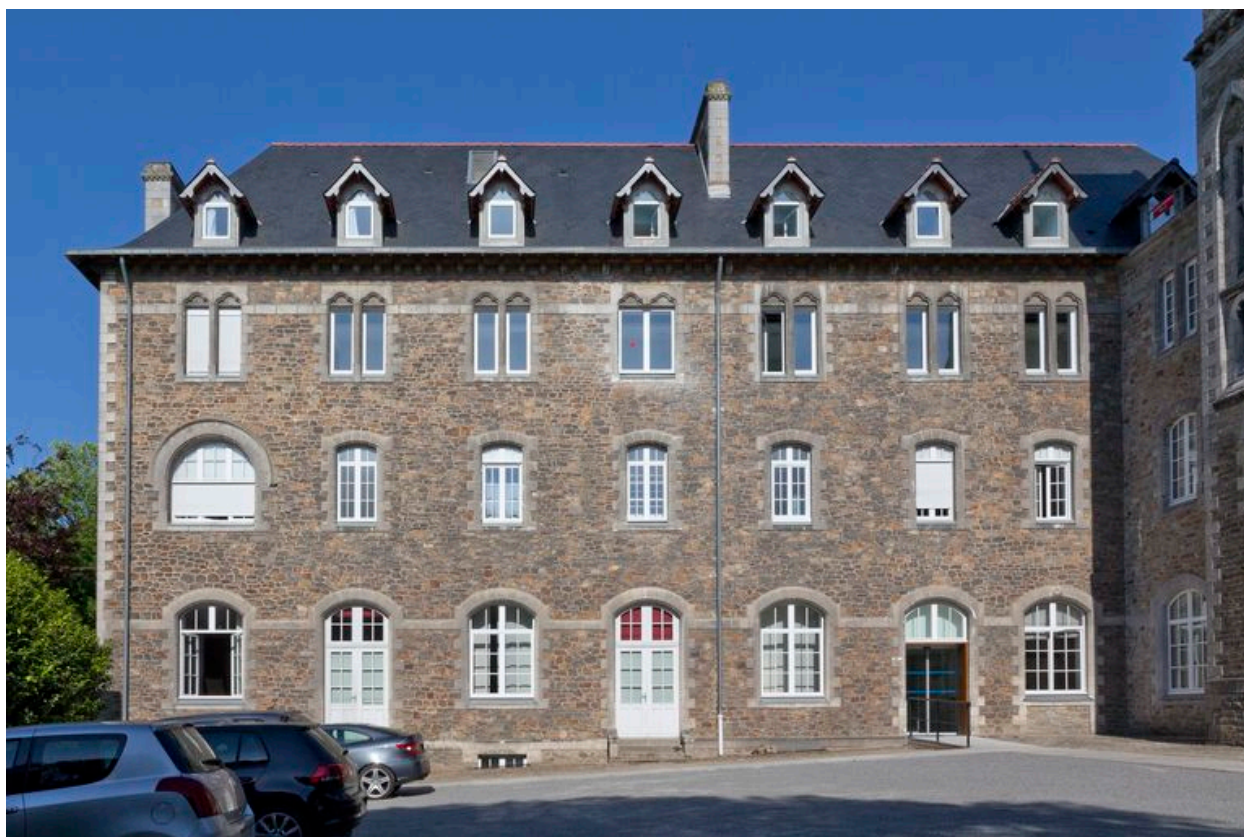
3 : bâtiment de la communauté, façade est.
