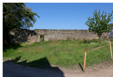
Ancien mur de clôture. Phot. Denis Pillet IVR52_20134402202NUCA
