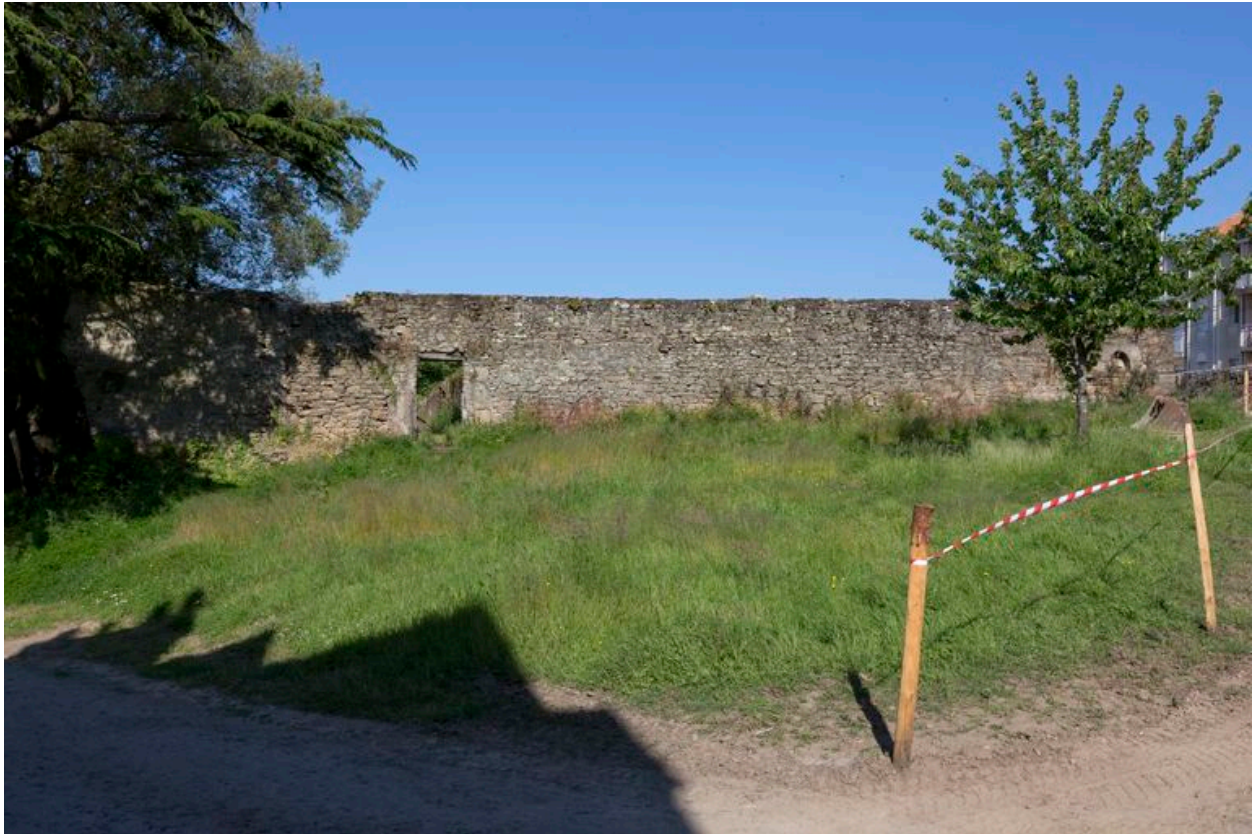
Ancien mur de clôture.
