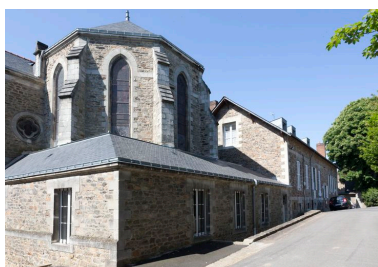
2 : infirmerie et chevet de la chapelle. Phot. Denis Pillet IVR52_20134402223NUCA
