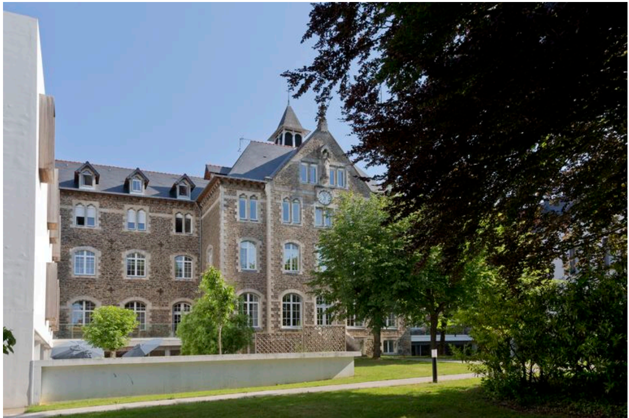
3 : bâtiment de la communauté, façade sud.
