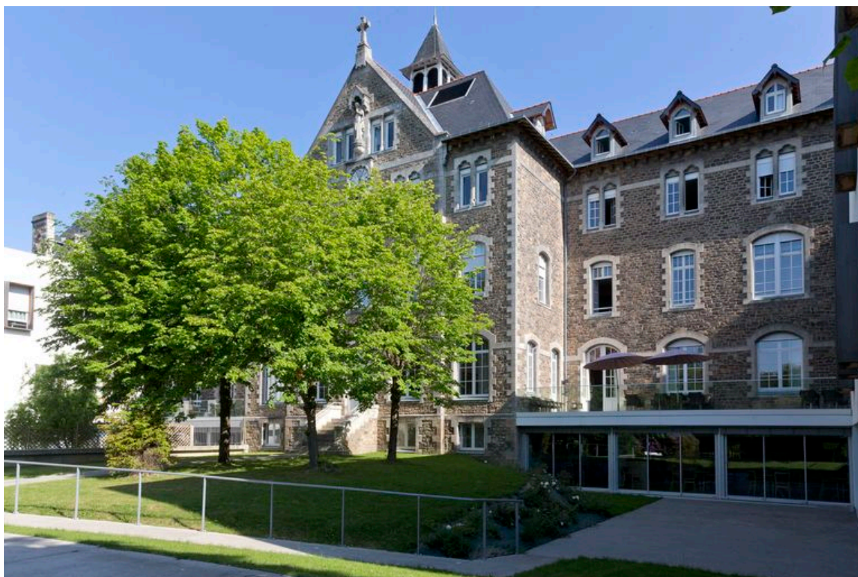
3 : bâtiment de la communauté, façade sud.
