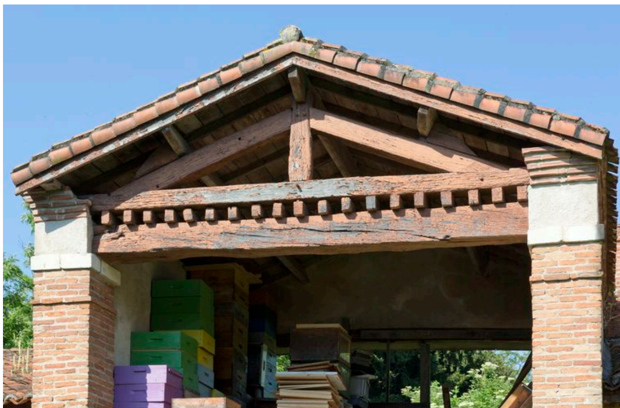
11 : détail du porche avec les poutres peintes en rouge.
