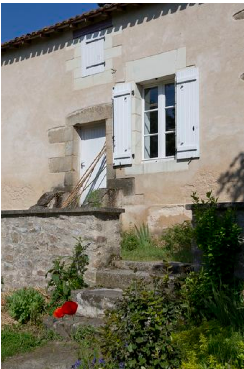
10 : détail de l'emmarchement de la maison au nord.
