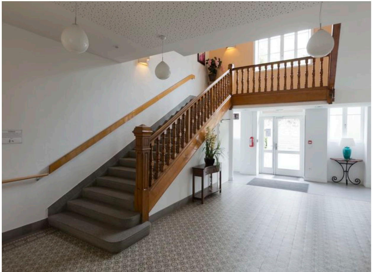
3 : escalier rampe sur rampe.
