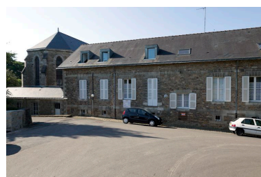
2 : infirmerie, façade nord. Phot. Denis Pillet IVR52_20134402169NUCA
