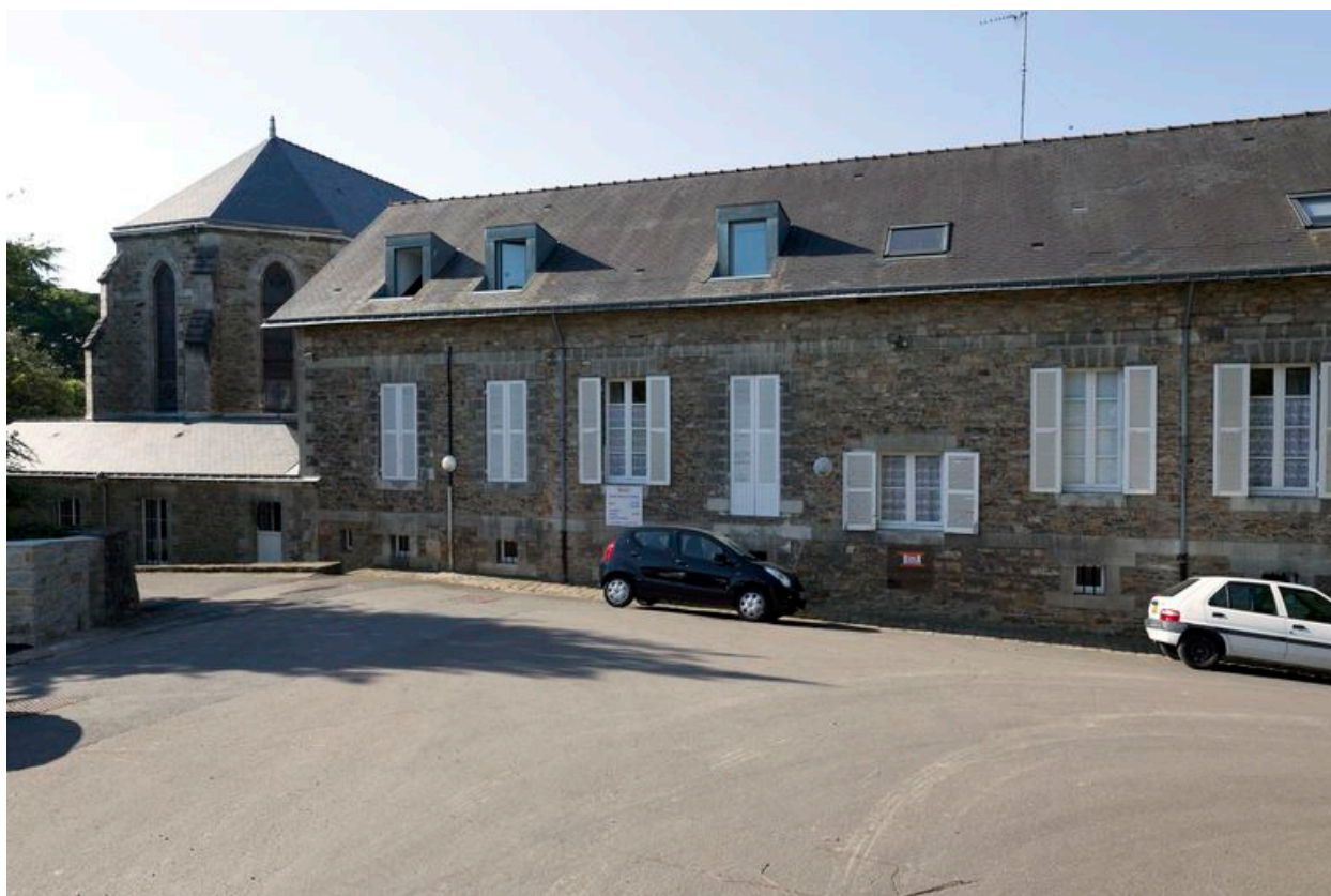
2 : infirmerie, façade nord.
