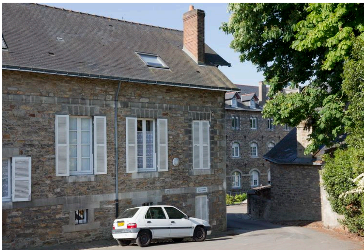
2 : infirmerie, façade nord et passage vers le bâtiment de la communauté.
