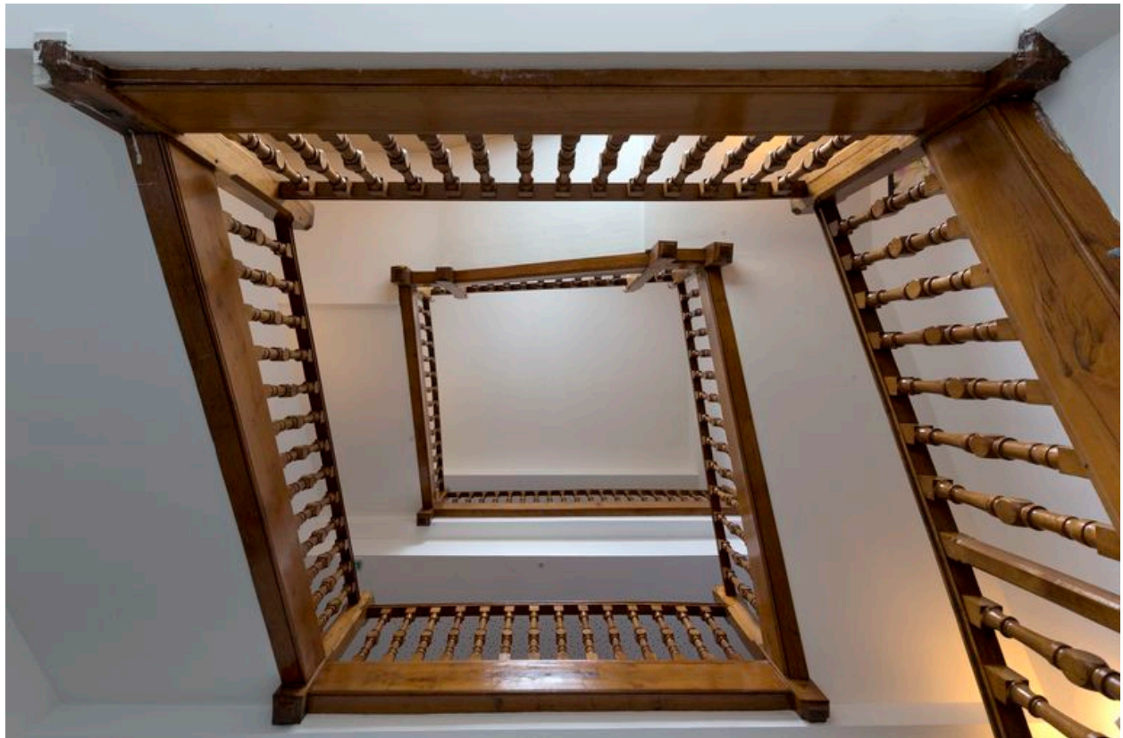
3 : escalier rampe sur rampe.
