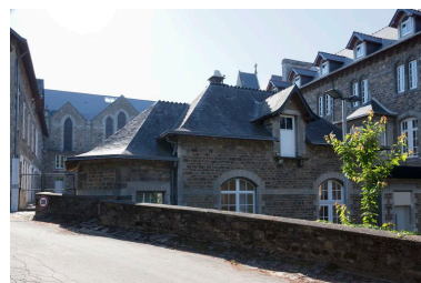
3 : à gauche, façade nord du bâtiment de la Communauté. Phot. Denis Pillet IVR52_20134402174NUCA
