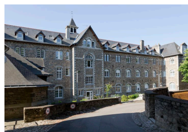
3 : bâtiment de la communauté, façade nord. Phot. Denis Pillet IVR52_20134402173NUCA
