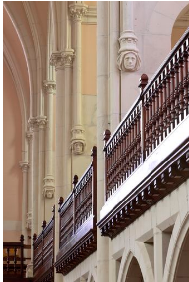
4 : galerie supérieure. Phot. Denis Pillet IVR52_20134402068NUCA
