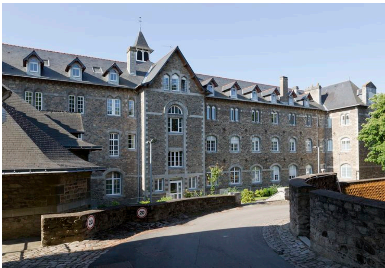
3 : bâtiment de la communauté, façade nord.
