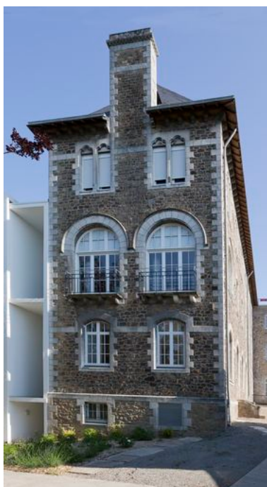
3 : bâtiment de la communauté, façade sud de l'aile est. Phot. Denis Pillet IVR52_20134402182NUCA
