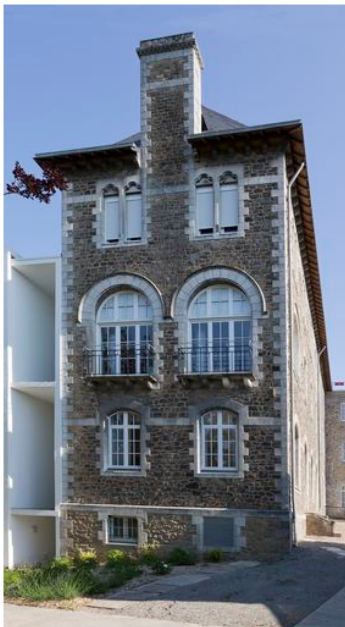
3 : bâtiment de la communauté, façade sud de l'aile est.
