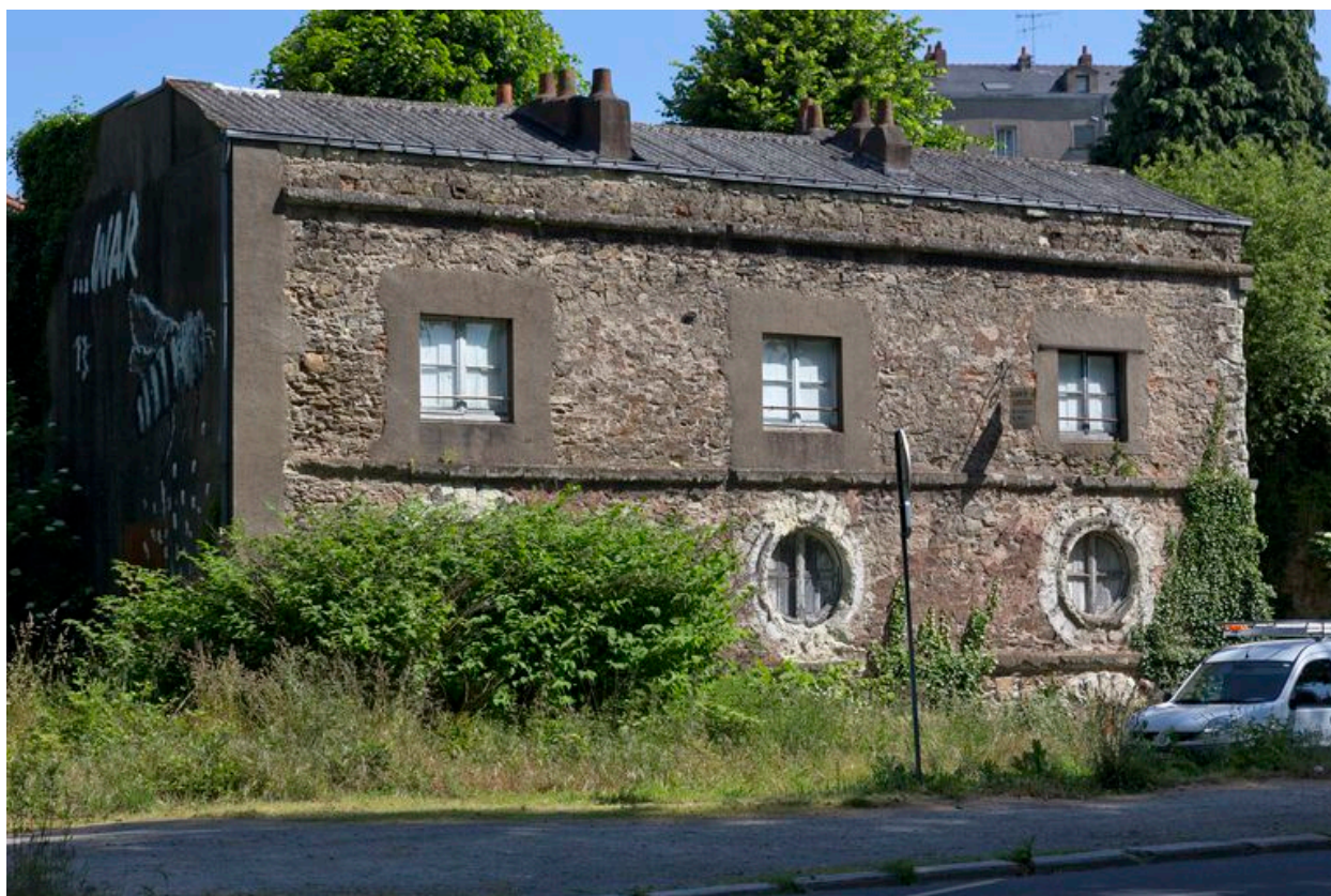
12 : maison de l'apiculture, façade donnant sur le boulevard de Cardiff.
