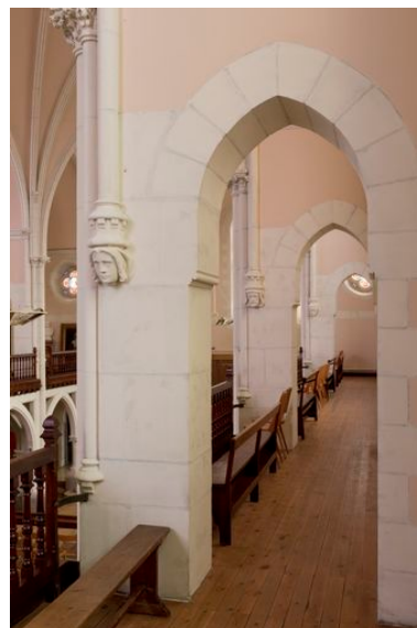
4 : galerie supérieure. Phot. Denis Pillet IVR52_20134402061NUCA
