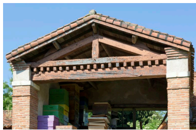
11 : détail du porche avec les poutres peintes en rouge. Phot. Denis Pillet IVR52_20134402211NUCA
