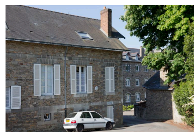
2 : infirmerie, façade nord et passage vers le bâtiment de la communauté. Phot. Denis Pillet IVR52_20134402170NUCA
