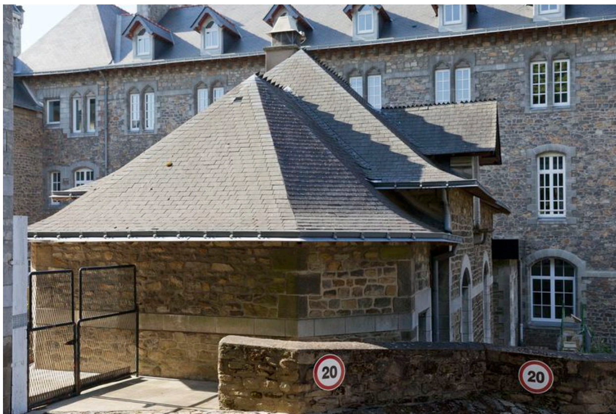
3 : à l'arrière, façade nord du bâtiment de la Communauté.
