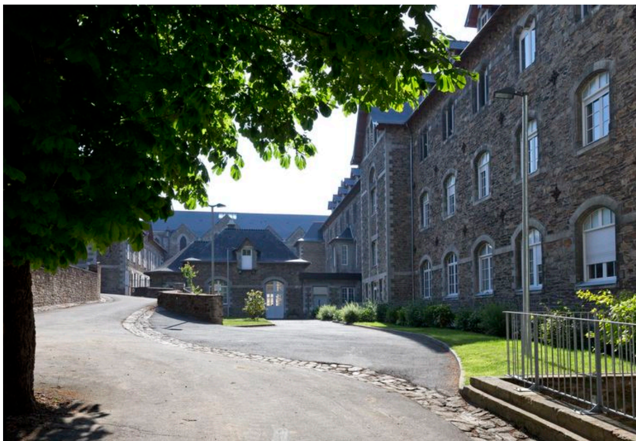
3 : bâtiment de la communauté, façade nord.
