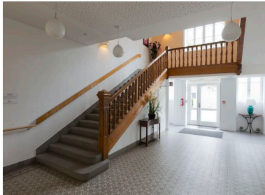
3 : escalier rampe sur rampe. Phot. Denis Pillet IVR52_20134402070NUCA
