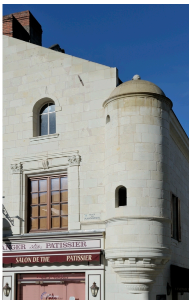
Détail de la tourelle. Phot. Bruno Rousseau IVR52_20124901934NUCA
