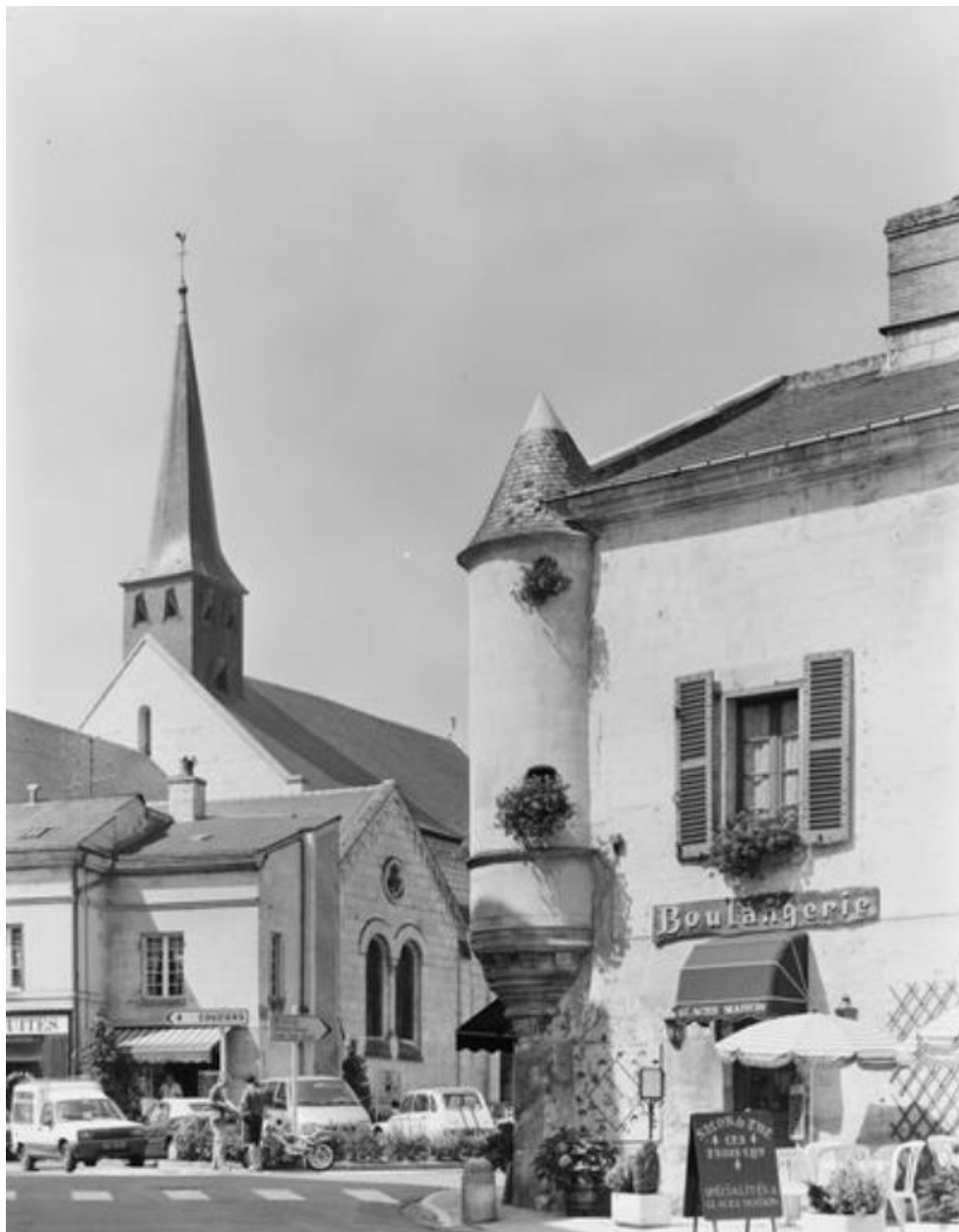
La place des Plantagenêts et l'angle de la maison, avant restauration (en 1994).
