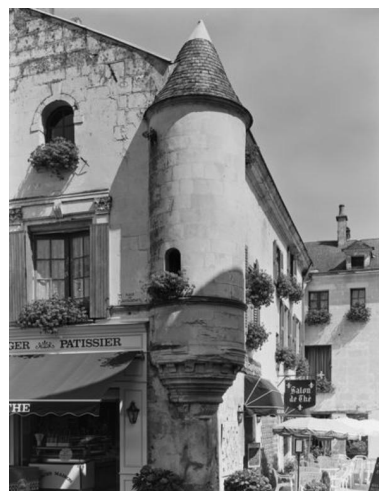
Détail de la tourelle, avant restauration (en 1994). Phot. Bruno Rousseau IVR52_19944900666V
