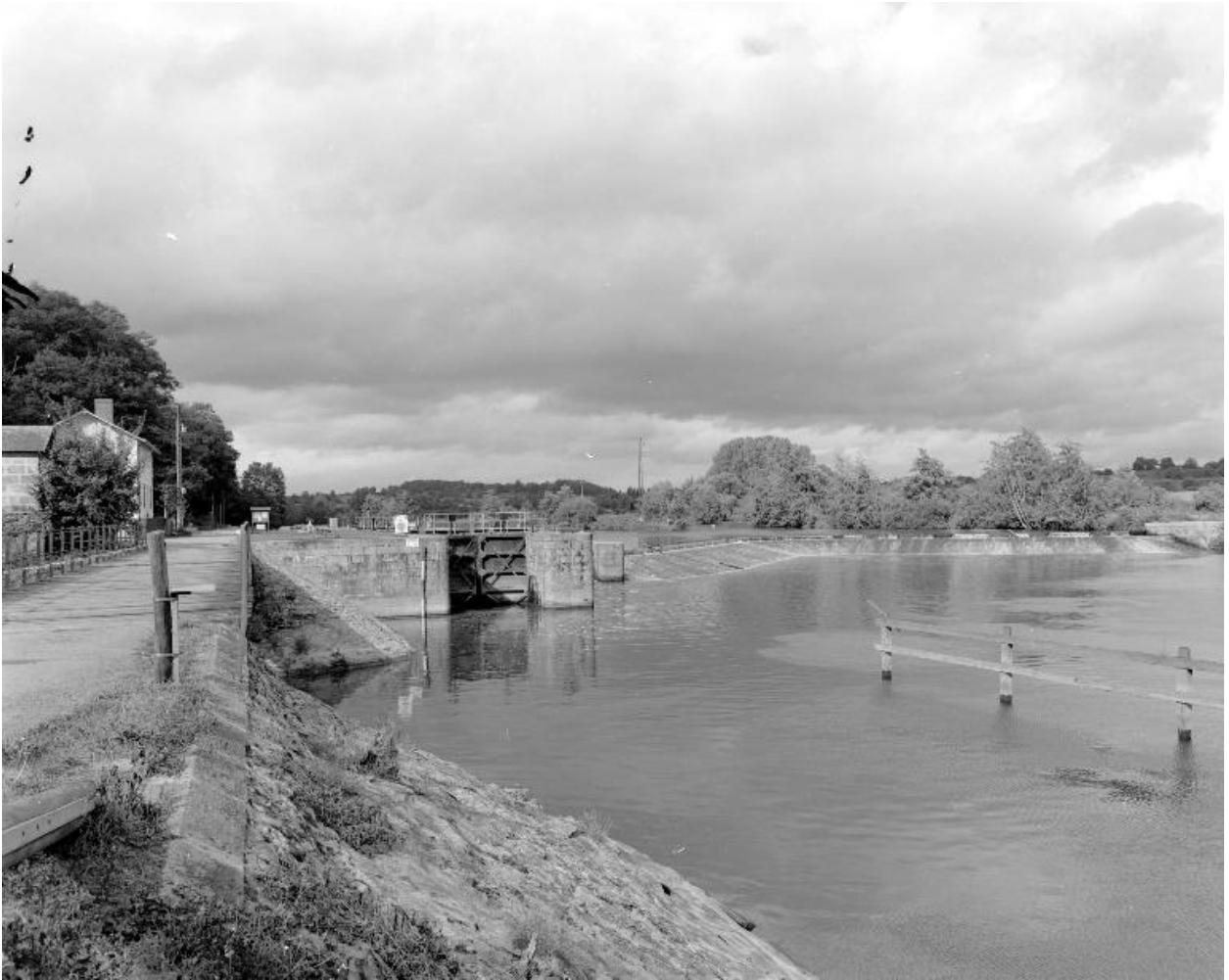
Vue d'ensemble du site depuis la rive droite en aval : maison éclusière, écluse, barrage. Au premier plan, la passerelle enjambant le canal de fuite de la centrale hydroélectrique.
