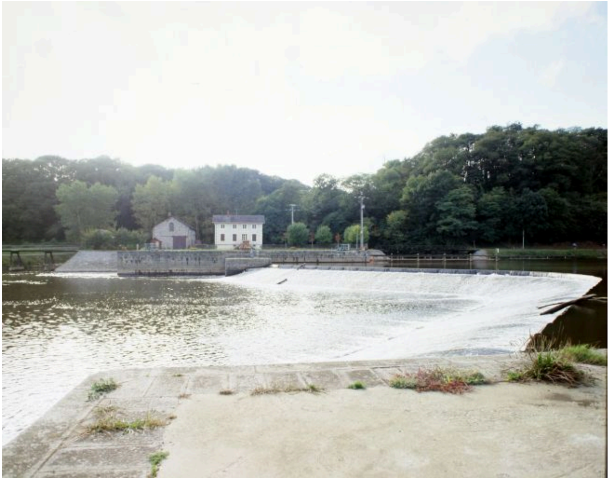
Vue d'ensemble du site depuis la rive gauche : barrage, maison éclusière, centrale hydroélectrique. A droite et à gauche, les deux passerelles enjambant le canal d'alimentation et le canal de fuite de la centrale hydroélectrique.
