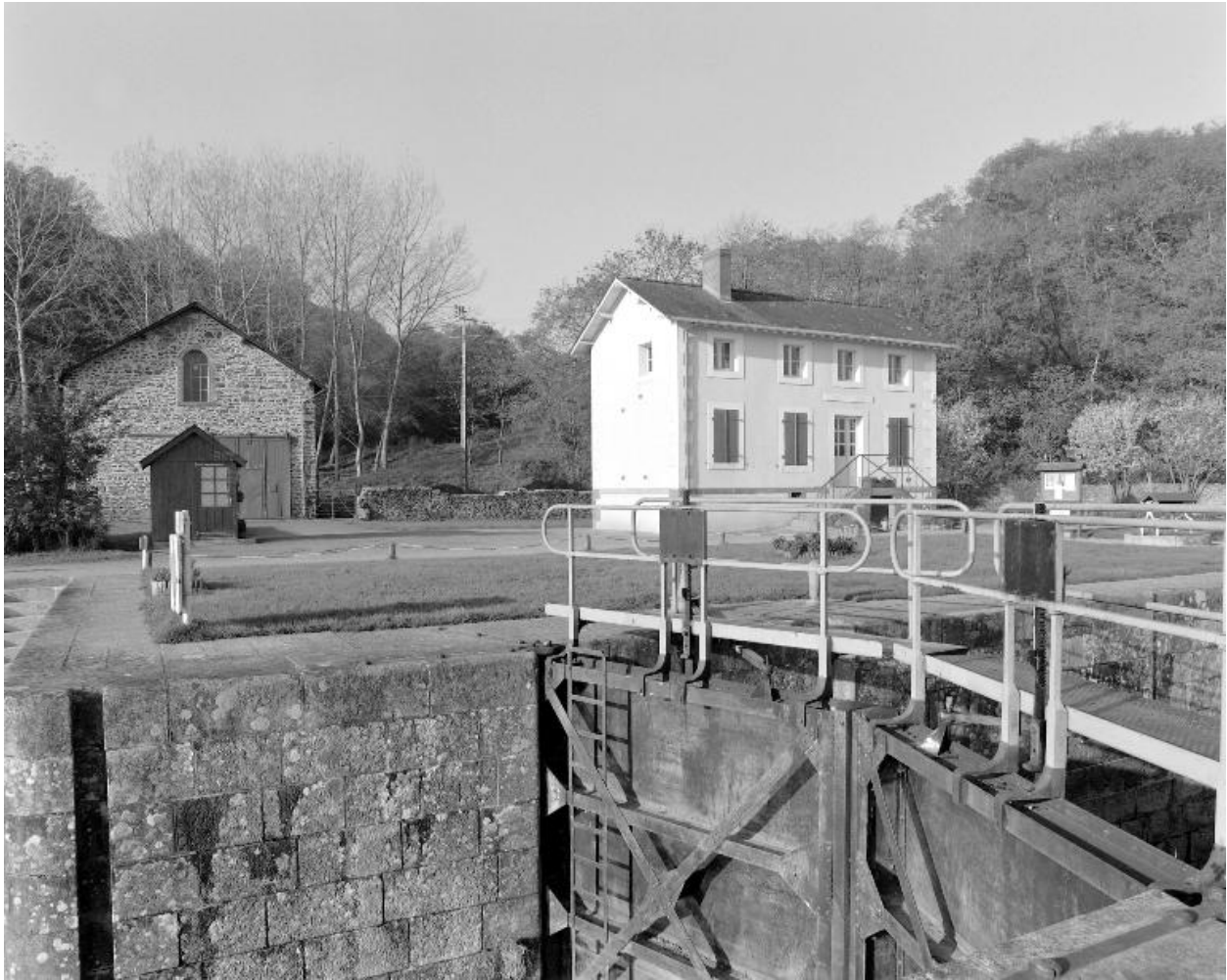
La centrale hydroélectrique, la maison éclusière et les portes aval de l'écluse, vus de l'est.
