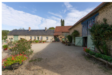
Vue d'ensemble. Phot. Jeanne Minier IVR52_20257200494NUCA
