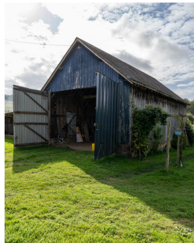
Remise agricole. Phot. Jeanne Minier IVR52_20257200500NUCA
