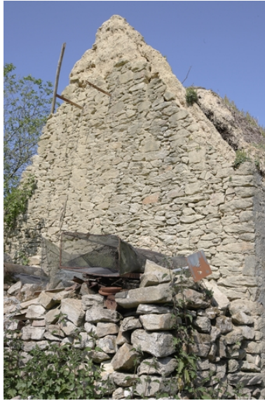
Vue du pignon oriental en bauge. Phot. Denis Pillet IVR52_20104401065NUCA
