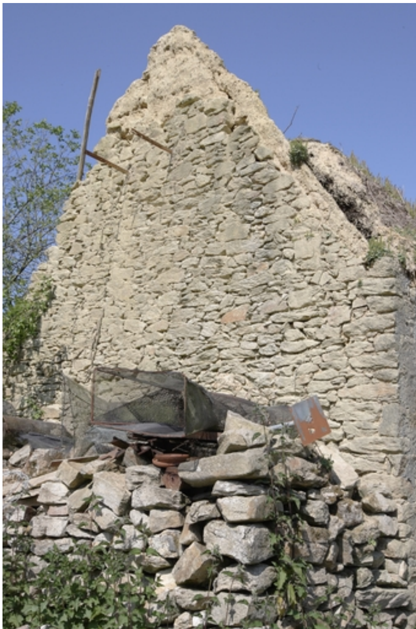
Vue du pignon oriental en bauge.
