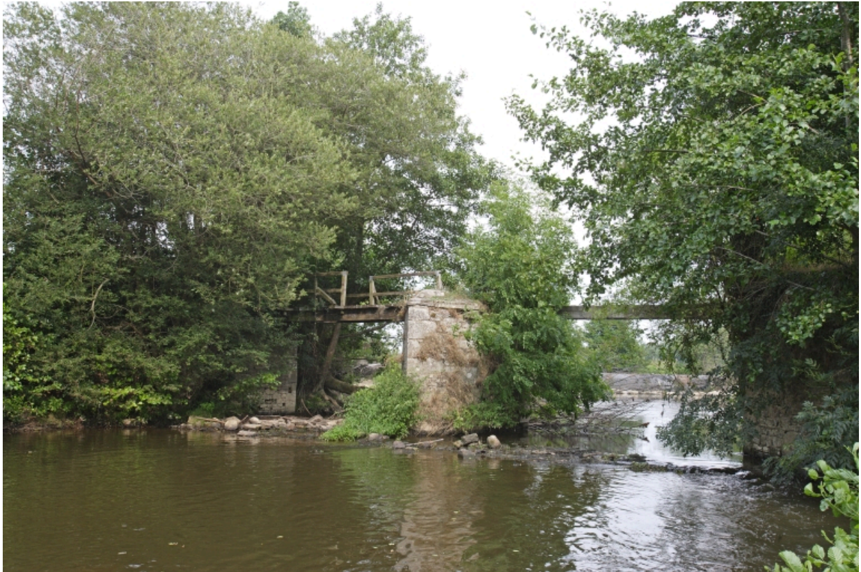
Vue d'ensemble depuis la rive gauche du bras de rivière, en aval.
