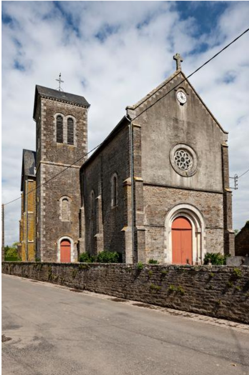
Vue d'ensemble depuis le sud de l'église Saint-Laurent de la Baroche-Gondouin.
