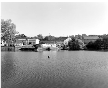
Vue d'ensemble de l'usine depuis la rive droite. Au premier plan, le soubassement du moulin à scier le marbre, détruit. Phot. François Lasa IVR52_20015300479X
