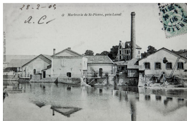
Vue d'ensemble de l'usine depuis la rive droite. Phot. Hamel-Jallier et Cie, Phot. Pierre-Bernard Fourny IVR52_20235300087NUCA
