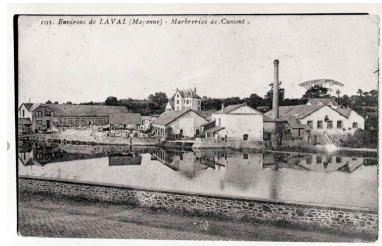
Vue d'ensemble de l'usine depuis la rive droite. Repro. François Lasa IVR52_20025300800X
