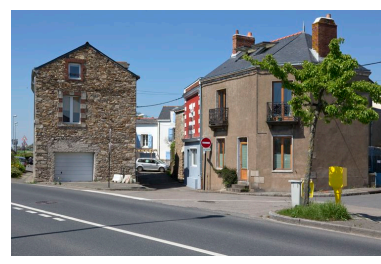
Angle rue Durance et route de Roche-Maurice. Phot. Denis Pillet IVR52_20134401696NUCA
