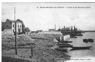
Cale et nouveaux quais, début du XXe siècle. Phot. Caroline (reproduction) guillemaut IVR52_20134401547NUCA
