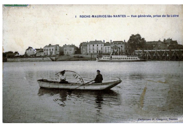
Vue générale de Roche-Maurice, 1914 Phot. Caroline (reproduction) guillemaut IVR52_20134401546NUCA
