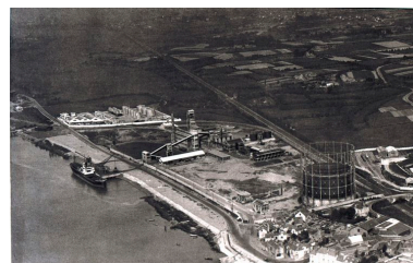
Vue a erienne de l'usine   gaz de Roche-Maurice. IVR52_20134401541NUCA
