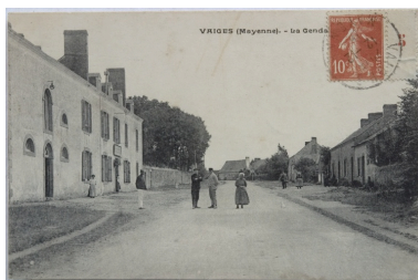
Carte postale, début du 20e siècle. La maison est au fond, dans l'axe de la route. Repro. François Lasa IVR52_20045303241NUCA
