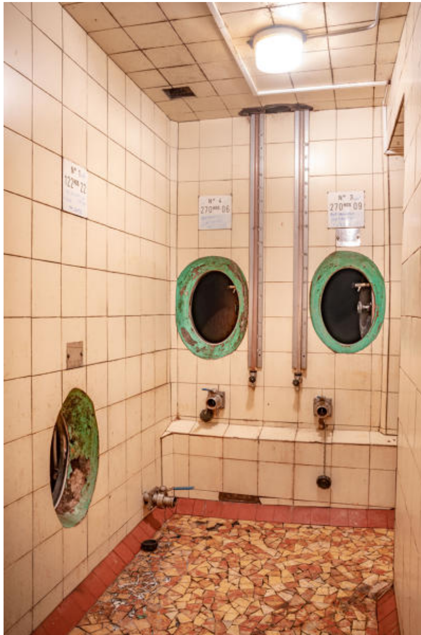
Couloir de service et cuves partiellement enterrées, au négoce Bahuaud de la Chapelle-Heulin.
