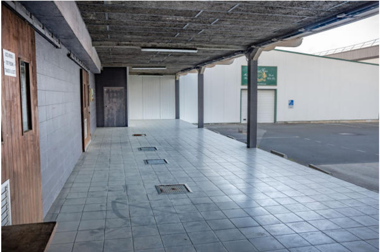
Trappes de cuves enterrées sur l'un des quais du négoce Bahuaud, la Chapelle-Heulin.
