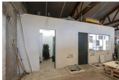
Trappes de cuves enterrées, à l'entrée des bureaux du négoce Giraud, la Haie-Fouassière. Phot. Pierre-Bernard Fourny IVR52_20224400360NUCA
