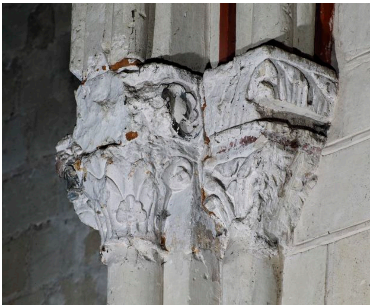
Support nord de la seconde travée de la nef. Chapiteaux et tailloirs des colonnes engagées, ornés de feuillages et d'un éléphant (?) en bas-relief (vue prise en 1991).
