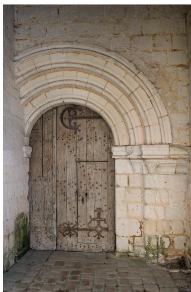
Portail nord (fin XIIe ou début XIIIe siècle), avec voussure plein-cintre appareillée en rouleaux à ressauts. La porte bâtarde, à porte-guichet, conserve ses pentures d'origine.
