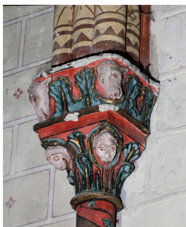
Support sud de la travée d'avant-choeur. Chapiteau et tailloir de la colonne engagée, ornés de feuillages et aux angles de têtes d'animaux en bas-relief (vue prise en 1991). Phot. Bruno Rousseau
