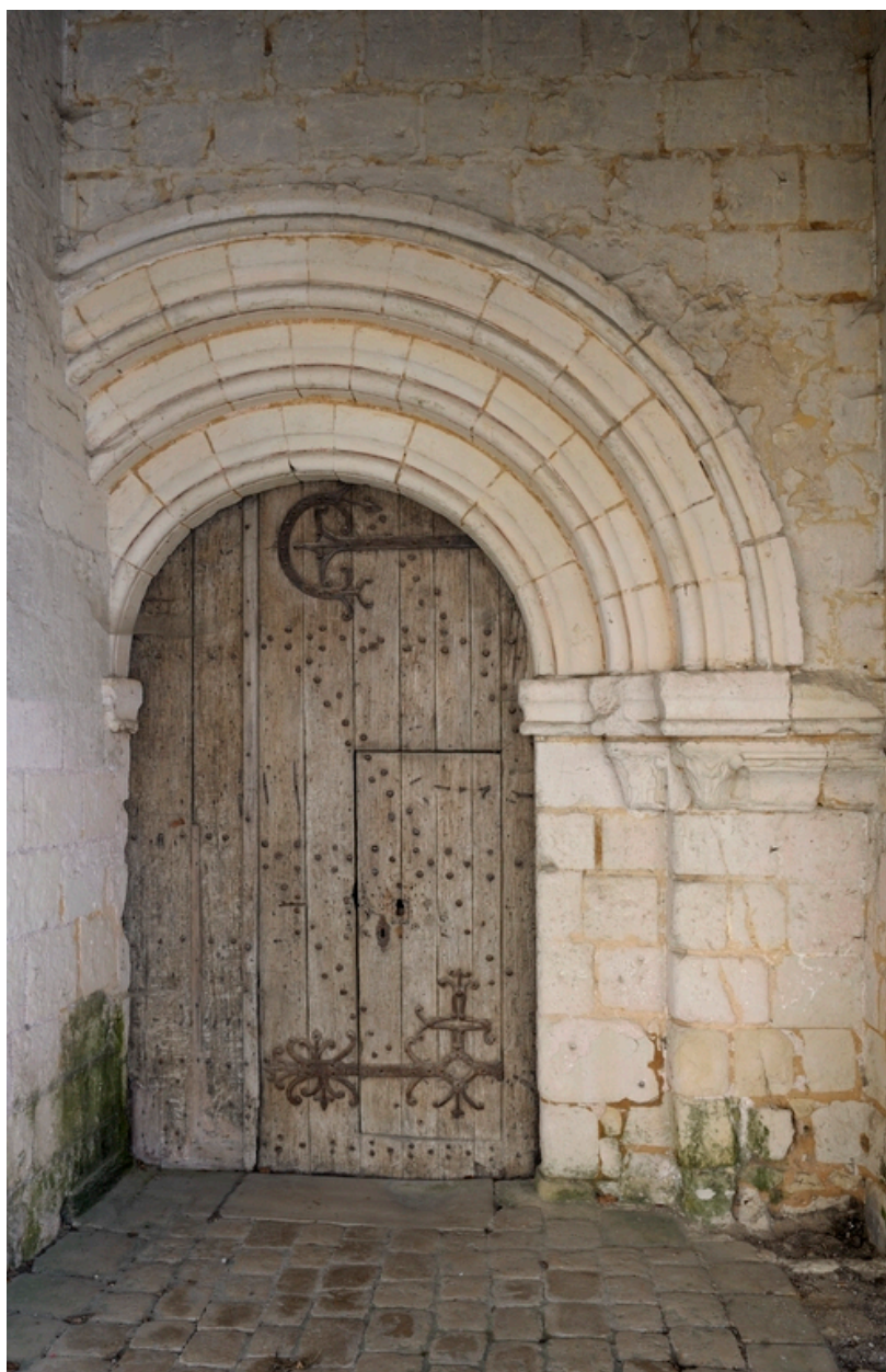
Portail nord (fin XIIe ou début XIIIe siècle), avec voussure plein-cintre appareillée en rouleaux à ressauts. La porte bâtarde, à porte-guichet, conserve ses pentures d'origine.
