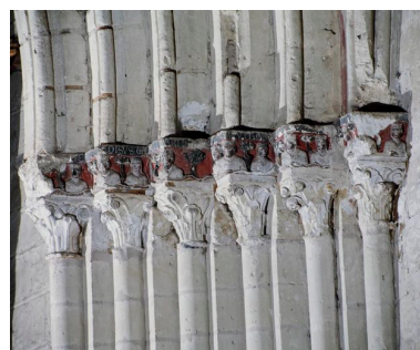
Support sud de la seconde travée de la nef. Chapiteaux et tailloirs des colonnes engagées, ornés de figures en bas-relief : les élus (vue prise en 1991). Phot. Bruno Rousseau IVR52_19914902201XA
