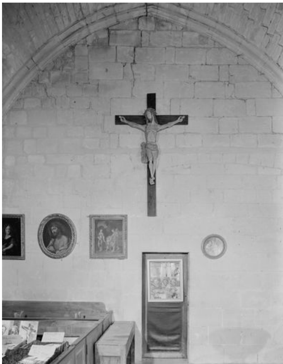
Chapelle Saint-Joseph, mur ouest (vue prise en 1991).
