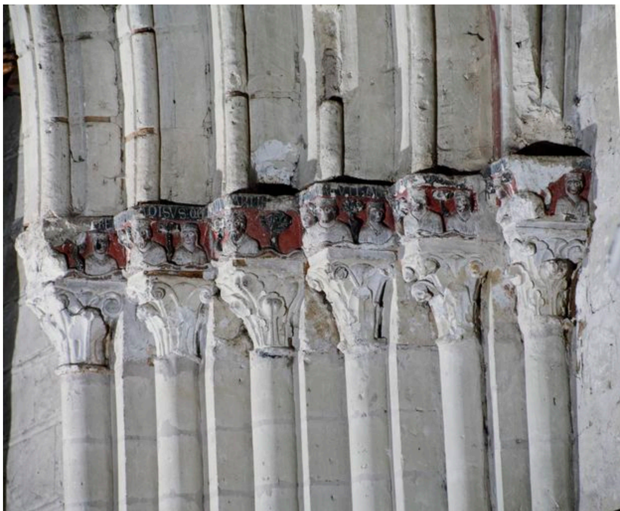
Support sud de la seconde travée de la nef. Chapiteaux et tailloirs des colonnes engagées, ornés de figures en bas-relief : les élus (vue prise en 1991).
