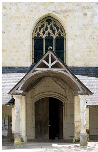
Façade occidentale, portail de l'église avec porte et fenêtre en tympan inscrites dans la même embrasure. Porte couverte d'un arc segmentaire et surmontée d'une accolade élancée. Fenêtre à trois lancettes et remplage flamboyant à soufflets et mouchettes.
