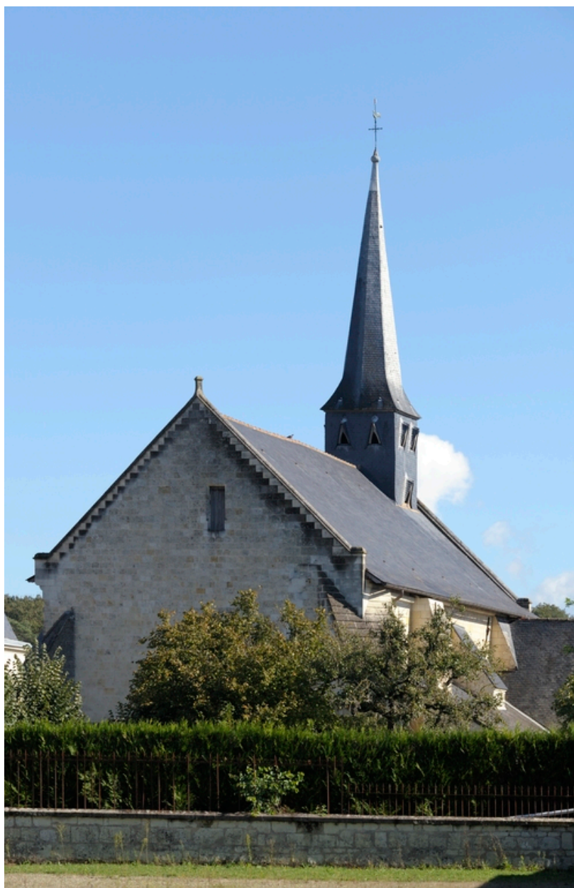
Vue d'ensemble depuis le sud-ouest de l'église.
