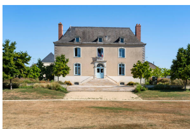
La façade sur la Mayenne. Phot. Thierry Seldubuisson IVR52_20225300809NUCA
