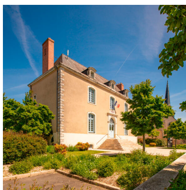
La façade sur la Mayenne. Phot. Pierre-Bernard Fourny IVR52_20235300490NUCA
