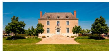
La façade sur la Mayenne. Phot. Pierre-Bernard Fourny IVR52_20235300488NUCA
