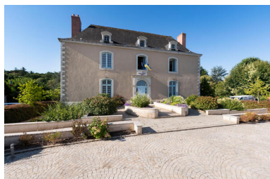
La façade sur rue. Phot. Thierry Seldubuisson IVR52_20225300785NUCA
