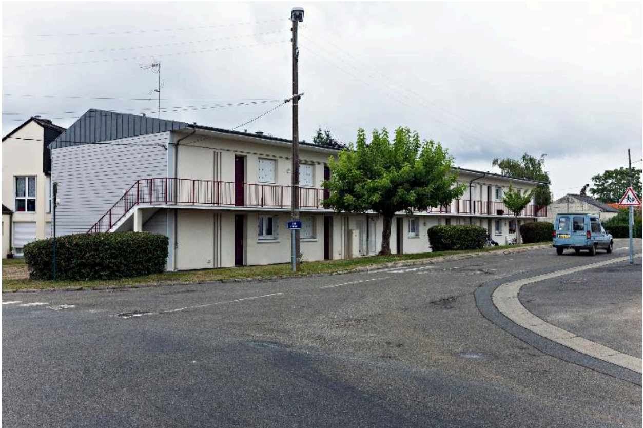
2e lotissement concerté, 3e tranche : logements collectifs de la rue Branly.
