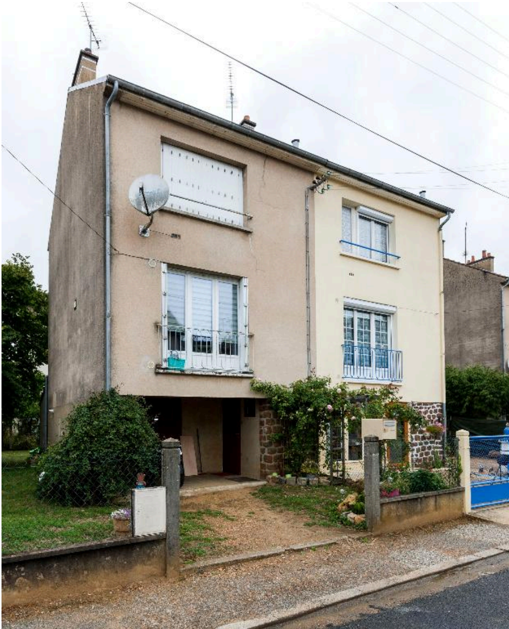
Elévation antérieure des maisons jumelles 6-8, rue du docteur Roux. A noter la porte d'entrée de la maison reportée sur le côté de la porte du garage.
