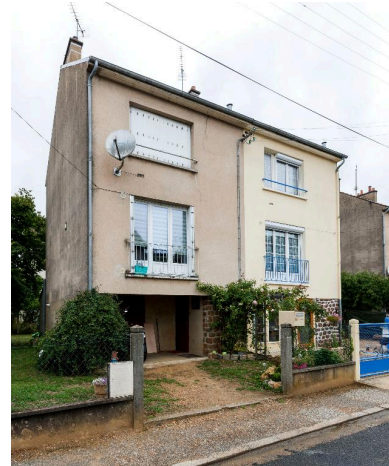
Elévation antérieure des maisons jumelles 6-8, rue du docteur Roux. A noter la porte d'entrée de la maison reportée sur le côté de la porte du garage. Phot. Yves Guillotin IVR52_20177200776NUCA
