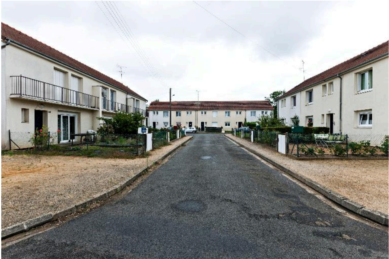
2e lotissement concerté, tranche 1 et 2, rue Joliot-Curie : vue générale.
