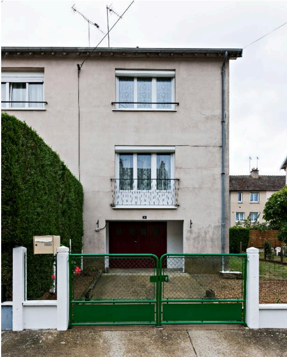
Elévation antérieure de la maison 9, rue du docteur Roux.
