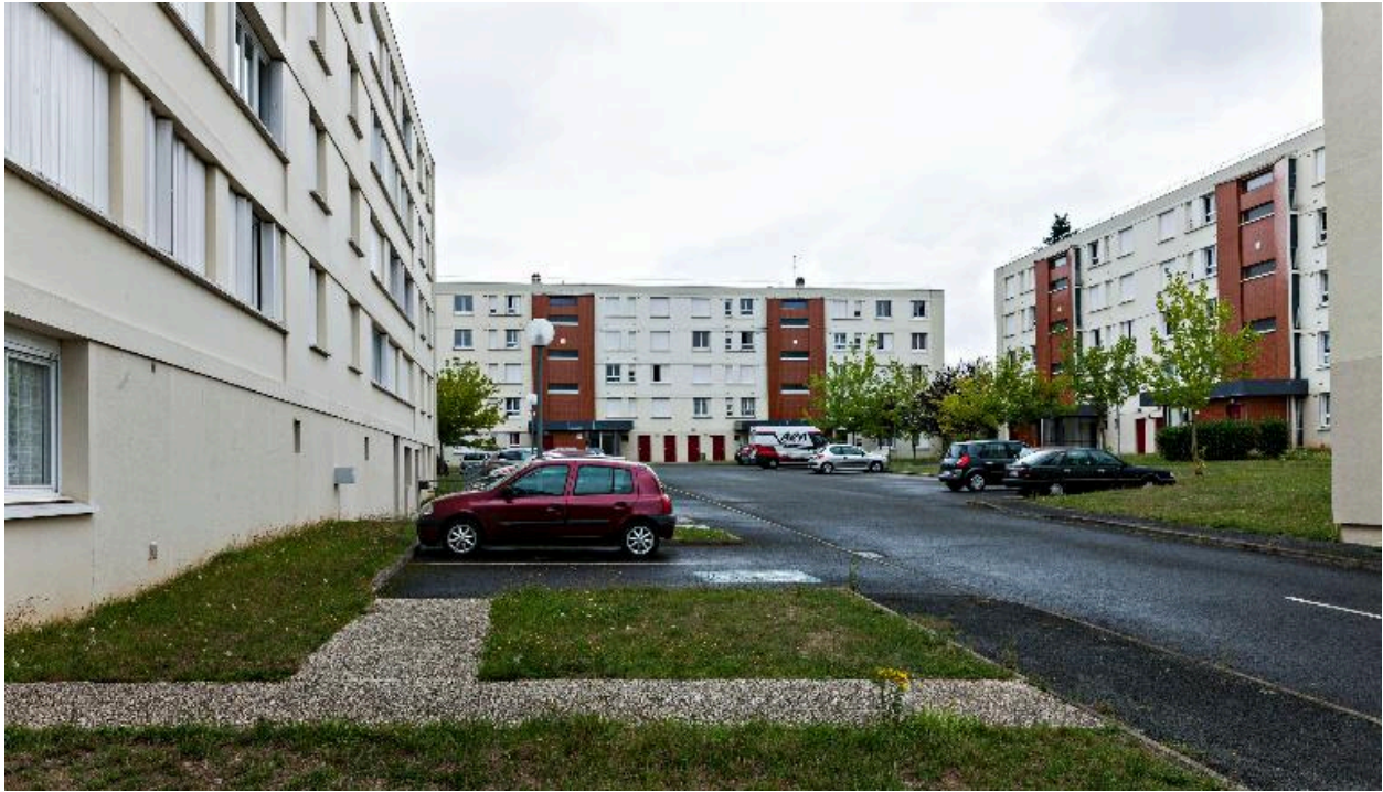
Grand ensemble des Bordelières, état actuel après reprise des élévations.
