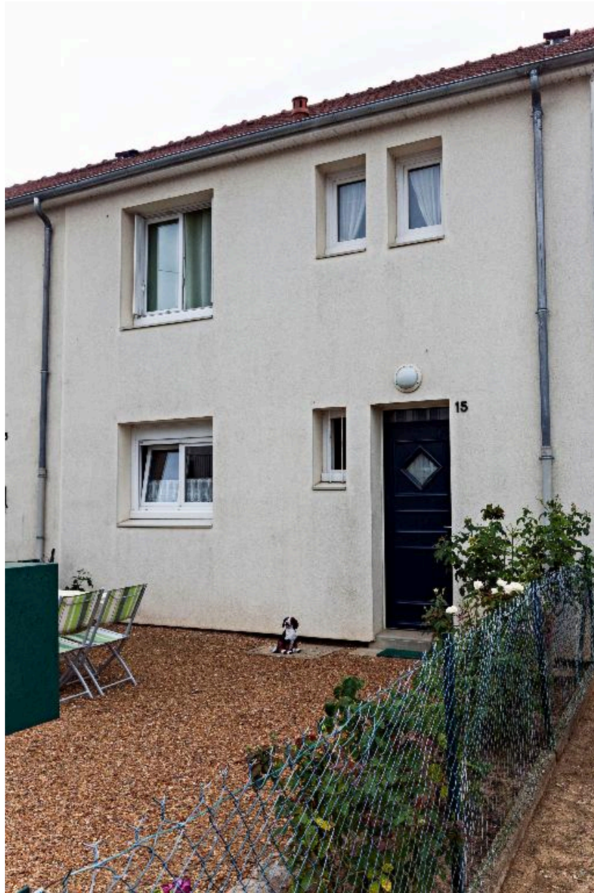
Elévation antérieure de la maison 15, rue Jolliot-Curie.
