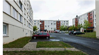
Grand ensemble des Bordelières, état actuel après reprise des élévations. Phot. Yves Guillotin IVR52_20177200778NUCA
