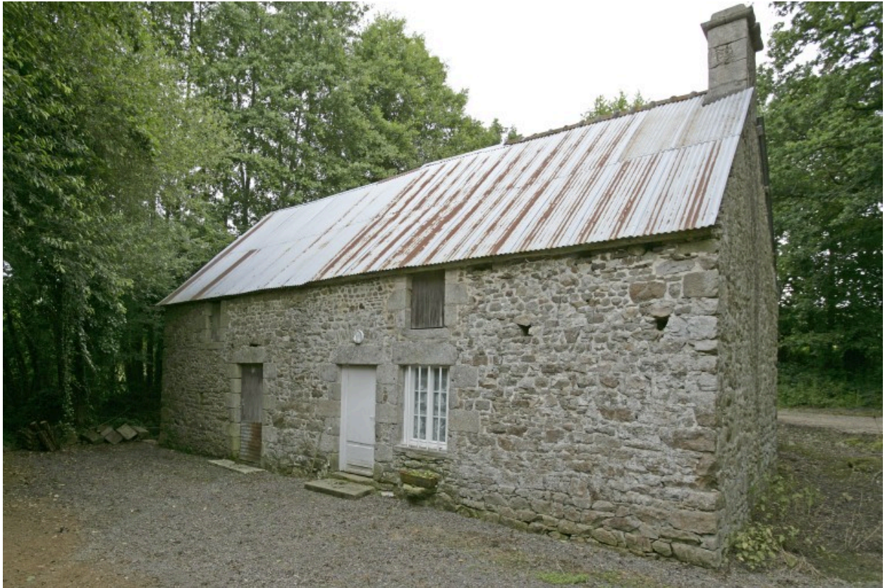
Le logis vu depuis le sud.
