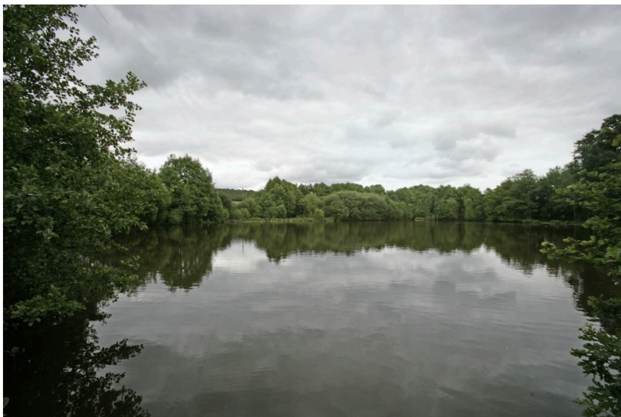
L'étang de retenue vu depuis le chemin-digue à l'ouest.
