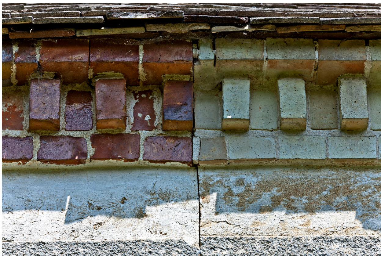
Corniche en briques du logis de la ferme des Noës.
