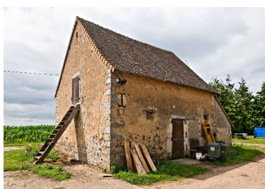
Maconnerie de moellons enduits avec chaînes d'angles de grès de l'écurie de La Guillotière. Phot. Yves Guillotin IVR52_20147201781NUCA
