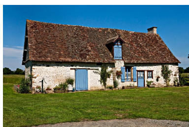
Maçonnerie de moellons enduits, remplaçant un pan-de-bois, du logement de La Plumardière I. Phot. Yves Guillotin IVR52_20147201706NUCA
