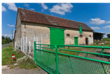
Maçonnerie enduite de la grange-étable du Petit Tronchet. Phot. Yves Guillotin IVR52_20147202006NUCA
