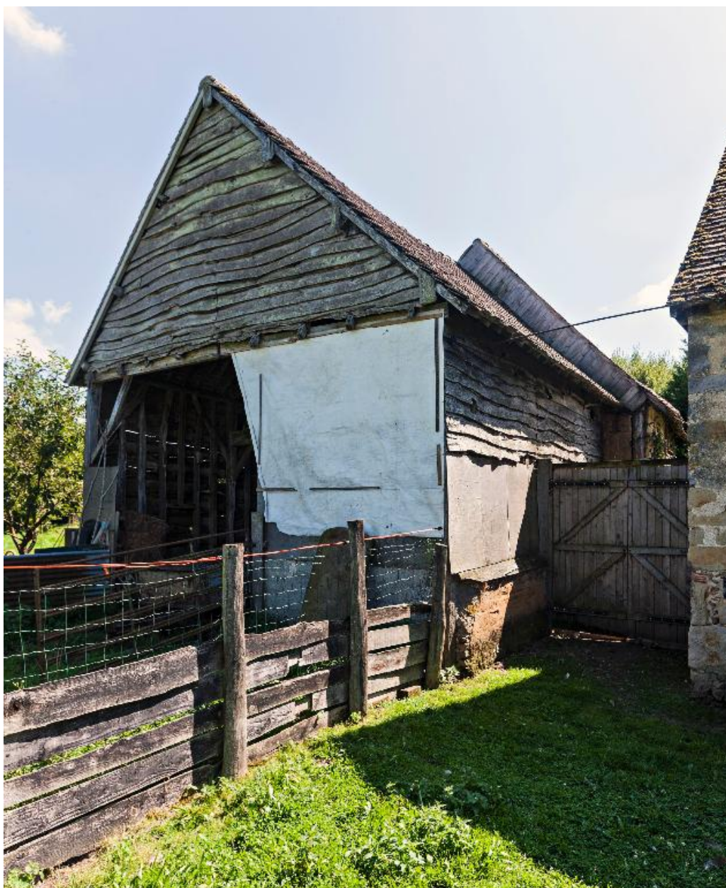
Remise sur poteaux, essentée de planches, de la ferme de La Petite Fortinière.
