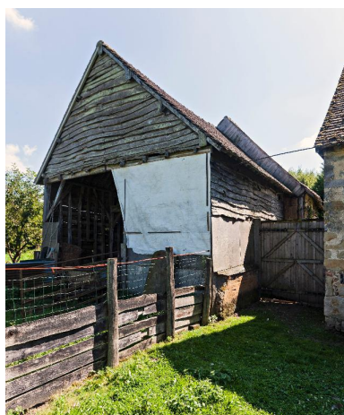
Remise sur poteaux, essentée de planches, de la ferme de La Petite Fortinière. Phot. Yves Guillotin IVR52_20147202027NUCA
