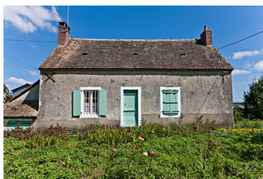
Maçonnerie enduite du logis de la ferme du Petit Tronchet, daté de 1876. Phot. Yves Guillotin IVR52_20147202005NUCA
