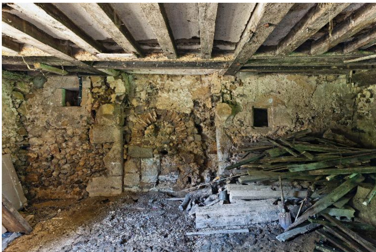
Cheminée de l'ancien logis de la ferme de La Boulaye, XVI e siècle.
