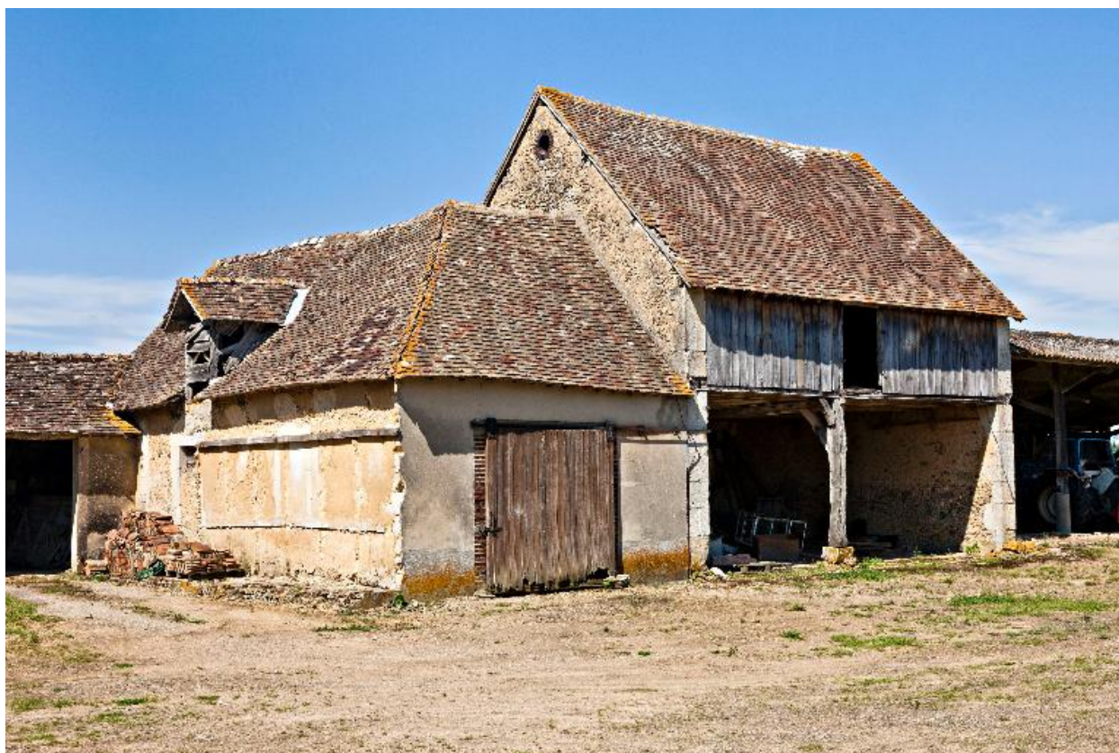
Charretterie en moellons enduits avec chaînes de grès et essentage de planches de la ferme de La Plumardière I.
