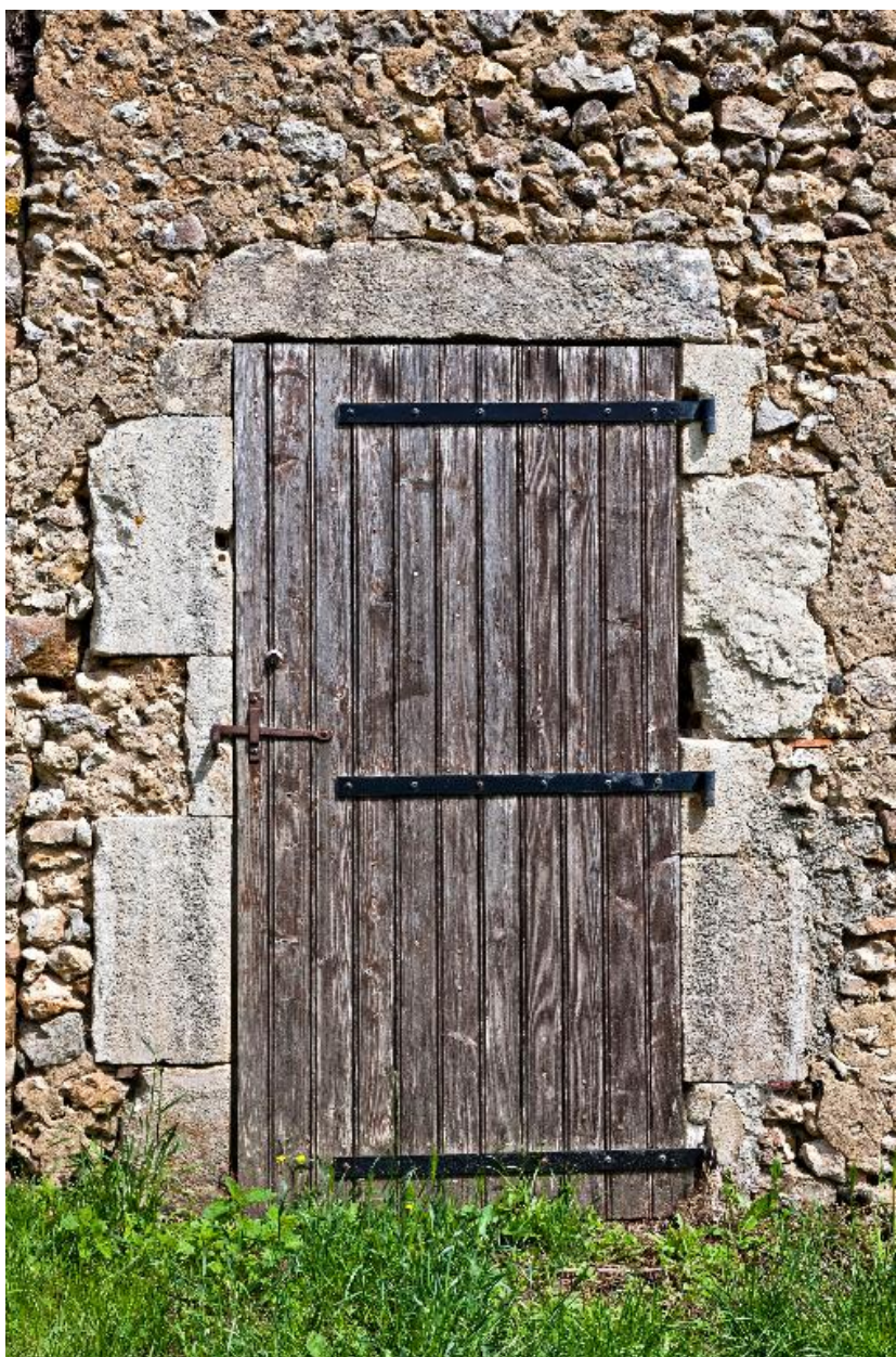
Porte à chambranle de grès de l'écurie de la ferme de la Guillotière.
