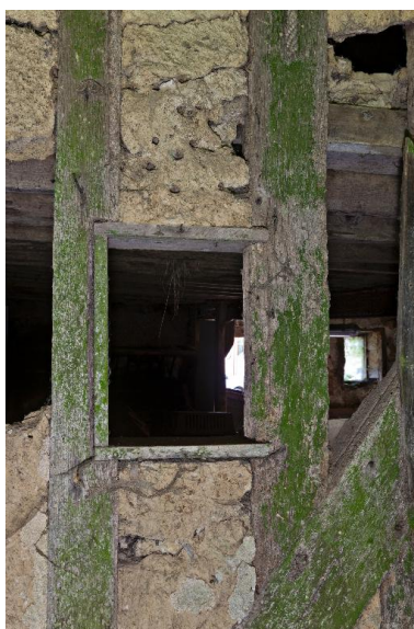
Détail d'une baie. Phot. Yves Guillotin IVR52_20147201864NUCA
