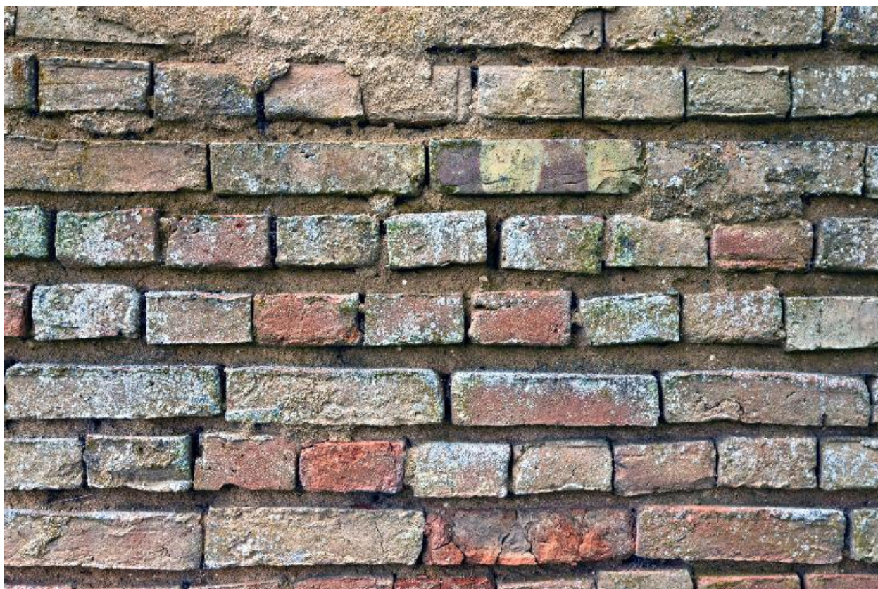
Détail de la maçonnerie de briques enduites.
