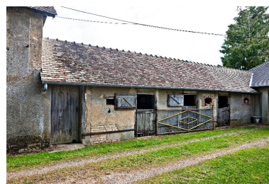
Maçonnerie de briques enduites de la porcherie de la ferme de La Gautrie. Phot. Yves Guillotin IVR52_20147201765NUCA
