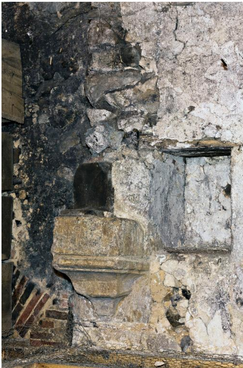
Cheminée de la maison désaffectée de La Plumardière I, 2e moitié du XVIe siècle.
