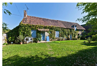
Maçonnerie de moellons enduits et chambranles en pierres de taille du logis de la ferme de La Petite Fortinière. Phot. Yves Guillotin
