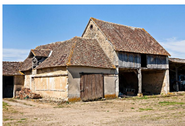
Charretterie en moellons enduits avec chaînes de grès et essentage de planches de la ferme de La Plumardière I. Phot. Yves Guillotin IVR52_20147201704NUCA
