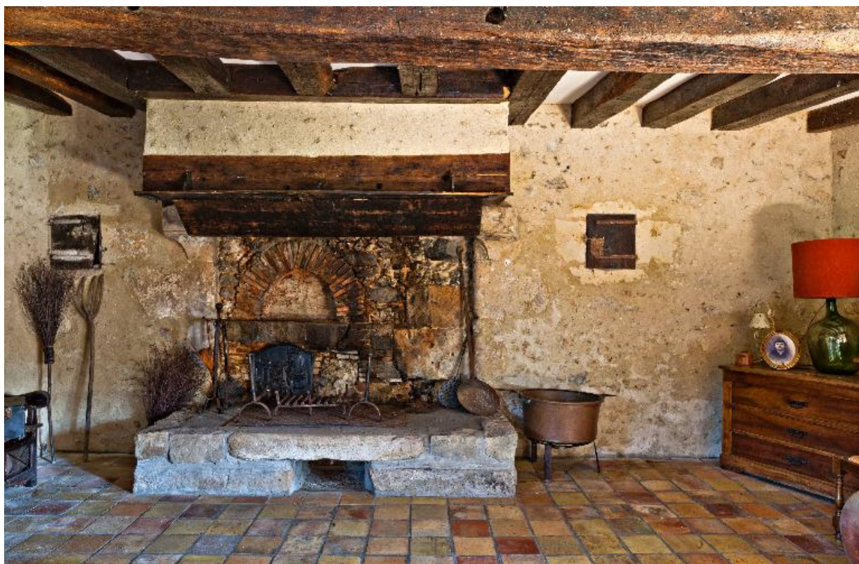
Cheminée du logement de la Plumardière II, limite des XVe et XVIe siècle.
