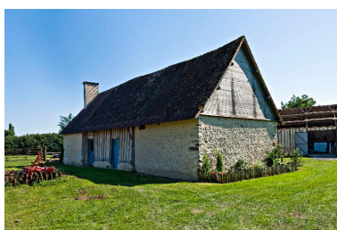
Elévation postérieure en maçonnerie de moellons et en pan-de-bois du logement de La Plumardière II. Phot. Yves Guillotin IVR52_20147201709NUCA
