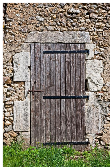
Porte à chambranle de grès de l'écurie de la ferme de la Guillotière. Phot. Yves Guillotin IVR52_20147201783NUCA
