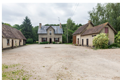
Logis et remise-fournil-porcherie (à droite) en briques enduites de la ferme de La Verrerie. Phot. Yves Guillotin IVR52_20147201787NUCA
