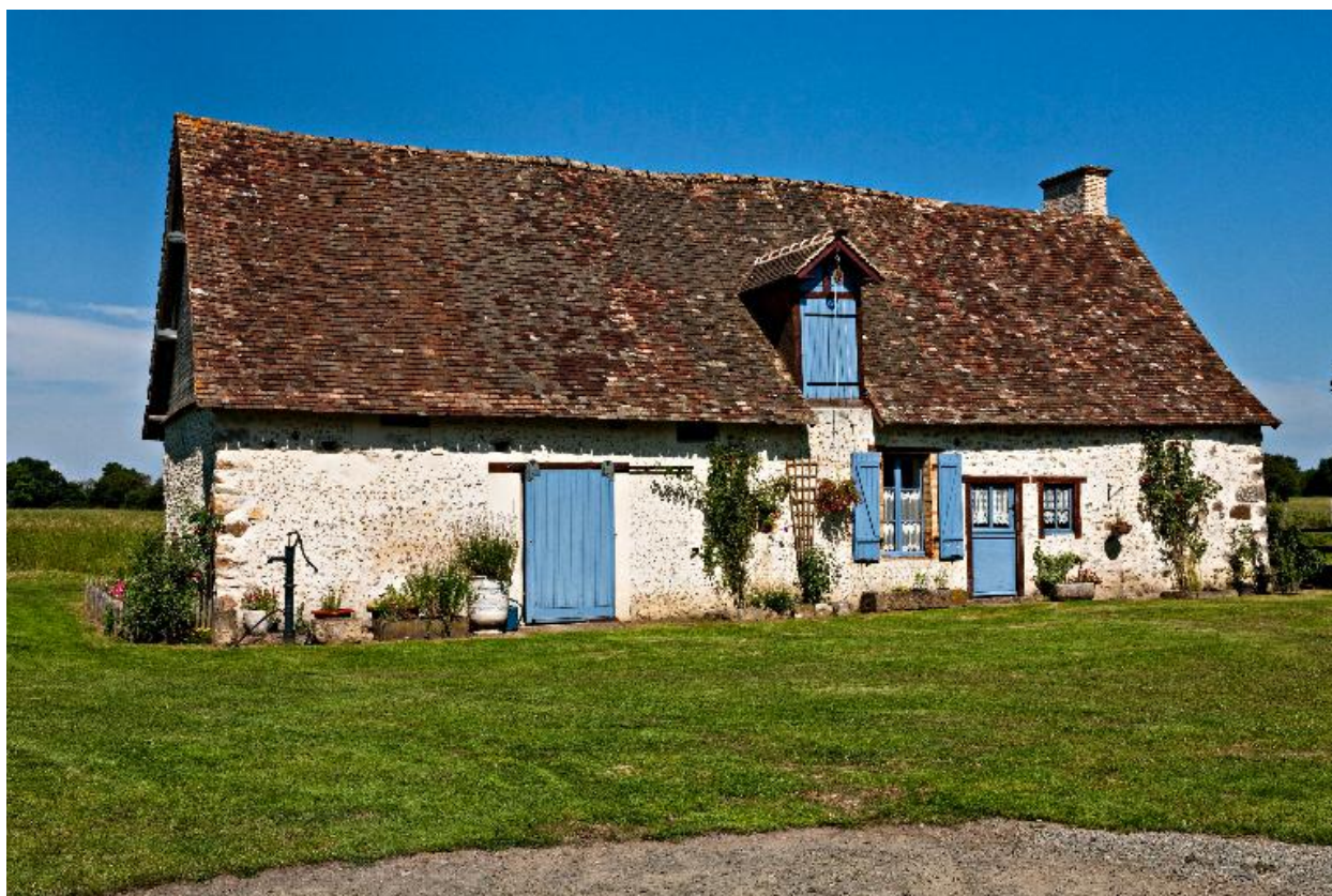
Maçonnerie de moellons enduits, remplaçant un pan-de-bois, du logement de La Plumardière I.
