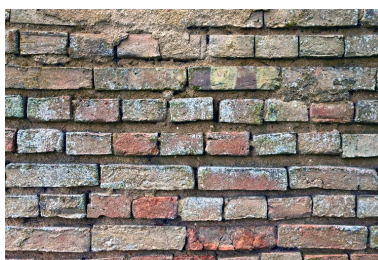
Détail de la maçonnerie de briques enduites. Phot. Yves Guillotin IVR52_20147201768NUCA
