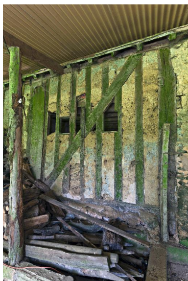
Détail du pan-de-bois de l'ancien logis de la ferme de La Boulaye. Phot. Yves Guillotin IVR52_20147201863NUCA
