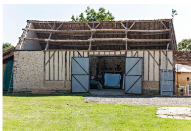
Grange en pan-de-bois de la Ferme de la Plumardière II. Phot. Yves Guillotin IVR52_20147201710NUCA
