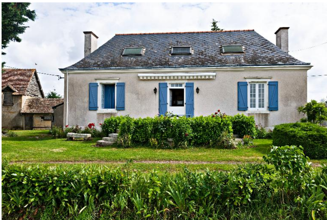
Ferme de la Gautrie. Elévation antérieure du logis construit vers 1902.
