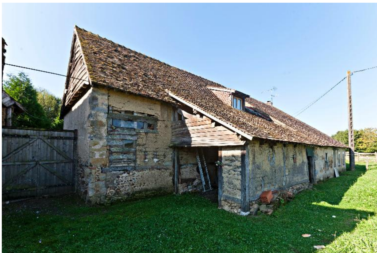
Elévation postérieure en pan-de-bois du logis de la ferme de La Petite Fortinière.
