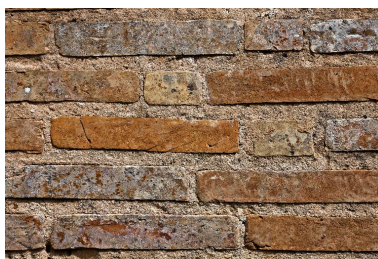
Détail de l'appareillage fait de briques de dimensions exceptionnelles (33 x 17 x 7 cm). Phot. Yves Guillotin IVR52_20147201786NUCA
