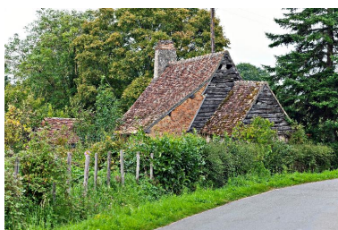
Pignons essentés de planches et maçonnerie de briques du logis de la ferme de la Maladrerie. Phot. Yves Guillotin IVR52_20147202092NUCA
