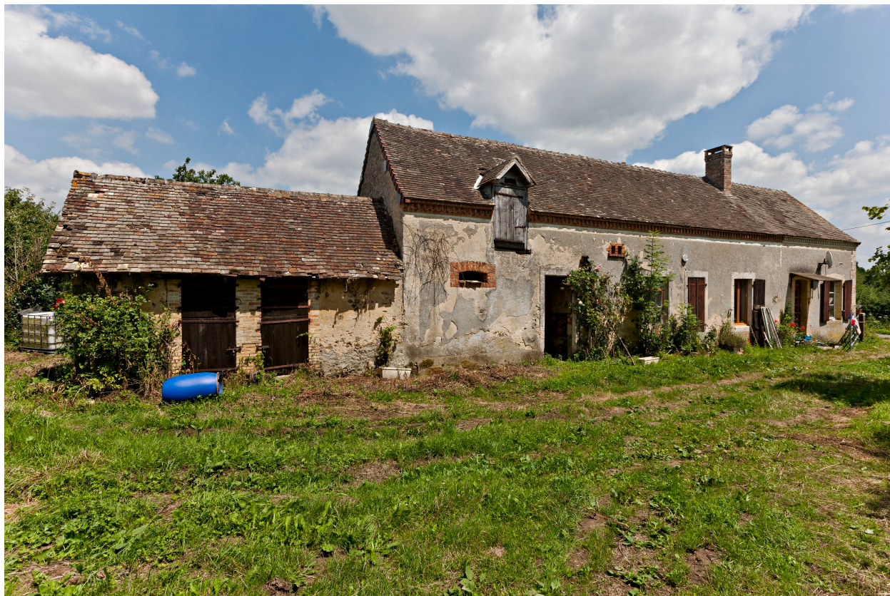
Logis en maçonnerie enduite de la ferme des Noes, construite ex-nihilo vers 1841.
