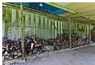
Elévation en pan-de-bois de l'ancien logis de la ferme de la Boulaye. Phot. Yves Guillotin IVR52_20147201862NUCA
