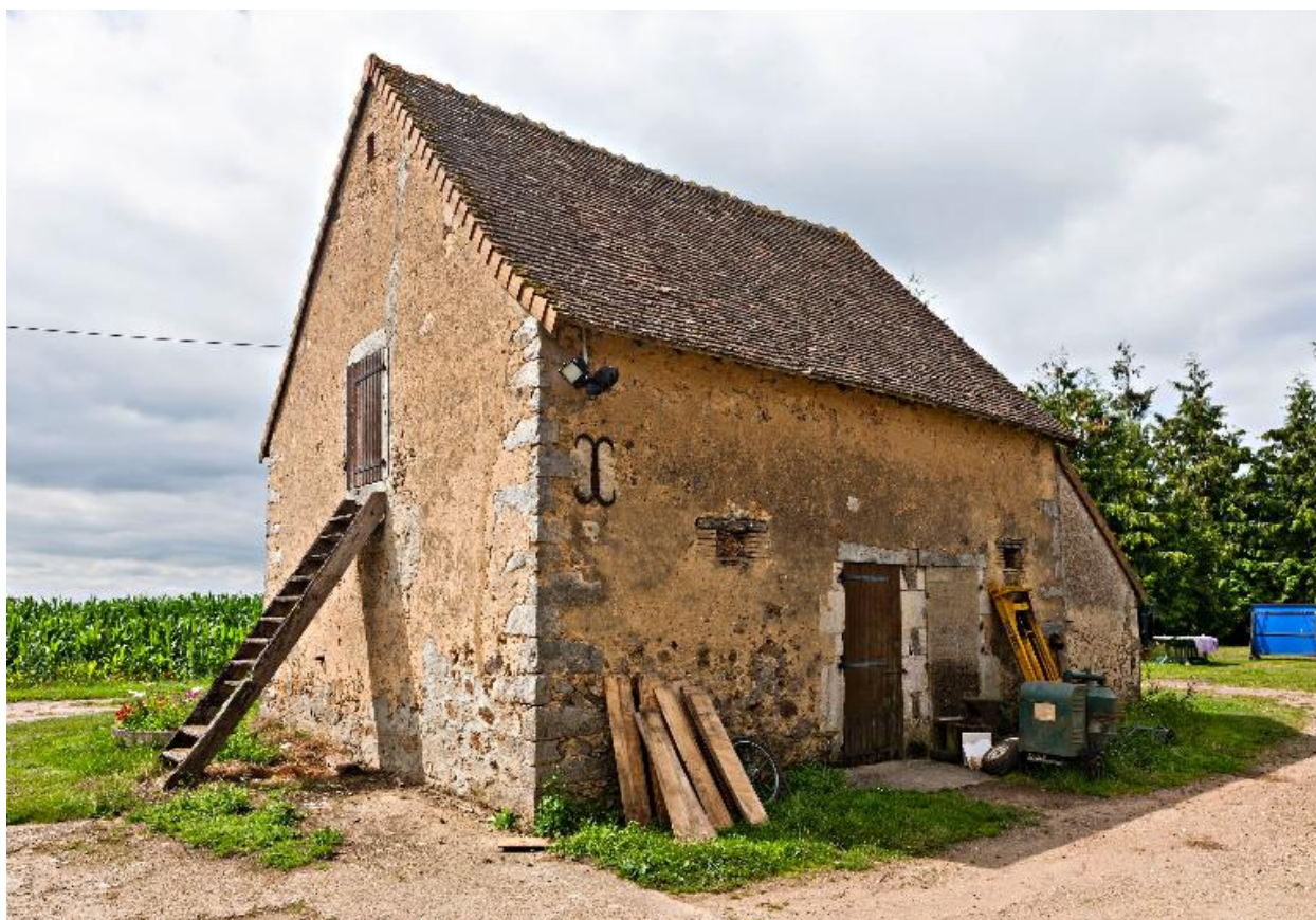
Maconnerie de moellons enduits avec chaînes d'angles de grès de l'écurie de La Guillotière.
