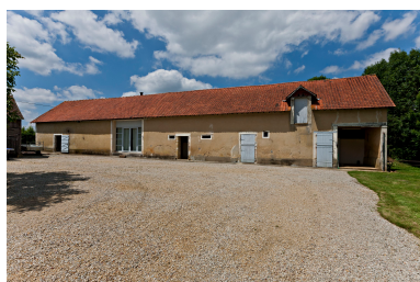
Grange-étable en moellons enduits de la ferme de La Hunaudière, datée de 1926. Phot. Yves Guillotin IVR52_20147201861NUCA
