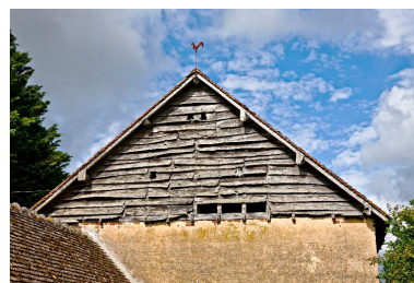
Pignon essenté de planches de la grange-étables de la ferme de la Gautrie. Phot. Yves Guillotin IVR52_20147201769NUCA
