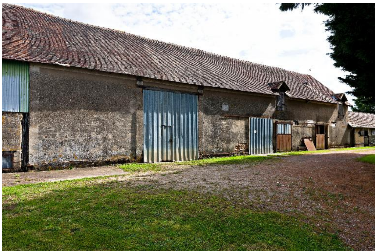
Maconnerie de briques enduites de la grange-étables de la ferme de La Gautrie, datée de 1893.
