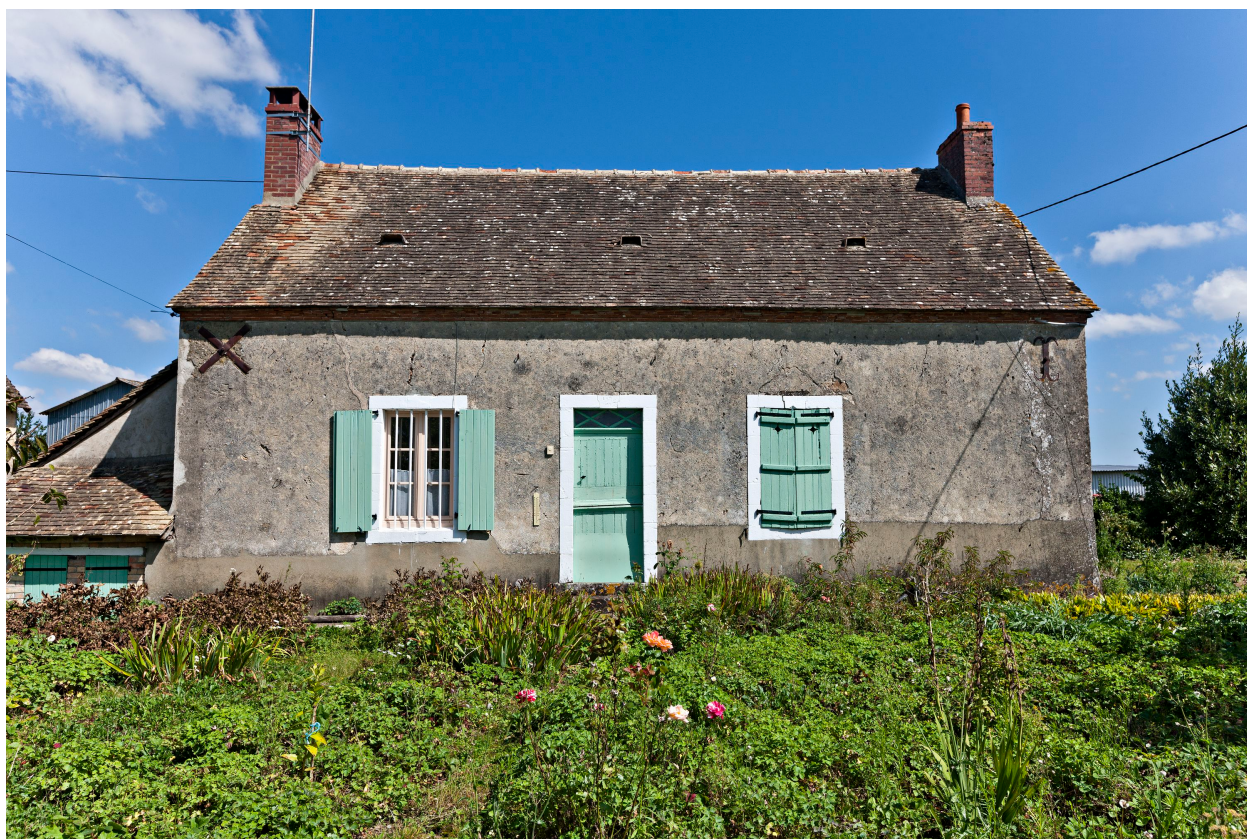
Maçonnerie enduite du logis de la ferme du Petit Tronchet, daté de 1876.
