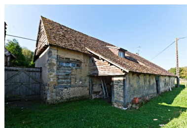
Elévation postérieure en pan-de-bois du logis de la ferme de La Petite Fortinière. Phot. Yves Guillotin IVR52_20147201990NUCA
