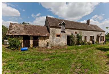
Logis en maçonnerie enduite de la ferme des Noes, construite ex-nihilo vers 1841. Phot. Yves Guillotin IVR52_20147201859NUCA
