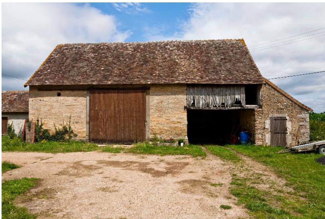
Grange en briques de la ferme de La Guillotière.
