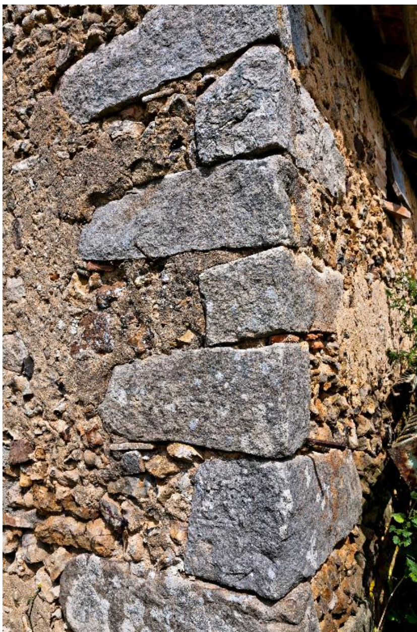
Détail d'une chaîne d'angle en grès.
