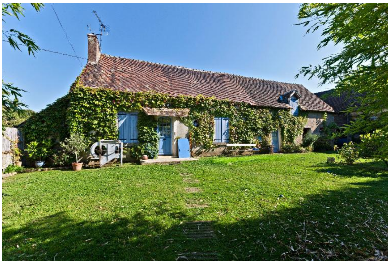
Maçonnerie de moellons enduits et chambranles en pierres de taille du logis de la ferme de La Petite Fortinière.
