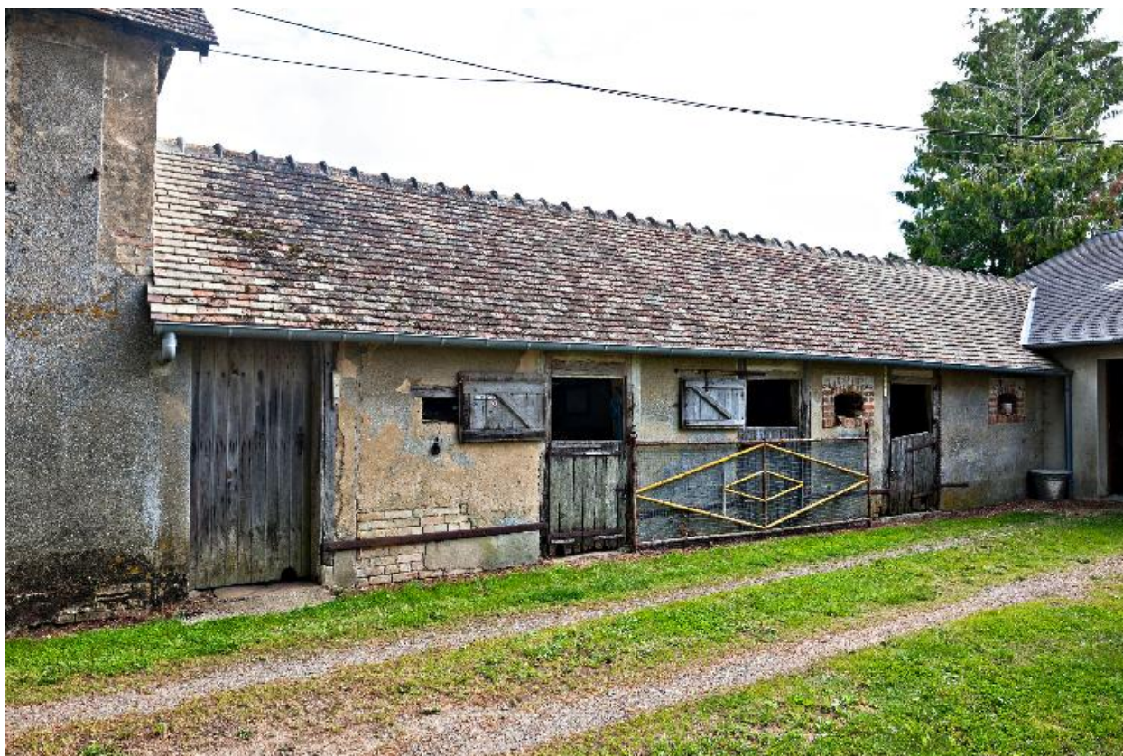
Maçonnerie de briques enduites de la porcherie de la ferme de La Gautrie.
