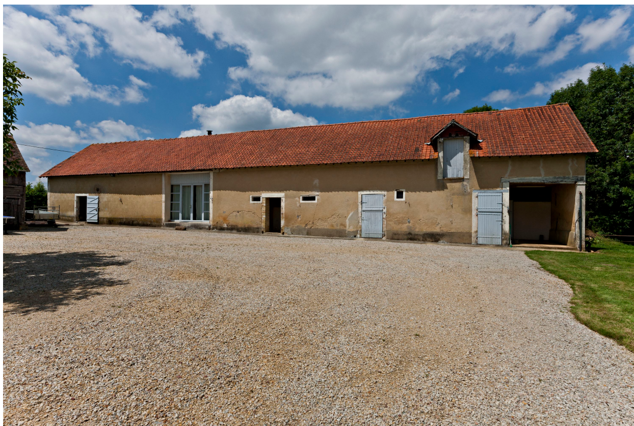
Grange-étable en moellons enduits de la ferme de La Hunaudière, datée de 1926.
