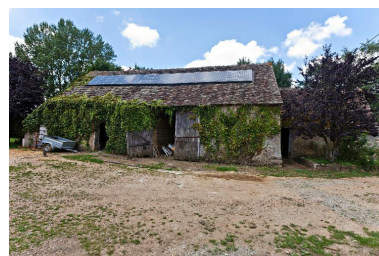
Maçonnerie de moellons enduits de l'élévation antérieure de l'ancien logis de la ferme de La Boulaye, réaffecté en étable (à gauche) et de la grange. Phot. Yves Guillotin IVR52_20147201867NUCA
