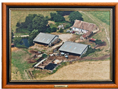
Vue aérienne de la ferme de Guerrespigné en 2003. Phot. Yves Guillotin IVR52_20147201772NUCA
