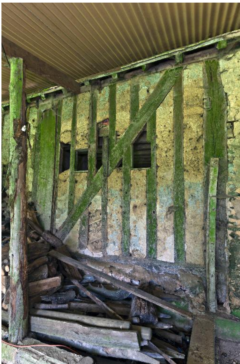
Détail du pan-de-bois de l'ancien logis de la ferme de La Boulaye.
