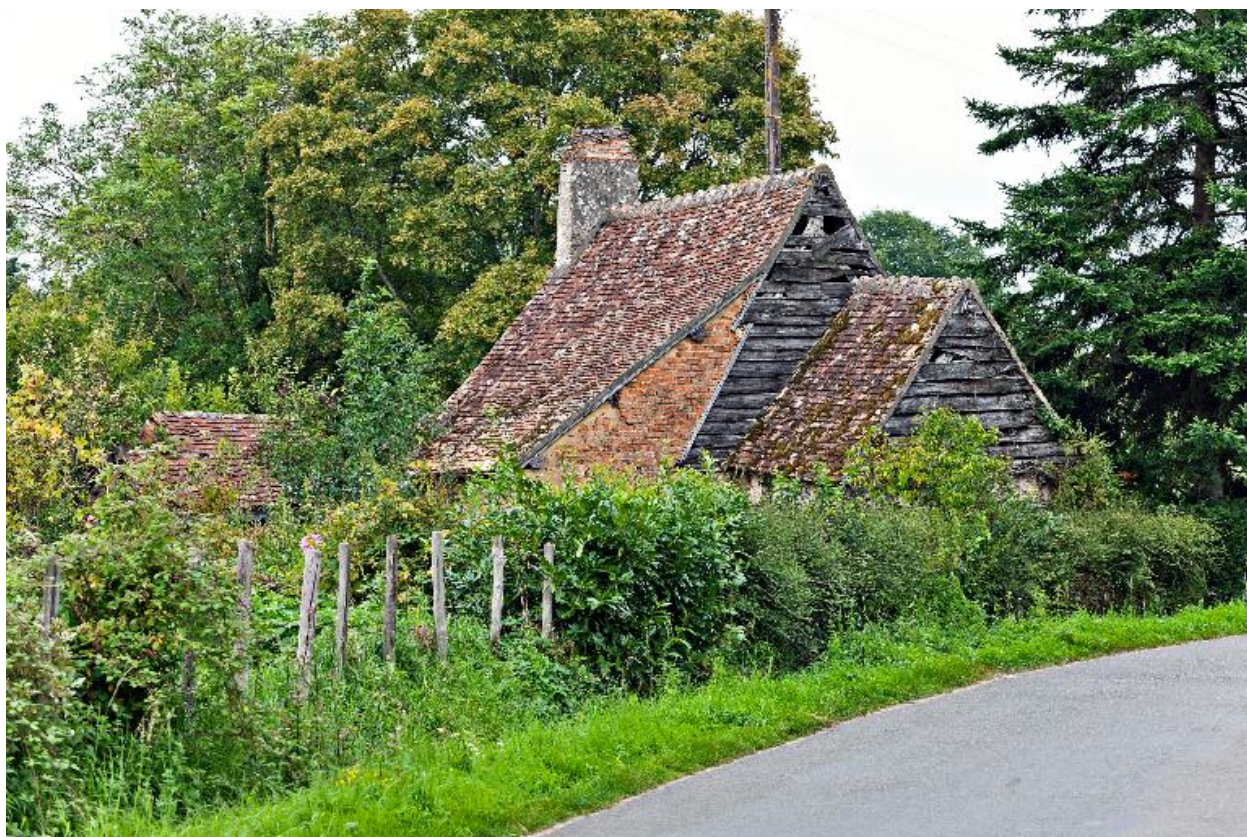
Pignons essentés de planches et maçonnerie de briques du logis de la ferme de la Maladrerie.
