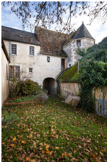
Elévation postérieure Phot. Thierry Seldubuisson IVR52_20237201994NUCA
