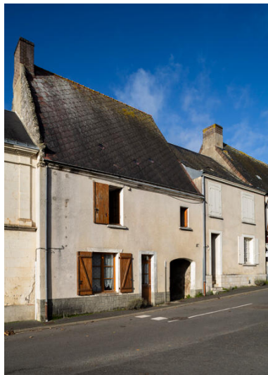
Elévation sur rue. Phot. Thierry Seldubuisson IVR52_20237201986NUCA
