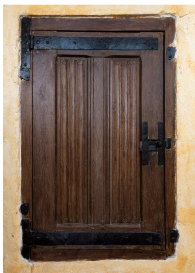
Porte du placard mural de la pièce principale de l'étage. Phot. Thierry Seldubuisson IVR52_20237201990NUCA
