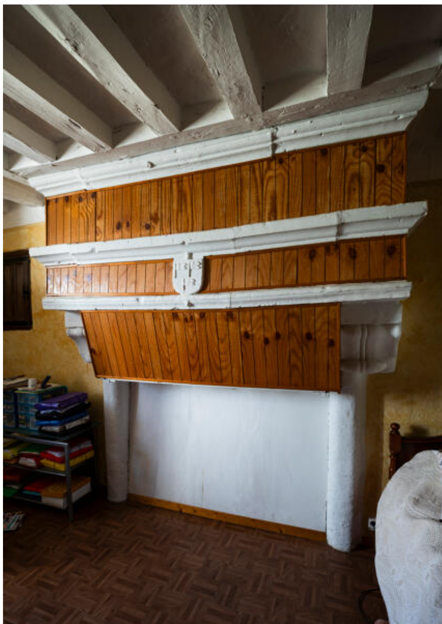
Cheminée de la pièce principale de l'étage
