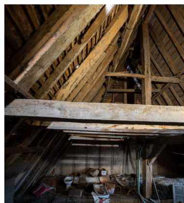
Charpente. Phot. Thierry Seldubuisson IVR52_20237201992NUCA
