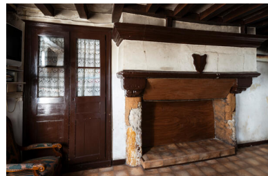
Cheminée de la salle du rez-de-chaussée. Phot. Thierry Seldubuisson IVR52_20237201987NUCA
