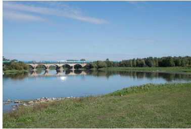
Le pont ferroviaire de Bouchemaine sur la Maine. Phot. Armelle Maugin IVR52_20204900446NUCA
