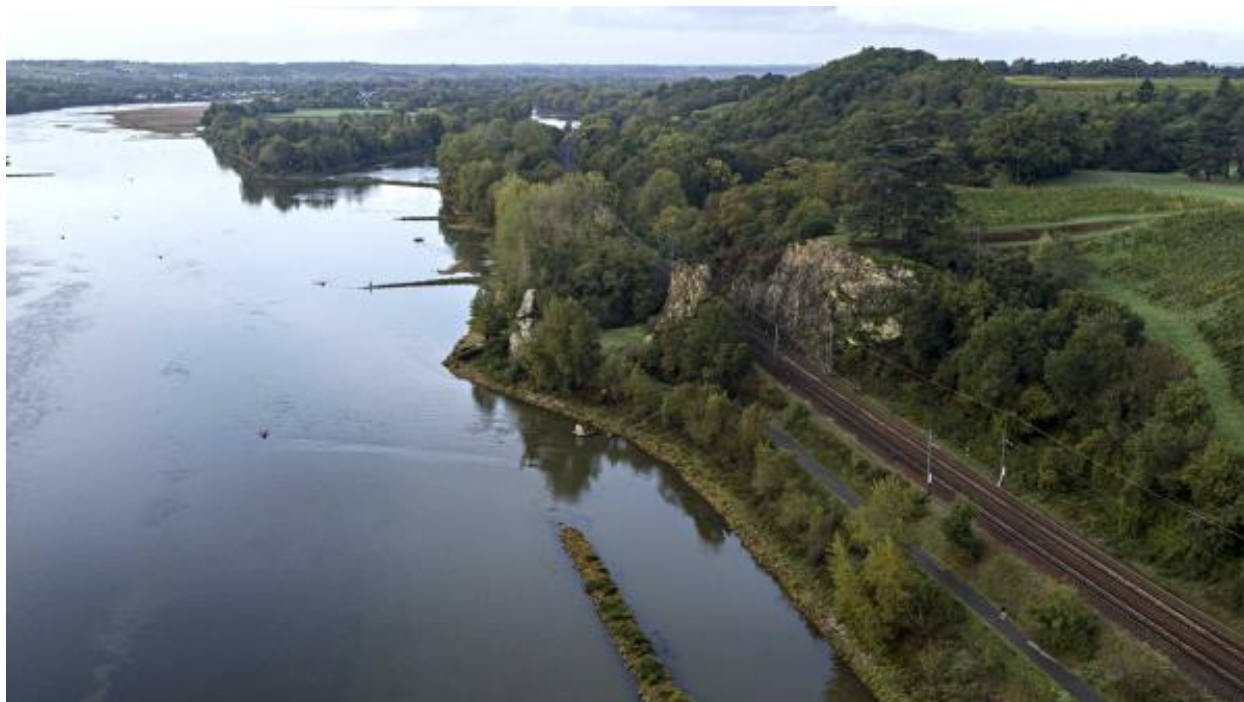
Vue aérienne de la Confluence.
