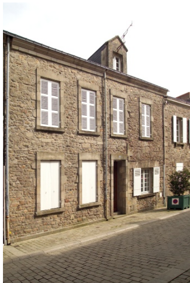
Vue de la façade sur rue. Phot. Denis Pillet IVR52_20074400451NUCA
