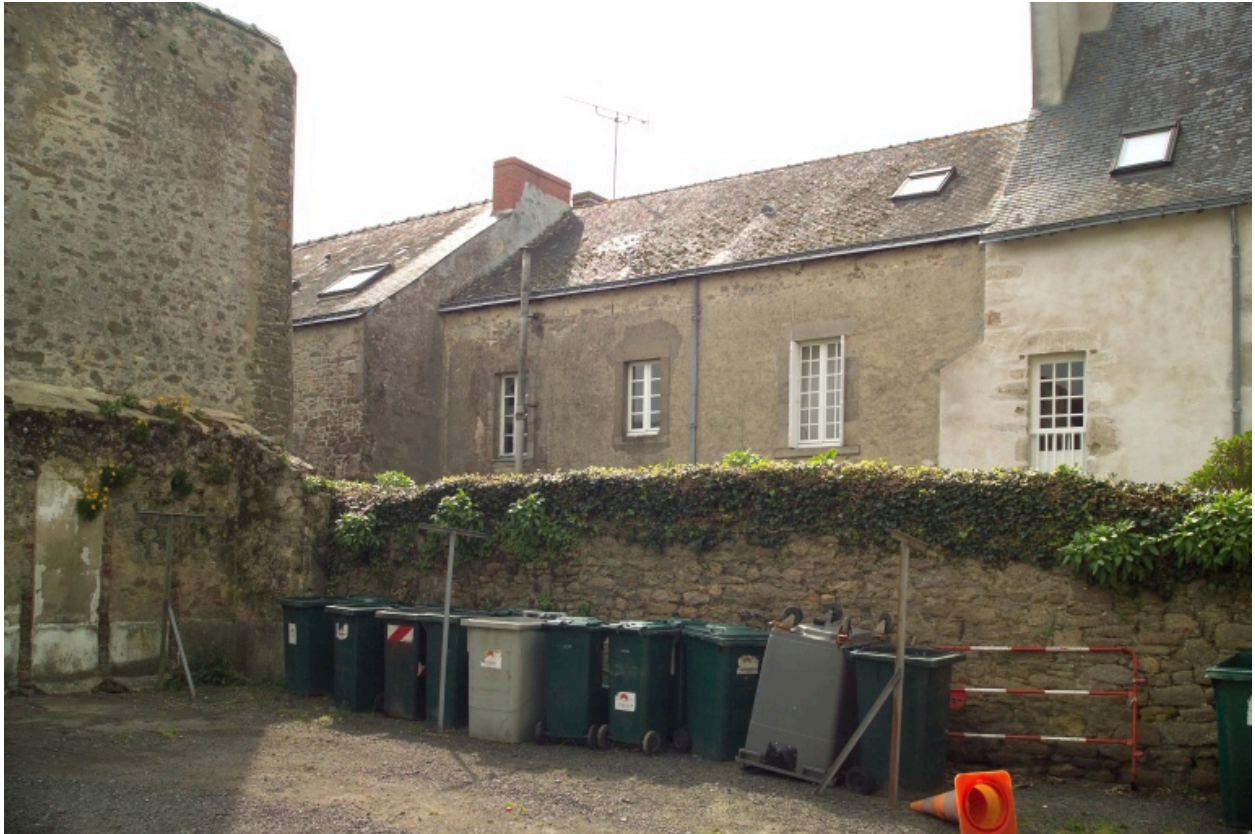
Vue de la façade arrière.
