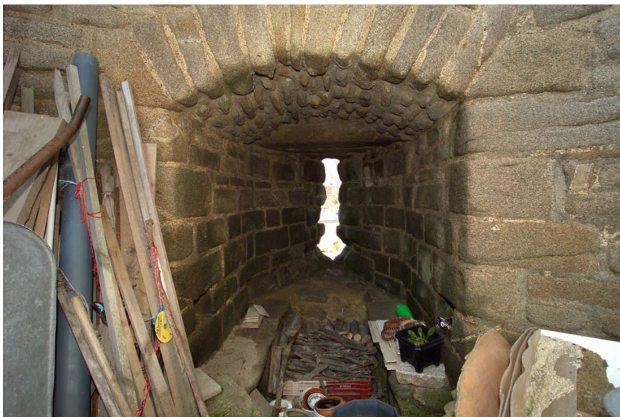
Ouverture de tir au rez-de-chaussée.
