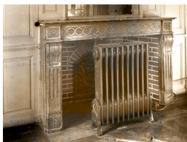
Salon, mur postérieur : cheminée. Phot. François Lasa IVR52_19924901382V
