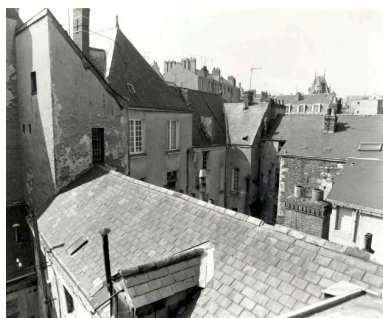
Logis : élévation postérieure, partie droite. Phot. François Lasa IVR52_19914900696X
