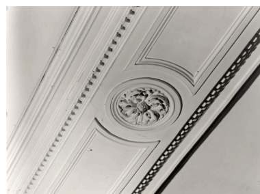
Salon, plafond : détail de la poutre. Phot. François Lasa IVR52_19924901419X
