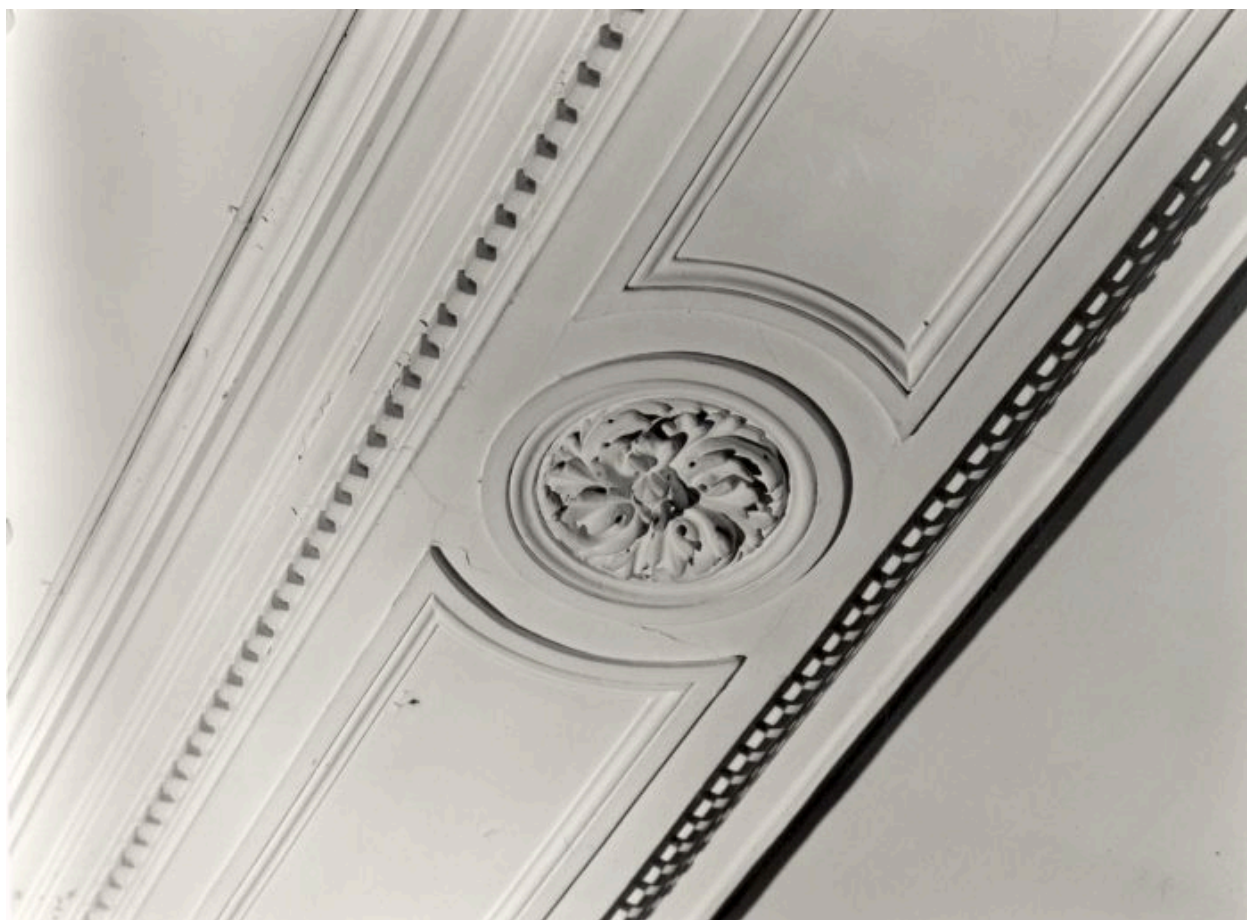
Salon, plafond : détail de la poutre.
