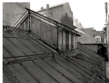
Bâtiment en rez-de- chaussée : vue partielle de la couverture, partie postérieure. Phot. François Lasa IVR52_19924901423X
