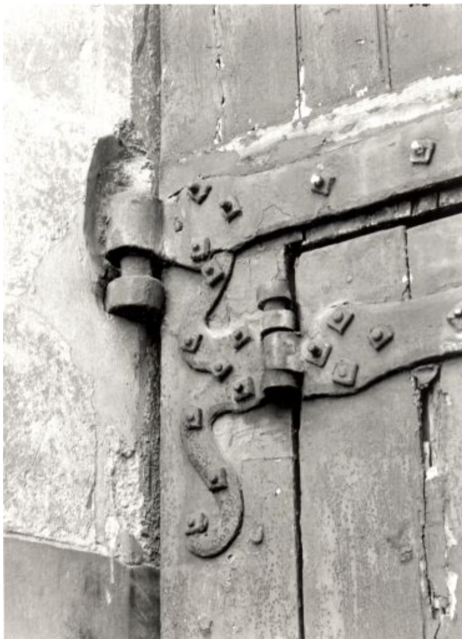
Portail, élévation postérieure : détail d'une penture.
