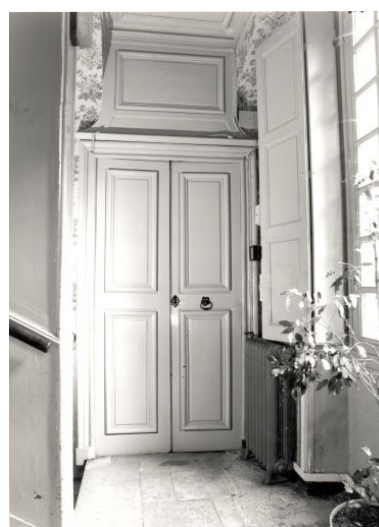
Cage d'escalier : palier du premier étage, angle antérieur droit, avec la porte desservant le pavillon. Phot. François Lasa IVR52_19924901424X
