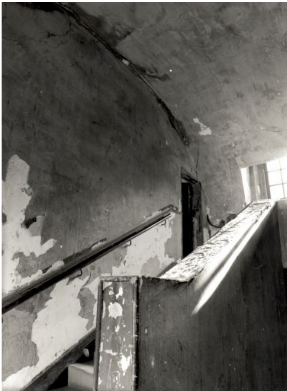
Cage d'escalier : le couvrement.
