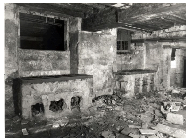
Corps de logis droit, sous-sol, mur antérieur : vue d'ensemble des deux potagers. Phot. François Lasa IVR52_19924901421X
