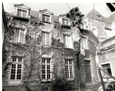
Logis : élévation antérieure, sur la cour. Phot. François Lasa IVR52_19934900338X
