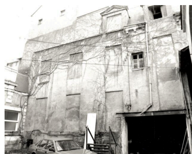
Aile des communs, élévation sur cour. Phot. François Lasa IVR52_19934900337X
