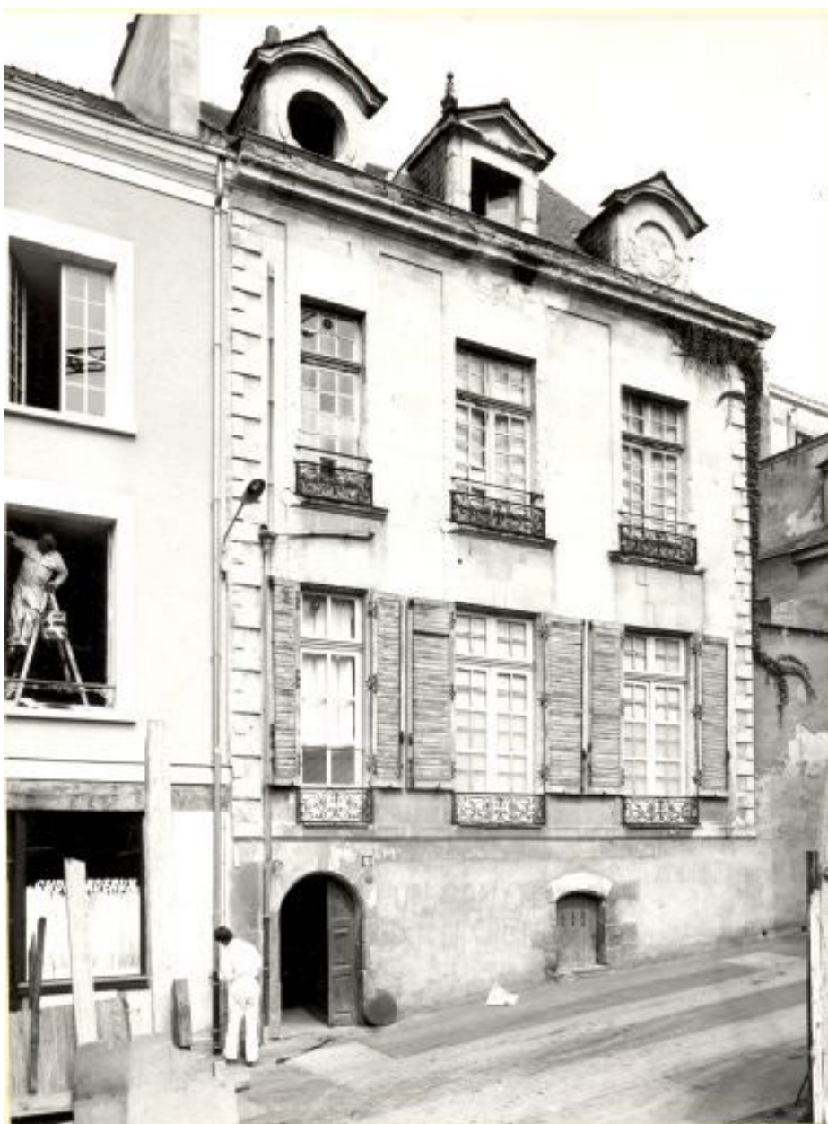
Corps principal, élévation latérale gauche.
