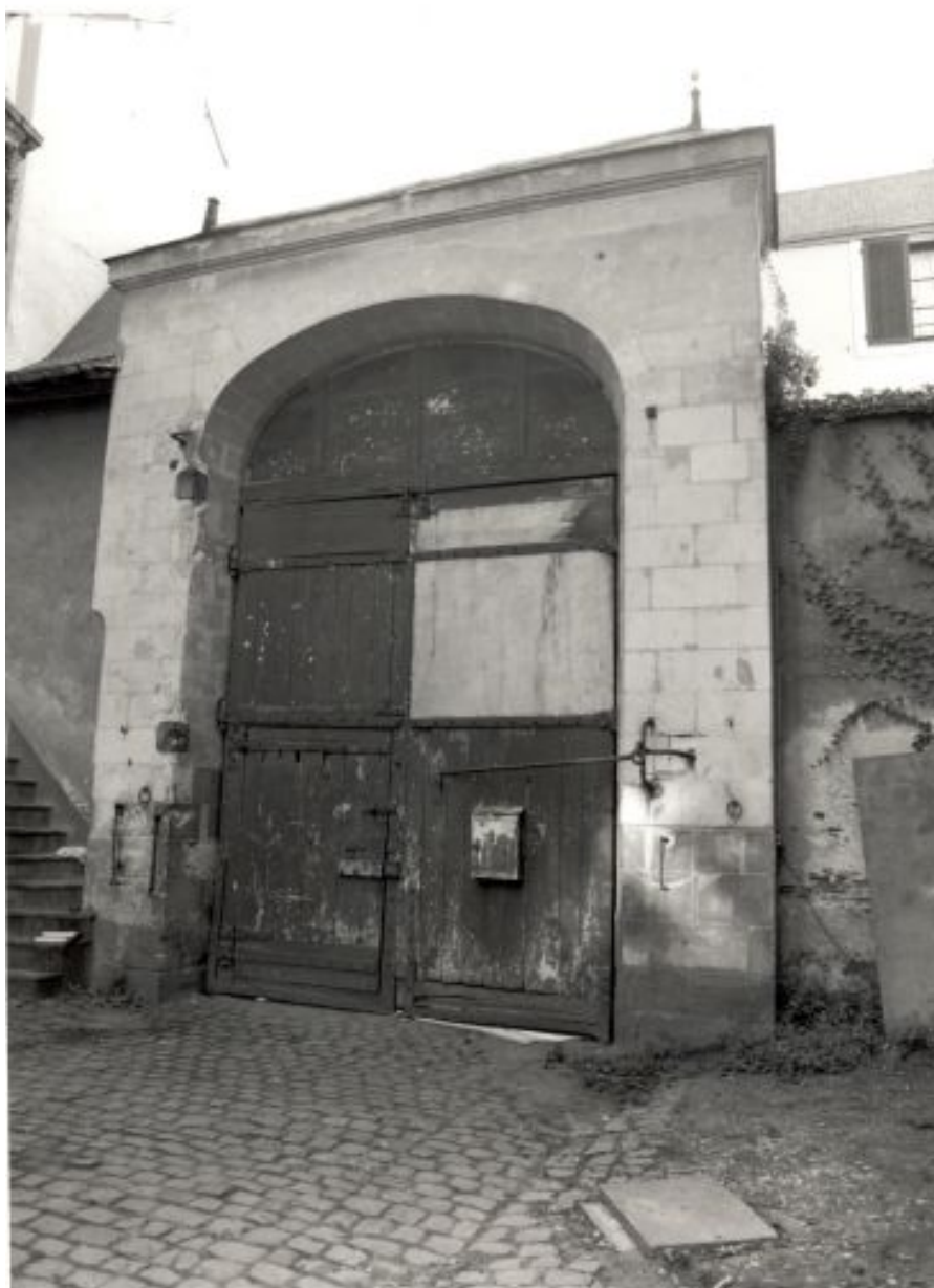
Portail : élévation postérieure.
