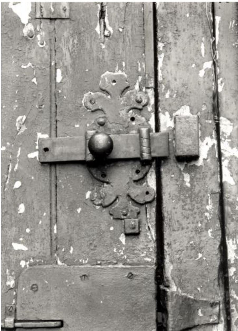
Portail, élévation postérieure : la targette.
