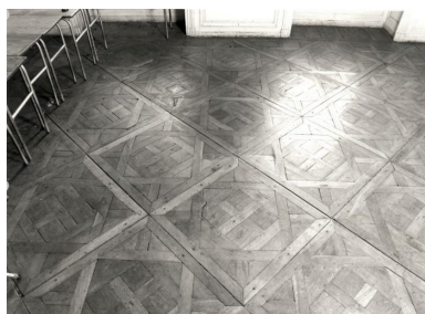
Salon : parquet, vue partielle. Phot. François Lasa IVR52_19924901415X
