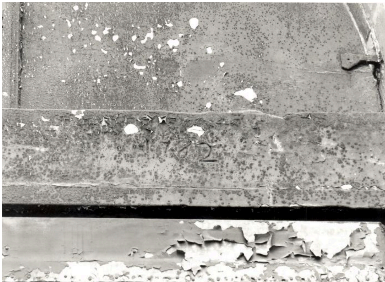
Portail, élévation postérieure, traverse d'imposte : date gravée 1782.
