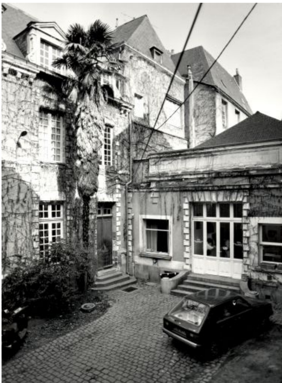
Logis : élévation antérieure (sur la cour), partie droite.
