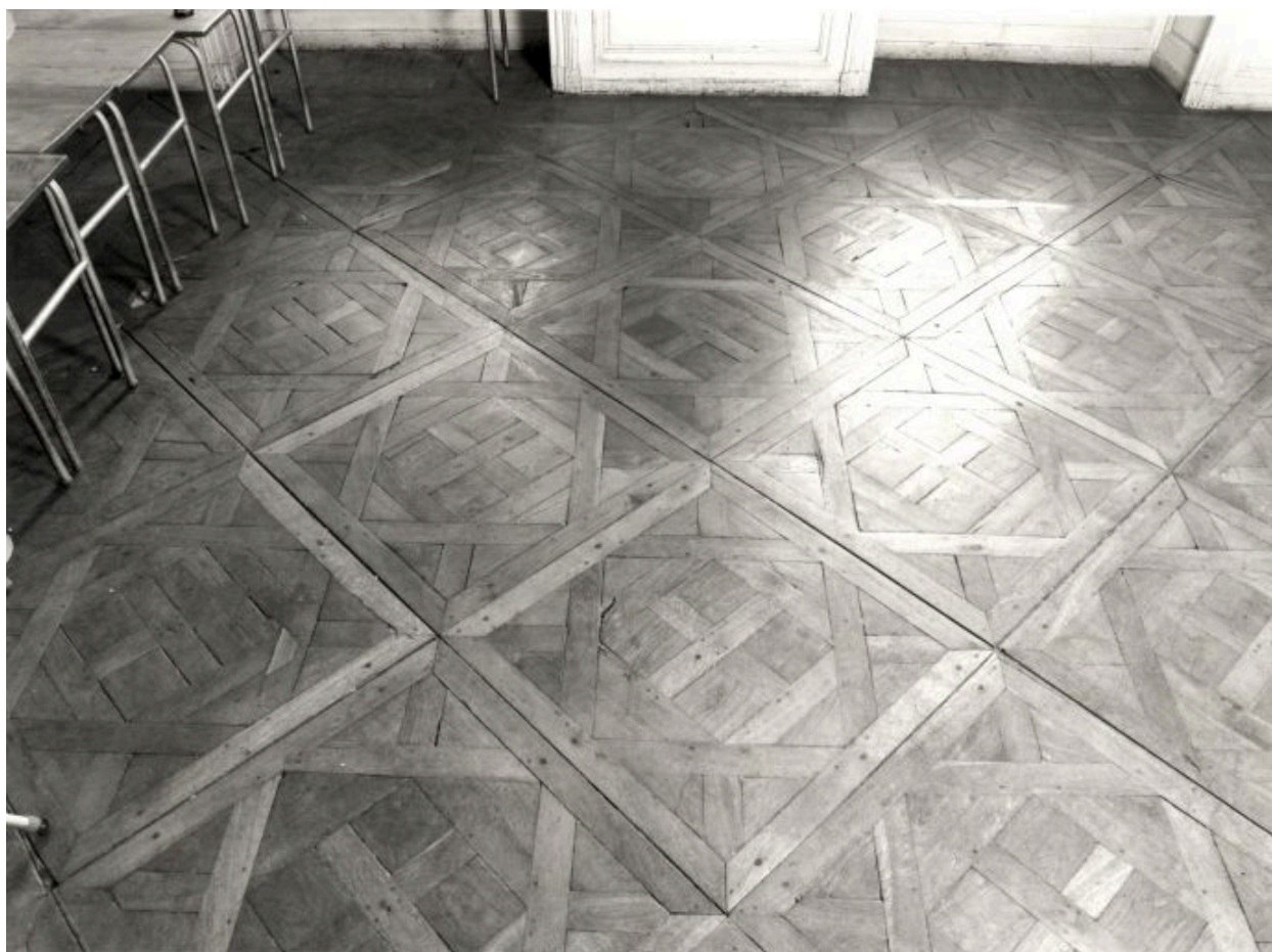
Salon : parquet, vue partielle.
