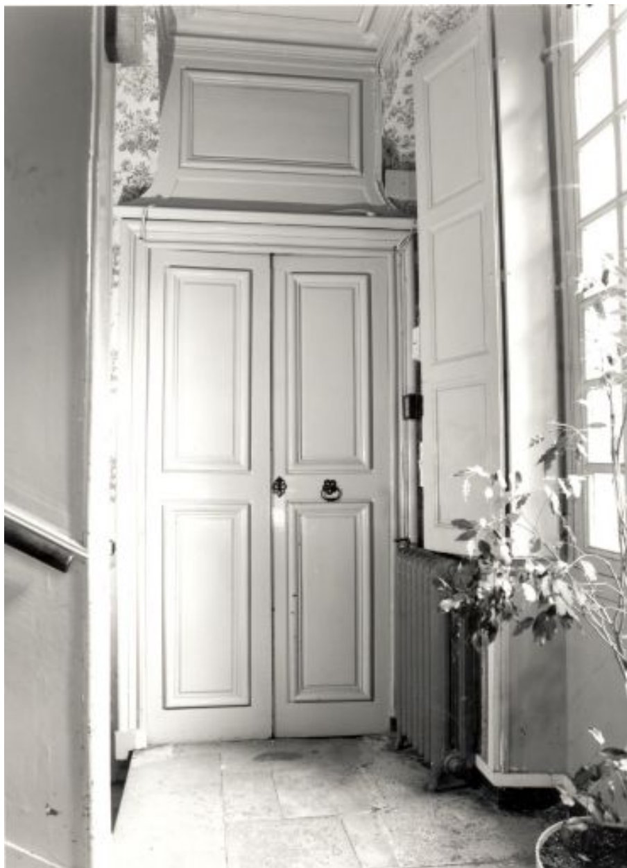
Cage d'escalier : palier du premier étage, angle antérieur droit, avec la porte desservant le pavillon.
