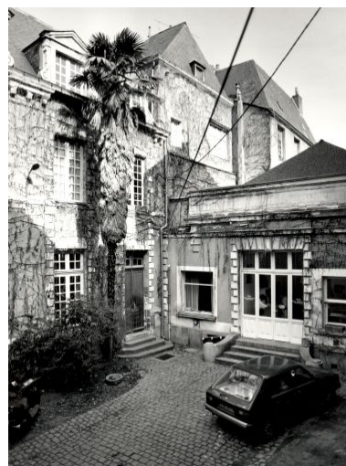
Logis : élévation antérieure (sur la cour), partie droite. Phot. François Lasa IVR52_19924900262X
