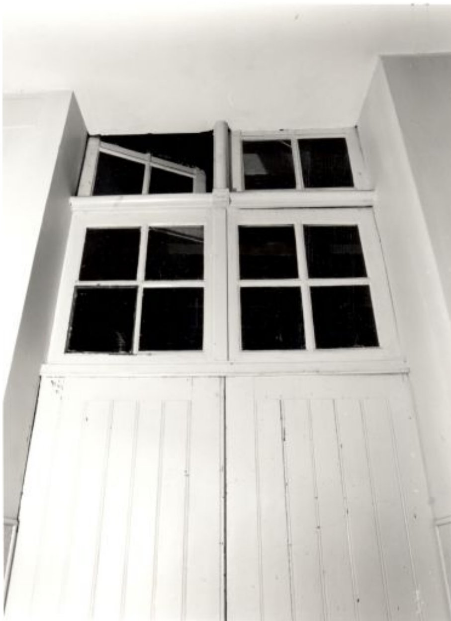
Corps de logis droit, rez-de-chaussée : vestige d'une des fenêtres antérieures.
