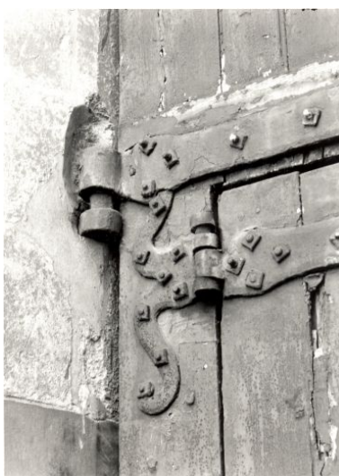
Portail, élévation postérieure : détail d'une penture. Phot. François Lasa IVR52_19924901407X
