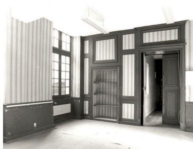
Corps de logis droit : pièce gauche du premier étage, angle antérieur gauche. Phot. François Lasa IVR52_19924901426X
