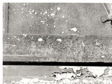
Portail, élévation postérieure, traverse d'imposte : date gravée 1782. Phot. François Lasa IVR52_19924901408X
