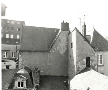
Logis : élévation postérieure, partie gauche. Phot. François Lasa IVR52_19914900698X
